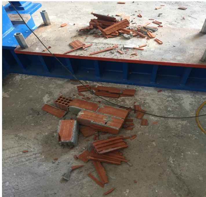
Εικόνα 5-14: Αστοχία τοίχου T4 κατά τον προσδιορισμό του μέγιστου θλιπτικού φορτίου
