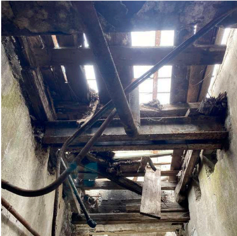
Εικόνα 204 : Κενό στο άνω δάπεδο από την αφαίρεση μηχανής ντίζελ και πρόχειρη κάλυψη με ξύλα υπό κατάρρευση
