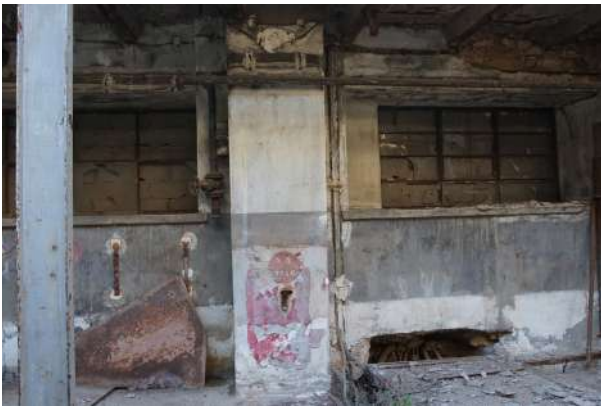
Εικόνα 171 : Άνοιγμα κατώτερης στάθμης πληρωμένο μετσιμεντόλιθο, ΚΤΑ
