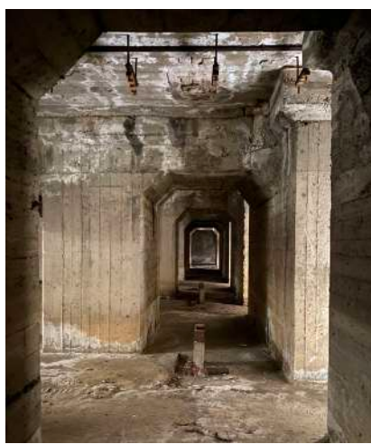
Εικόνα 202 : Κατώτερη στάθμη ΚΤΓ
