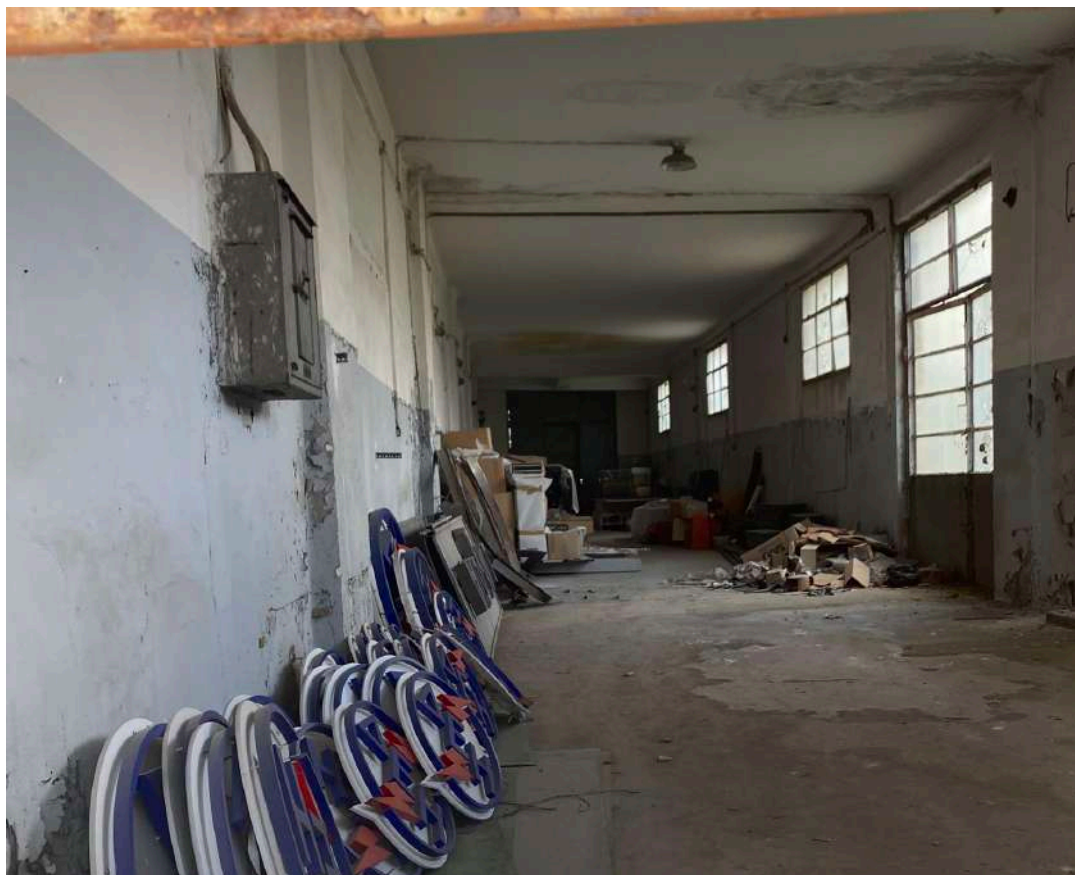
Εικόνα 224 :Εσωτερικό προσκτίσματος Γ Πηγή : Αρχείο ομάδας μελέτης, 2021-2022
