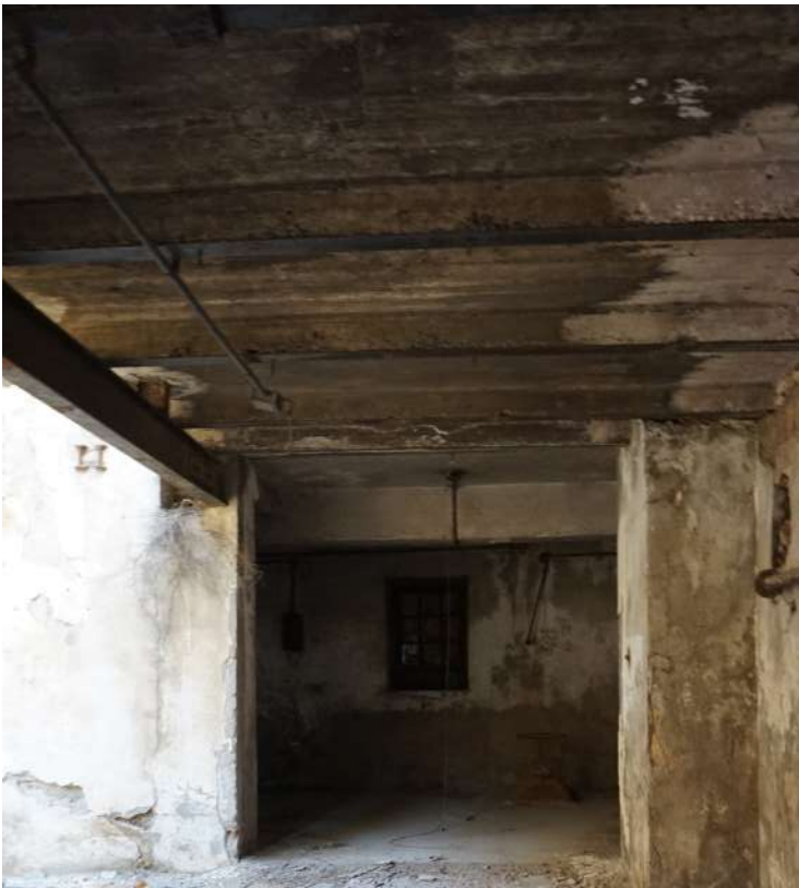
Εικόνα 126 : Δάπεδο με μεταλλικές δοκούς εγκιβωτισμένες σε σκυρόδεμα, σύμμικτη κατασκευή, ΚΤΑ
