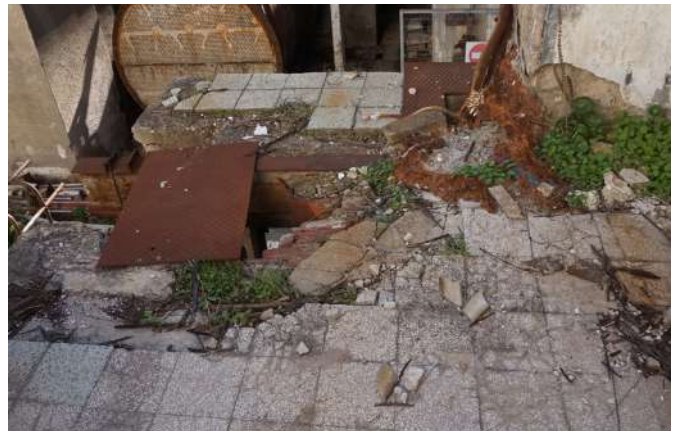
Εικόνα 142 :Δάπεδο άνω στάθμης με μαρμάρινα πλακίδια, σκυροδέματος και μεταλλικού πλαισίου και οπές στις πρώην θέσεις ντιζελομηχανών, ΚΤΑ
