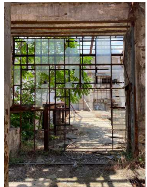
Εικόνα 168 :Μεταλλικό κούφωμα και βαλοπίνακες, εσωτερικό άνοιγμα, ΚΤΑ - ΚΤΒ Πηγή : Αρχείο ομάδας μελέτης, 2021-2022
