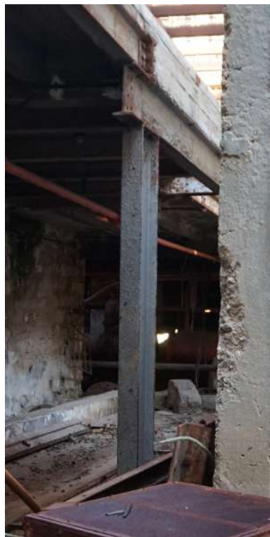
Εικόνα 124 : Σύμμικτη κατασκευή, ΚΤΑ
