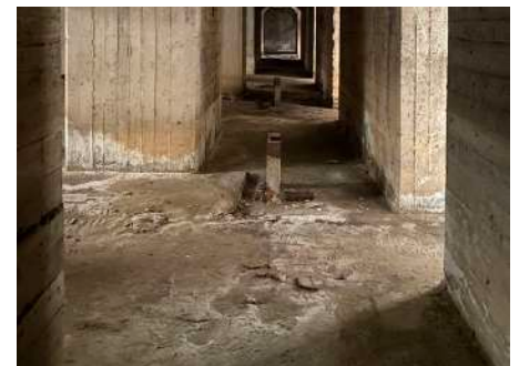
Εικόνα 147 :Πατητή τσιμεντοκονία κάτω στάθμης, ΚΤΓ
