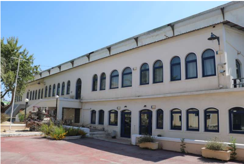
Εικόνα 31 : Πρόσκτισμα Α Πηγή : ομάδα μελέτης, 2021
