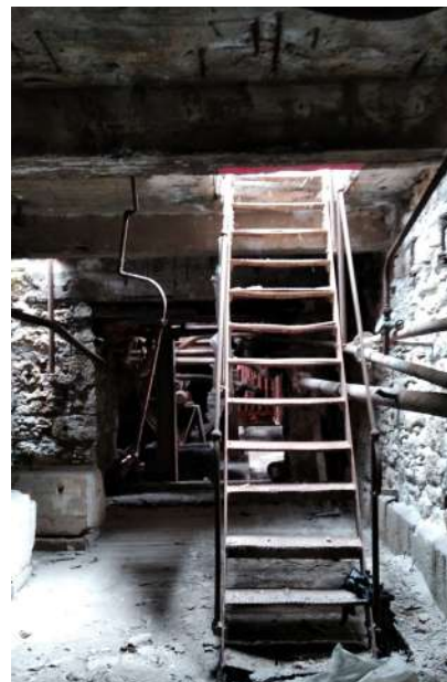
Εικόνα 180 :Μεταλλική κλίμακα χωρίς ρίχτι και αναβαθμοί από μπετόν αριστερά της, ΚΤΒ
