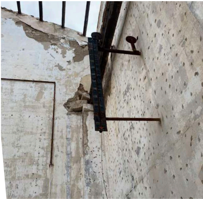
Εικόνα 197 :Αποκόλληση επιχρίσματος, εσωτερική άποψη βορειου τοίχου ΚΤΑ
