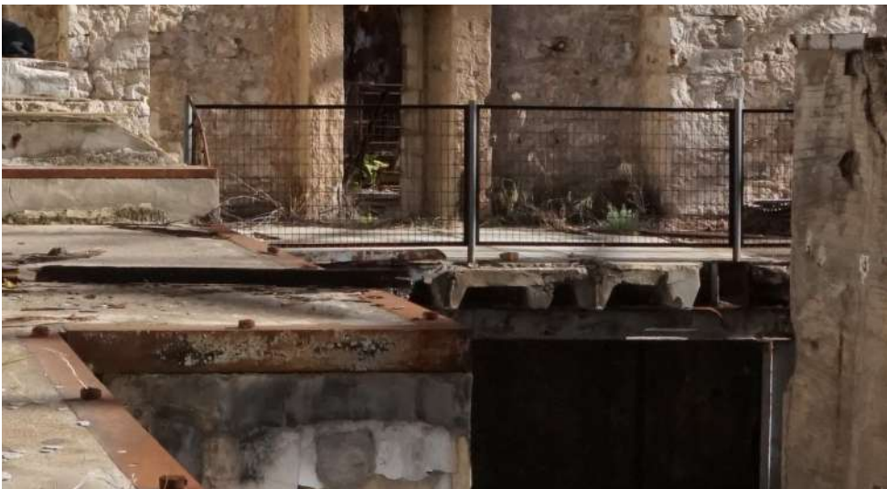
Εικόνα 127 : Δάπεδο με μεταλλικές δοκούς εγκιβωτισμένες σε σκυρόδεμα, σύμμικτη κατασκευή, ΚΤΑ
