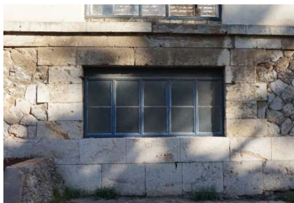
Εικόνα 161 :Ανοίγμα υπογείου δυτικής όψης ΚΤΑ με λαξευτούς λίθινους λαμπάδες
