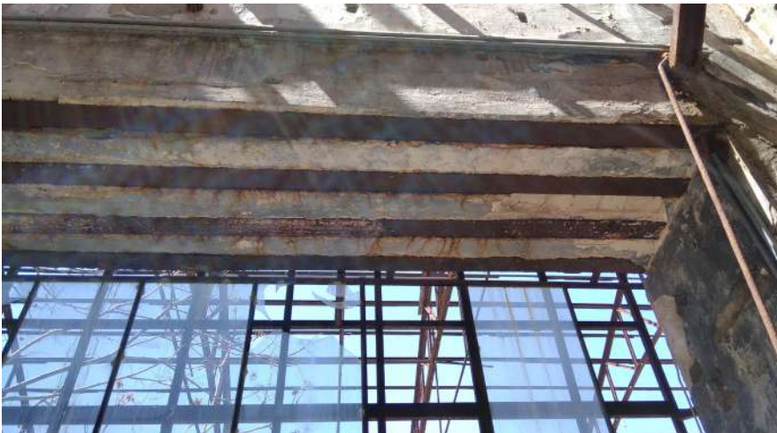
Εικόνα 157 :Εσωτερικό άνοιγμα μεταξύ με γεφύρωση με ευθύγραμμες δοκούς, ΚΤΑ - ΚΤΒ
