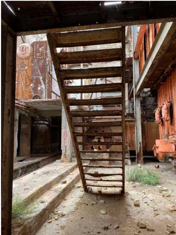
Εικόνα 216 :Εσωτερική μεταλλική οξειδωμένη κλίμακα, κάτω στάθμη, ΚΤΒ
