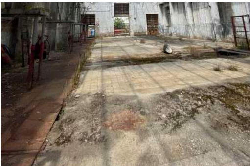
Εικόνα 148 :Δάπεδο άνω στάθμης με συνδυασμό πλακιδίων, σκυροδέματος και μεταλλικού πλαισίου και οπές με ξύλινες σανίδες στις πρώην θέσεις ντιζελομηχανών, ΚΤΓ
