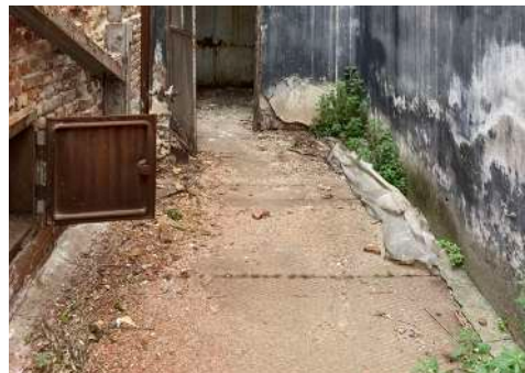
Εικόνα 149 :Δάπεδο άνω στάθμης με επίστρωση λαμαρίνας στο πλάι λέβητα Babcock & Willcox, ΚΤΓ
