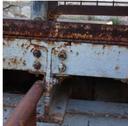
Εικόνα 136 : Δάπεδο με μεταλλικές δοκούς επί μεταλλικών υποστηλωμάτων, ΚΤΑ
