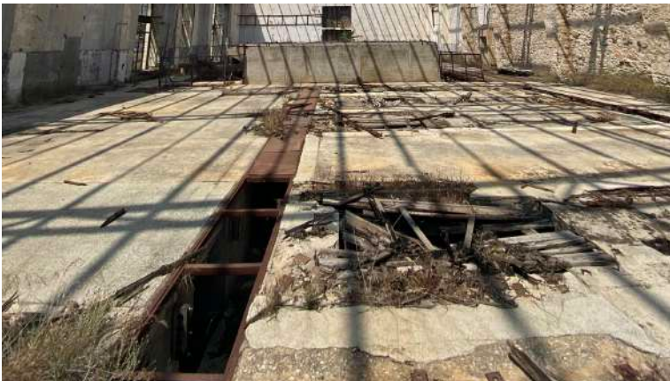
Εικόνα 138 :Δάπεδο άνω στάθμης με συνδυασμό πλακιδίων, σκυροδέματος και μεταλλικού πλαισίου και οπές με ξύλινες σανίδες στις πρώην θέσεις ντιζελομηχανών, ΚΤΑ
