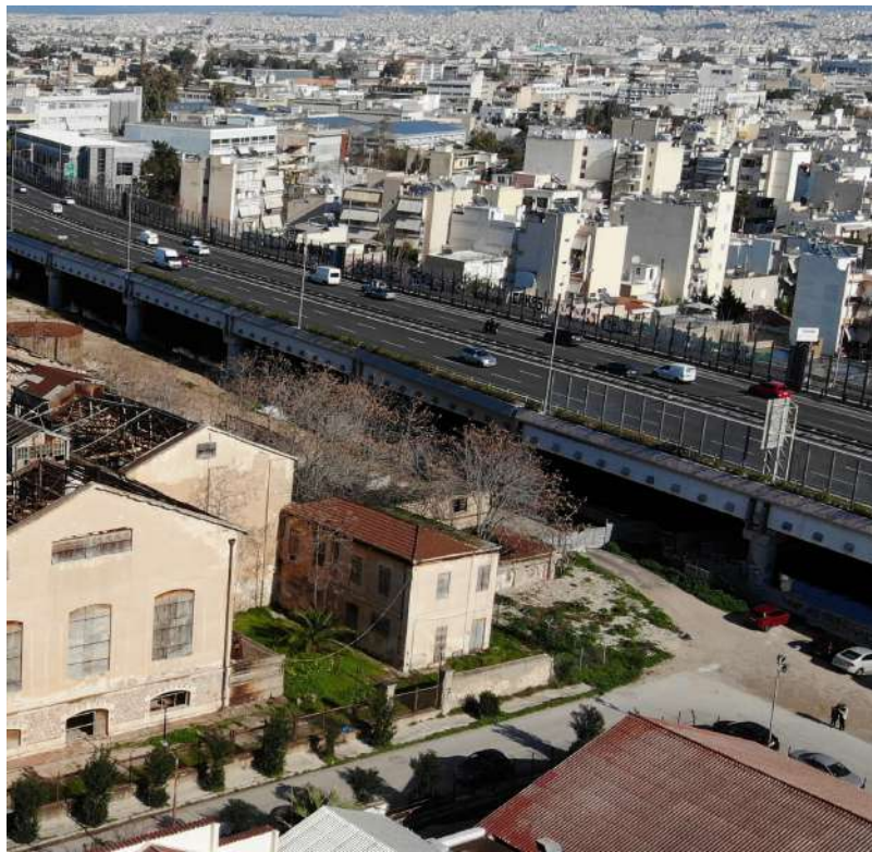
Εικόνα 225 :Νότια και δυτική όψη κτιρίου Η Πηγή : Αρχείο ομάδας μελέτης, 2021-2022
