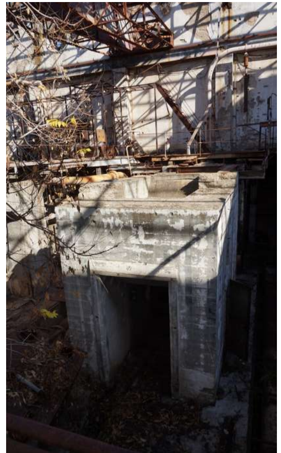
Εικόνα 109 : Μπετονένιο βάθρο μηχανής ΚΤΑ, θέση Α Πηγή : Αρχείο ομάδας μελέτης, 2021-2022
