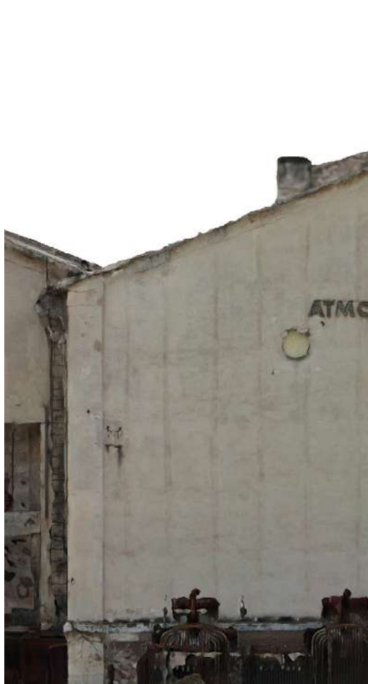
Εικόνα 194 :Βόρεια Όψη, Αποχρωματισμός επιχρίσματος από υγρασία, ΚΤΑ
