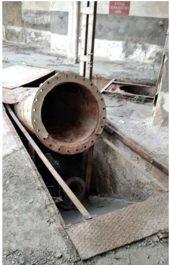
Εικόνα 106 : Βάθος θεμελίωσης από βύθιση για αγωγό, ΚΤΑ Πηγή : Αρχείο ομάδας μελέτης, 2021-2022
