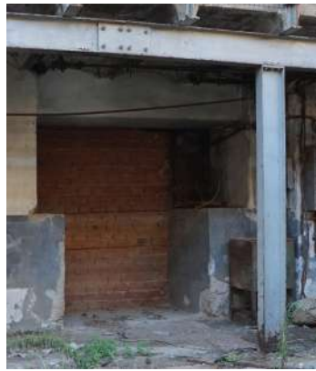
Εικόνα 172 : Άνοιγμα κατώτερηςστάθμης πληρωμένο με σπλόπλιθο, ΚΤΑ
