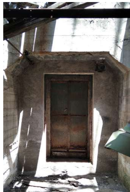
Εικόνα 137 : Δάπεδο από κατασκευή με οπλισμένο σκυρόδεμα, ΚΤΓ Πηγή : Αρχείο ομάδας μελέτης, 2021-2022
