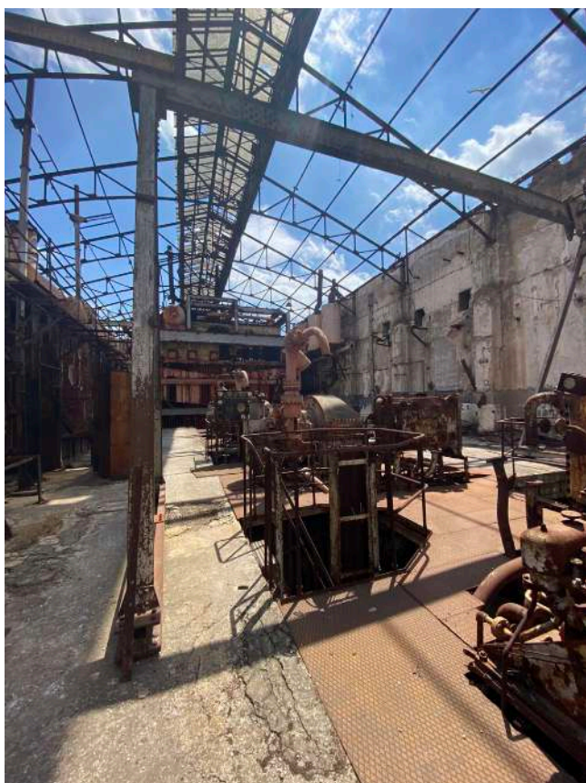
Εικόνα 76 :Το εσωτερικό του κτιρίου Β σήμερα (Λεβητοστάσιο, βόρειο τμήμα)
