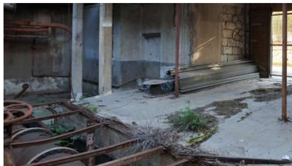
Εικόνα 146 :Πατητή τσιμεντοκονία και βύθιση με αγωγό σε κάτω στάθμη, ΚΤΑ
