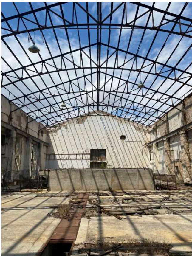
Εικόνα 75 : Το εσωτερικό του κτιρίου Α σήμερα. Μηχανοστάσιο
