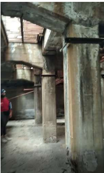
Εικόνα 132 : Δάπεδο από κατασκευή με οπλισμένο σκυρόδεμα, ΚΤΓ
