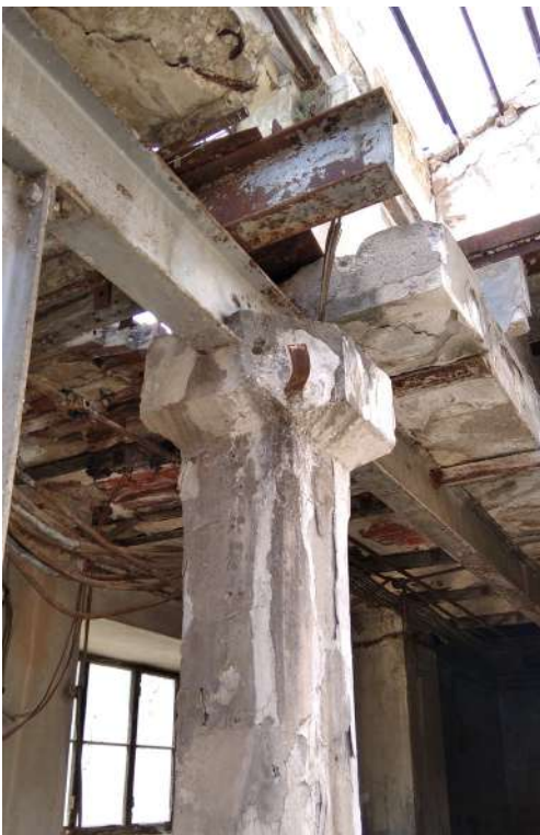
Εικόνα 123 : Σύμμικτη κατασκευή, ΚΤΑ
