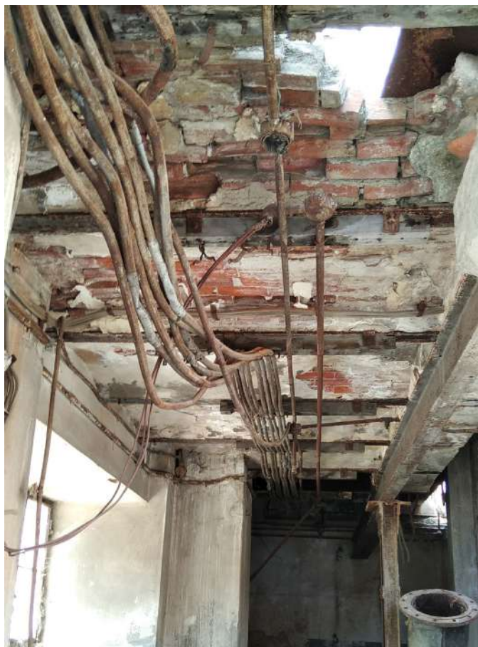
Εικόνα 120 : Θολίσκοι με συμπαγείς οπτόπλινθους , ΚΤΑ
