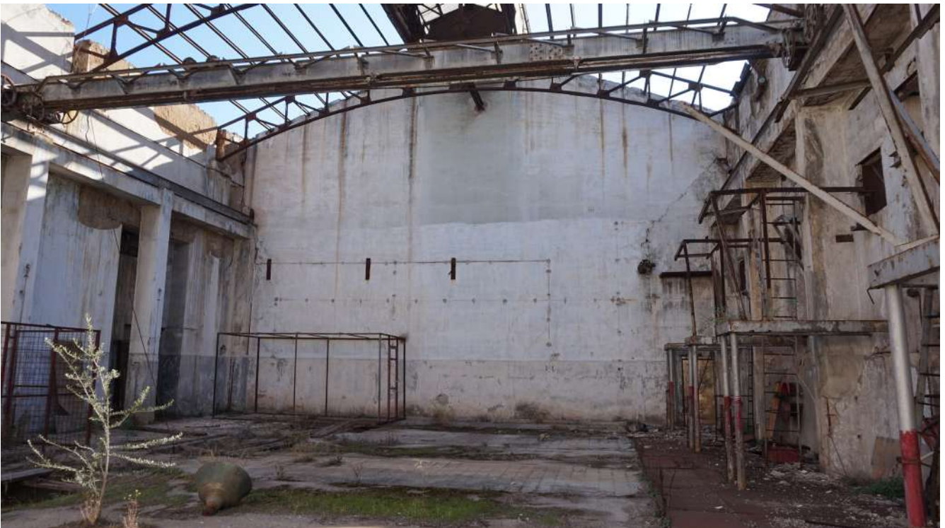
Εικόνα 100 : Εσωτερική άποψη χώρου μηχανών diesel, ΚΤΓ Πηγή : Αρχείο ομάδας μελέτης, 2021-2022
