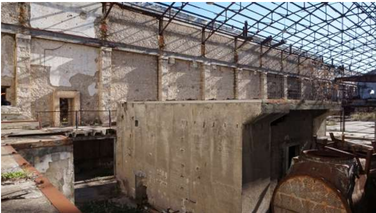
Εικόνα 107 : Μπετονένιο βάθρο μηχανής ΚΤΑ, θέση Δ
