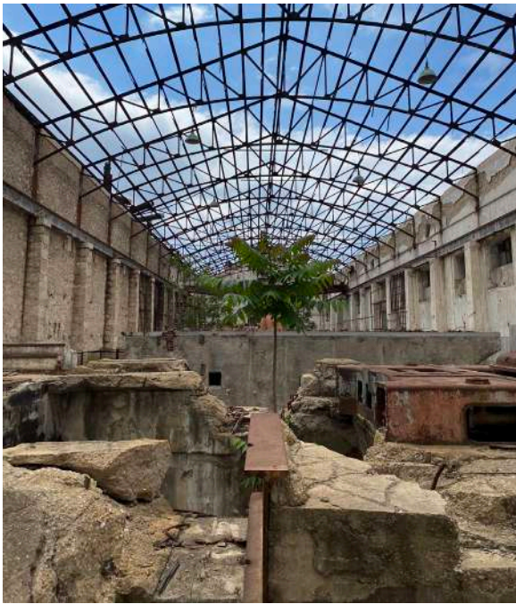
Εικόνα 208 :Μεταλλικός φορέας στέγης σε προχωρημένη οξείδωση, ΚΤΑ
