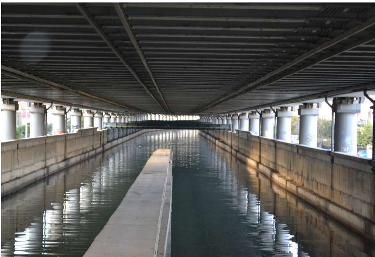
Εικόνα 10 : Η εγκιβωτισμένη κοίτη του Κηφισού με την Εθνική οδό από πάνω. Πηγή : αρχείο ομάδας, 2021
