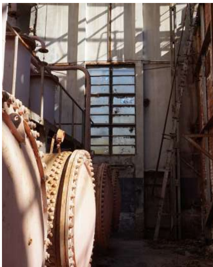
Εικόνα 175 :Μεταλλικό κούφωμα, ανατολική όψη ΚΤΓ
