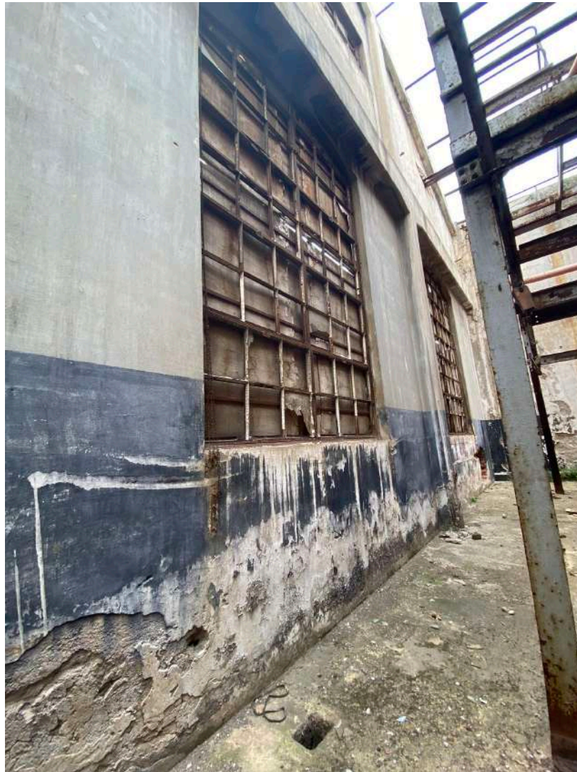
Εικόνα 213 :Άνοιγμα νότιας όψης ΚΤΒ, φραγμένο με πρόχειρη ξύλινη κατασκευή
