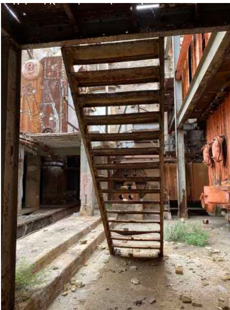
Εικόνα 179 :Μεταλλική κλίμακα χωρίς ρίχτι και αναβαθμοί από μπετόν αριστερά της, ΚΤΒ
