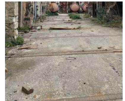
Εικόνα 150 :Σκυροδετημένη επίστρωση στην επέκταση προς νότο με μεταλλικά στοιχεία, ΚΤΓ
