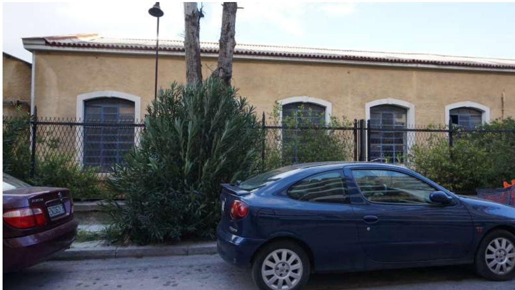
Εικόνα 34 : Κτίριο Ε από Νότο
