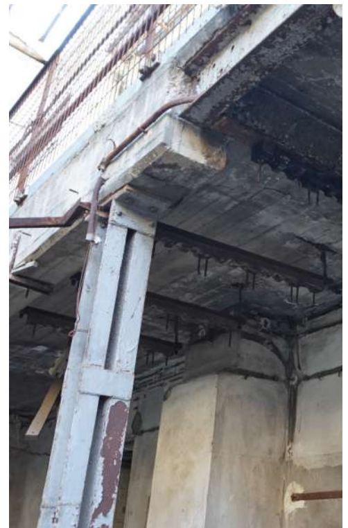
Εικόνα 125 : Σύμμικτη κατασκευή, ΚΤΑ
