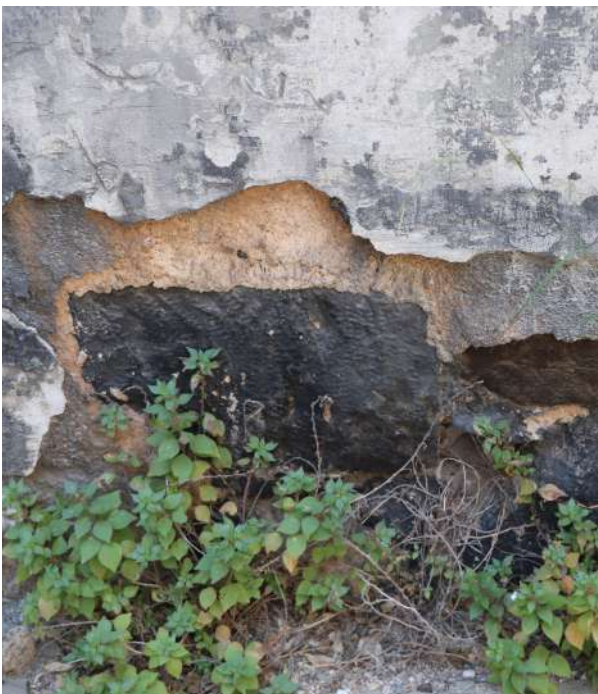
Εικόνα 199 :Αποκόλληση επιχρίσματος, μαύρη κρούστα και βλάστηση, εσωτερική άποψη νότιου τοίχου ΚΤΓ
