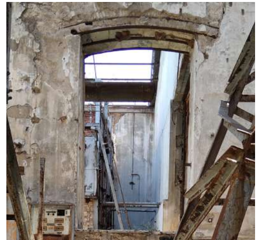
Εικόνα 155 :Άνοιγμα ΚΤΑ με τόξο με καμπύλες μεταλλικές δοκούς και πλήρωση με σχιστόλιθους, ΚΤΓ
