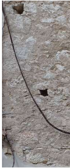
Εικόνα 187 :Νότια Όψη, Αποκόλληση επιχρίσματος, ΚΤΑ
