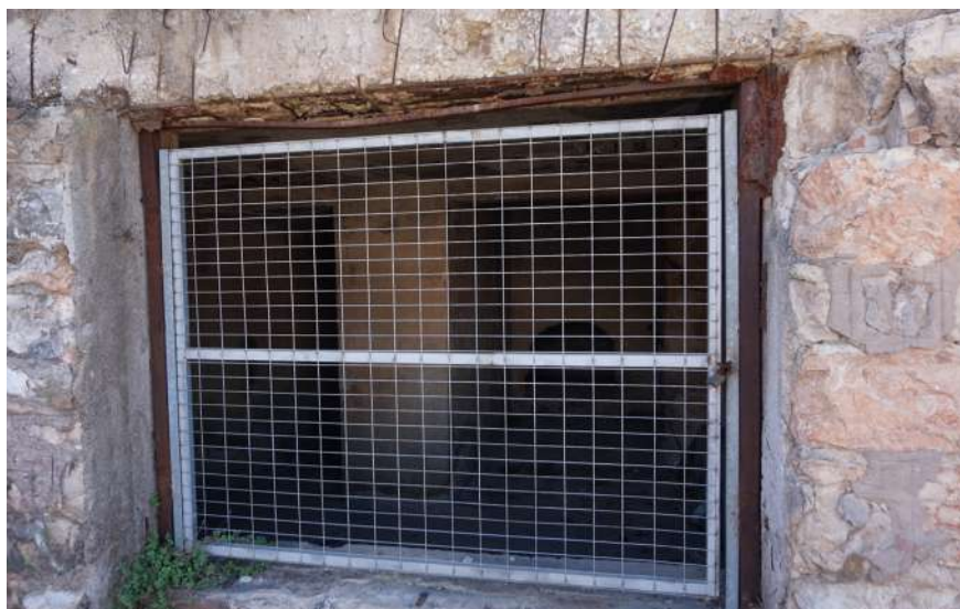
Εικόνα 214 :Άνοιγμα κάτω στάθμης ΚΤΓ φραγμένο με μεταλλική κατασκευή Πηγή : Αρχείο ομάδας μελέτης, 2021-2022
