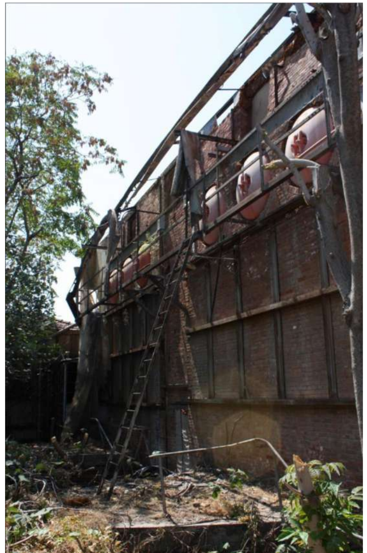
Εικόνα 102 : Ανατολική όψη, ΚΤΓ Πηγή : Ιστορικό Αρχείο ΔΕΗ, 2016
