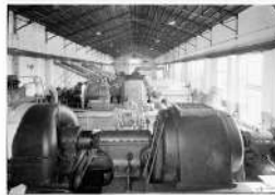
ΜΗΧΑΝΗ - ΚΤΙΡΙΟ Ατμοστρόβιλοι θέσεων Δ & Ε - Κατεύθυνση προς κάτω στάθμη (+0,00) Δ: Ατμοστρόβιλος με γεννήτρια, Daniel & Adamson, 1950 Ε: Ατμοστρόβιλος με γεννήτρια, Westinghouse, 1915
