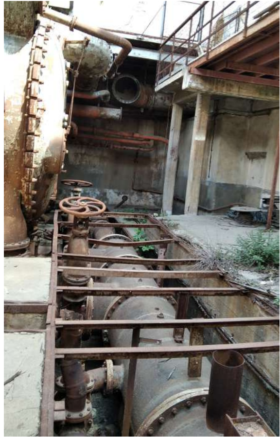
Εικόνα 105 : Βάθος θεμελίωσης από βύθιση για αγωγό, ΚΤΑ Πηγή : Αρχείο ομάδας μελέτης, 2021-2022
