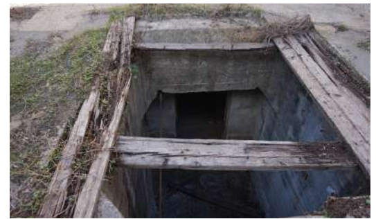
Εικόνα 152 :Δάπεδο άνω στάθμης με οπή με ξύλινες σανίδες σε πρώην θέση μηχανής, οπτική επαφή με κάτω στάθμη, ΚΤΓ
