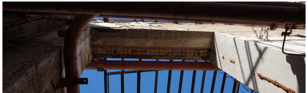
Εικόνα 160 :Γεφύρωση με ευθύγραμμες δοκούς και πλήρωση με οπτόπλινθους ανοίγματος στον εγκάρσιο τοίχο μεταξύ πρώτης και δεύτερης φάσης του ΚΤΓ
