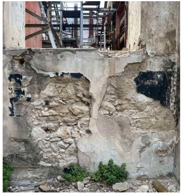
Εικόνα 198 :Αποσάθρωση συνδετικού κονιάματος και βλάστηση, κοινός τοίχος ΚΤΒ-ΚΤΓ
