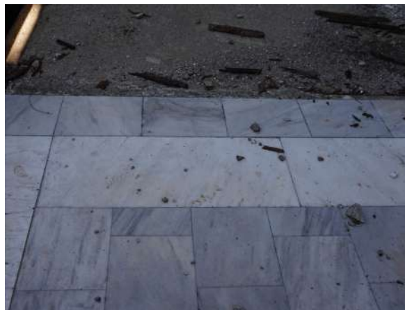
Εικόνα 141 :Δάπεδο άνω στάθμης με πλακίδια, ΚΤΑ
