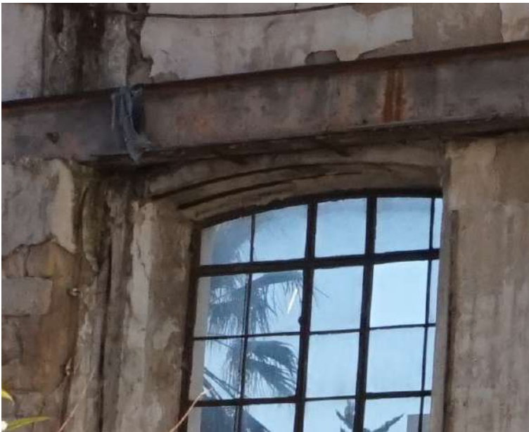
Εικόνα 153 :Άνοιγμα με τόξο με καμπύλες μεταλλικές δοκούς, ΚΤΑ
