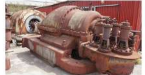
ΜΗΧΑΝΗ - ΚΤΙΡΙΟ Ατμοστρόβιλοι θέσεων Δ & Ε - Άνω στάθμη Δ: Ατμοστρόβιλος με γεννήτρια, Daniel & Adamson, 1950 Ε: Ατμοστρόβιλος με γεννήτρια, Westinghouse, 1915
