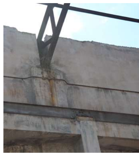
Εικόνα 203 : Φθορές σε θέση έδρασης ζευκτού, ΚΤΑ
