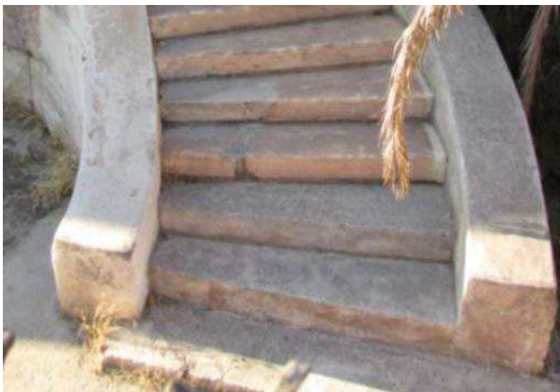
Εικόνα 185 :Η κεντρική κλίμακα του σταθμού στη νότια όψη με μαρμάρινους αναβαθμούς και συμπληρώσεις από σκυρόδεμα, ΚΤΑ Πηγή : Αρχείο ομάδας μελέτης, 2021-2022
