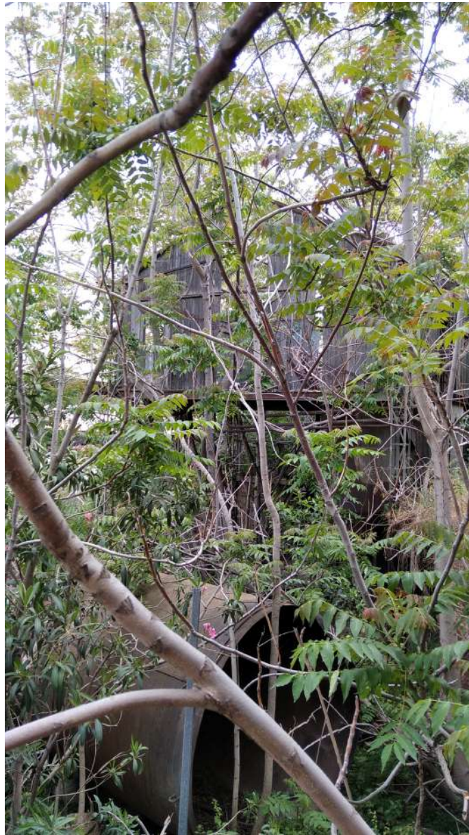
Εικόνα 229 : Άποψη κτιρίου Ε από το κοντινότερο προσβάσιμο σημείο Πηγή : Αρχείο ομάδας μελέτης, 2021-2022
