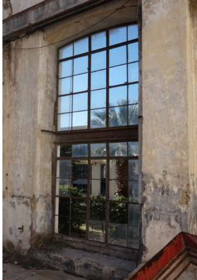
Εικόνα 169 : Άνοιγμα με μεταλλικό κούφωμα της δυτικής όψης, ΚΤΑ
