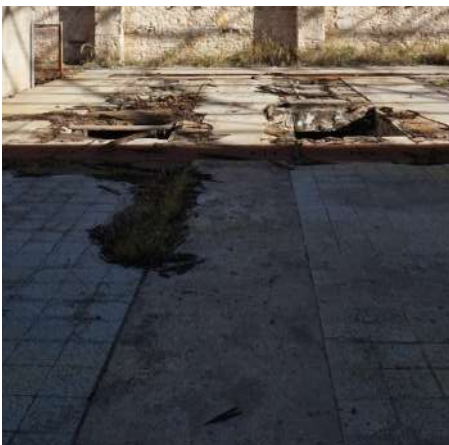
Εικόνα 139 :Δάπεδο άνω στάθμης με συνδυασμό πλακιδίων, σκυροδέματος με ψηφίδα, απλό τσιμέντου και μεταλλικού πλαισίου και οπές στις πρώην θέσεις ντιζελομηχανών, ΚΤΑ
