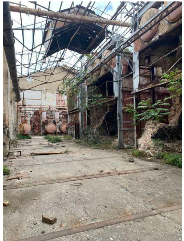
Εικόνα 212 :Οξειδωμένα ζευκτά και σε υποχώρηση ,ΚΤΓ Πηγή : Αρχείο ομάδας μελέτης, 2021-2022
