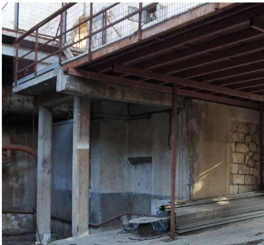
Εικόνα 119 : Σύστημα οπλισμένο σκυροδέματος αριστερά, σύστημα μεταλλικής κατασκευής, ΚΤΑ
