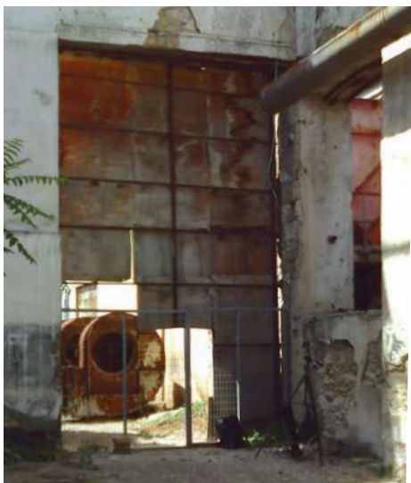
Εικόνα 174 :Μεταλλικό κούφωμα σε άνοιγμα με μεταγενέστερες πρόχειρες ξύλινες και μεταλλικές κατασκευές, νότια όψη ΚΤΓ
