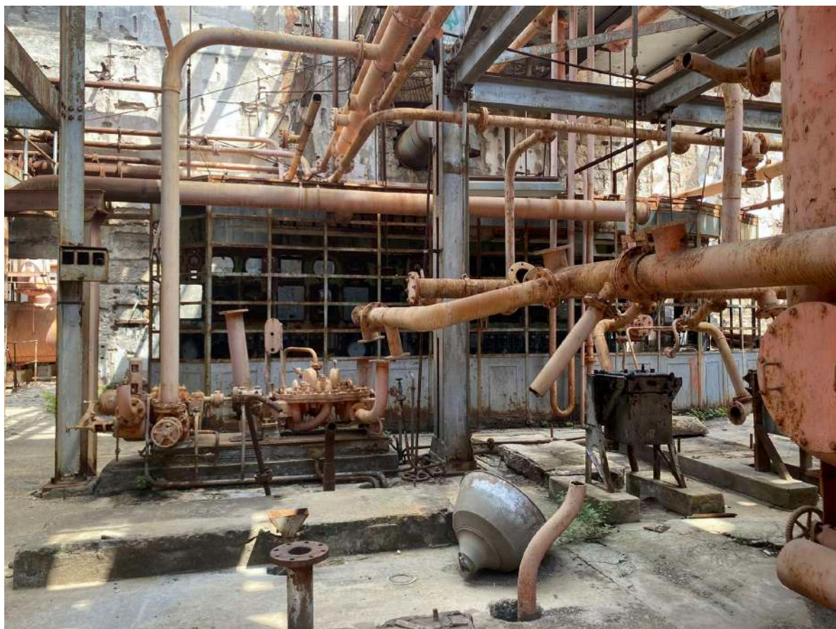
Εικόνα 80 : Το εσωτερικό του κτιρίου Β σήμερα (Λεβητοστάσιο) Πηγή : αρχείο ομάδας μελέτης 2021-2022
