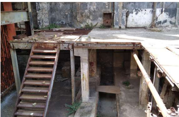
Εικόνα 131 : Δάπεδο από κατασκευή με οπλισμένο σκυρόδεμα, ΚΤΒ
