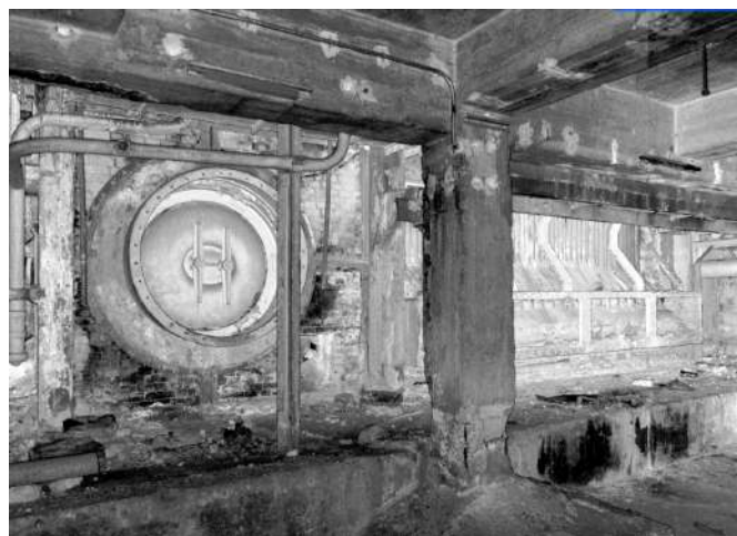
Εικόνα 134 : Δάπεδο από κατασκευή με οπλισμένο σκυρόδεμα, ΚΤΒ
