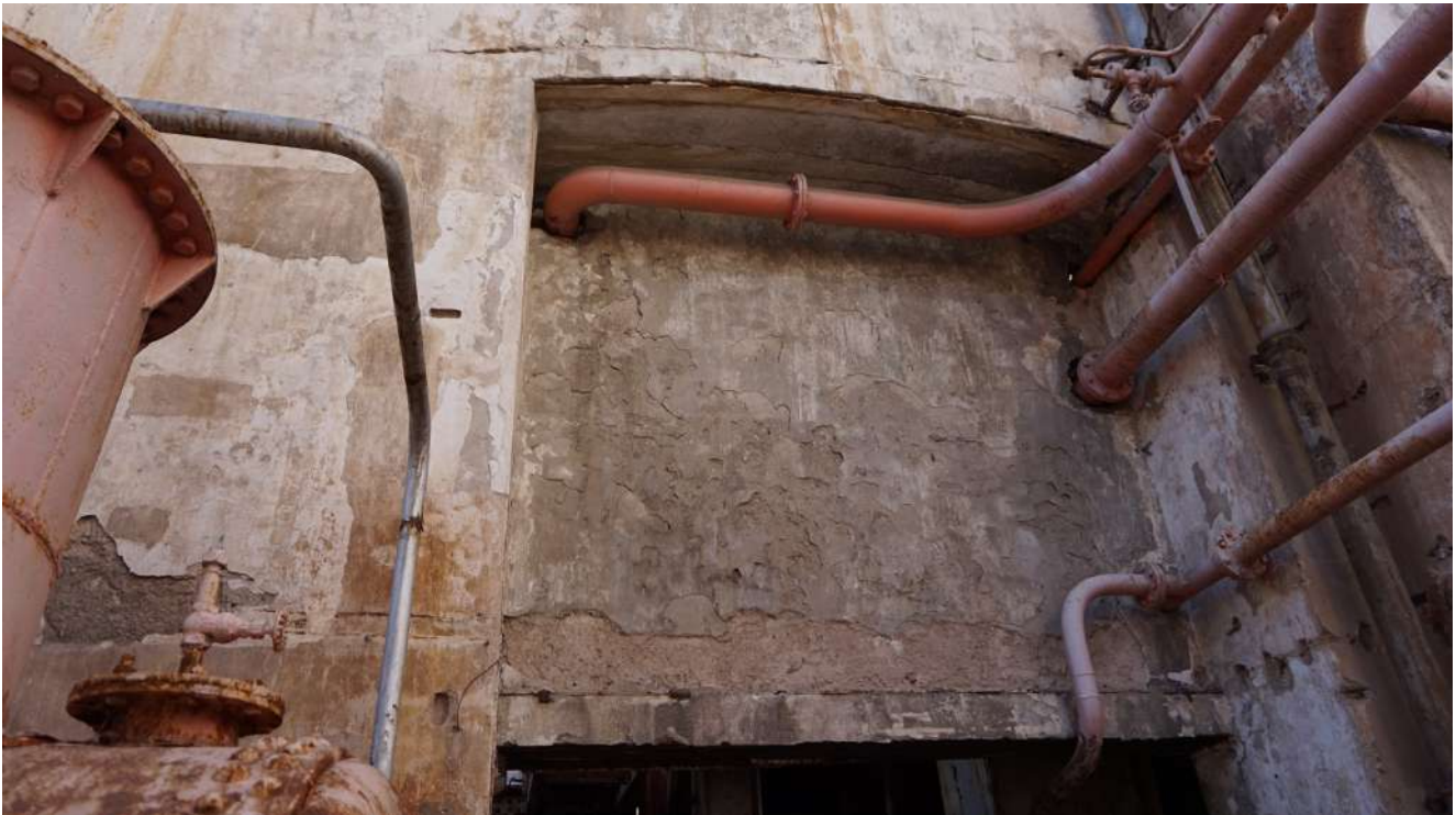
Εικόνα 215 :Αποκόλληση επιχρισματος με αποκάλυψη μεταλλικών στοιχείων στο αρχικό πρέκι, άνοιγμα Β-Α ΒΓ 3 Πηγή : Αρχείο ομάδας μελέτης, 2021-2022
