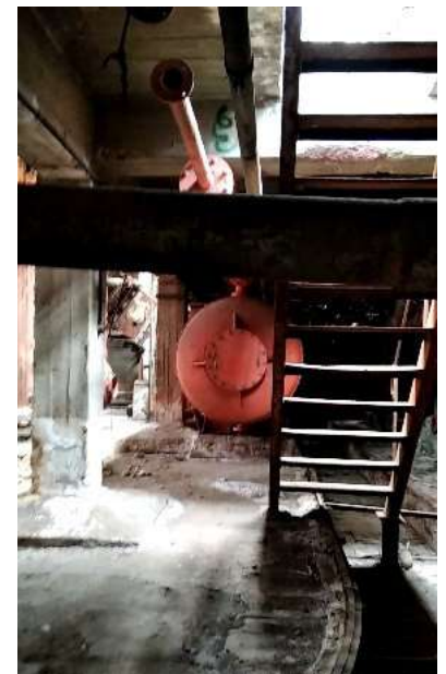
Εικόνα 181 :Μεταλλική κλίμακα χωρίς ρίχτι και αναβαθμοί από μπετόν αριστερά της, ΚΤΒ
