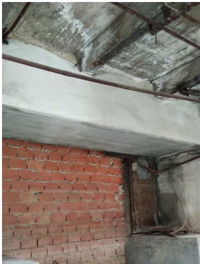
Εικόνα 121 : Θολίσκοι με συμπαγείς οπτόπλινθους και κάλυψη με εμφανή ξυλότυπο , ΚΤΑ
