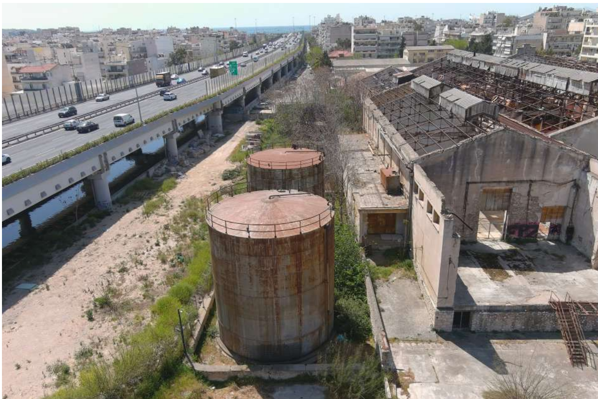
Εικόνα 37 : Οι δυο όμοιες δεξαμενές στο ανατολικό άκρο του συγκροτήματος Πηγή : ομάδα μελέτης, 2021
