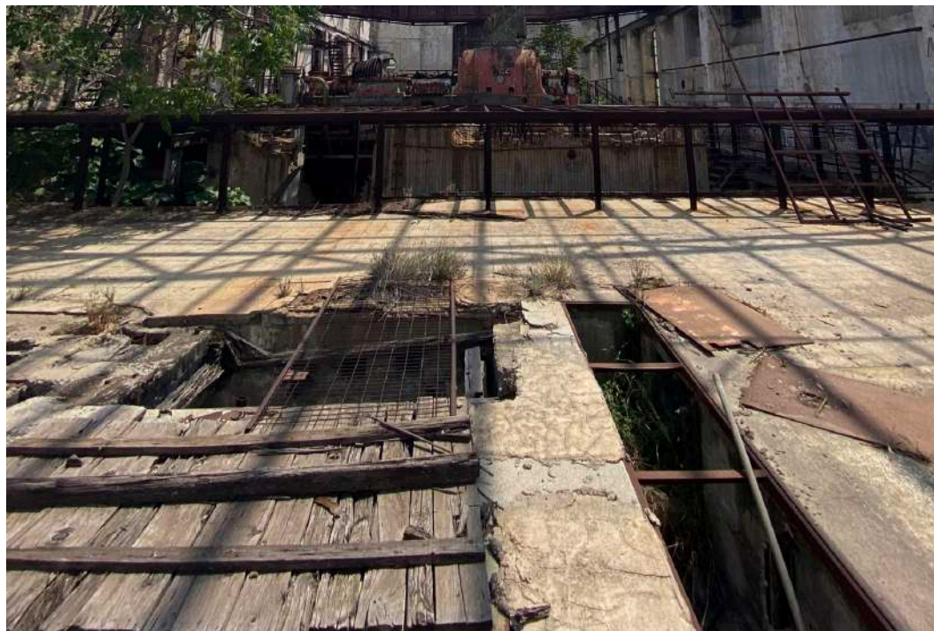
Εικόνα 205 : Δάπεδα ΚΤΑ Πηγή : Αρχείο ομάδας μελέτης, 2021-2022
