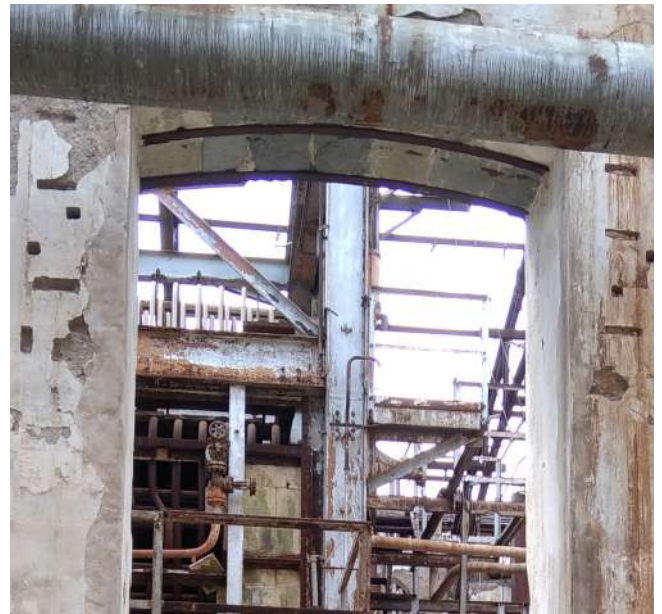
Εικόνα 154 :Άνοιγμα ΚΤΑ με τόξο με καμπύλες μεταλλικές δοκούς και πλήρωση με σχιστόλιθους, ΚΤΓ
