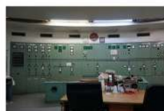
ΜΗΧΑΝΗ - ΚΤΙΡΙΟ Αίθουσα ηλεκτρικών πινάκων
