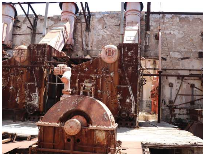
Εικόνες 30, 31 : Ατμοστρόβιλοι General Electric και λέβητες Foster Wheeler, στο βόρειο τμήμα του κτιρίου Β Πηγή : Αρχείο ομάδας, 2021
