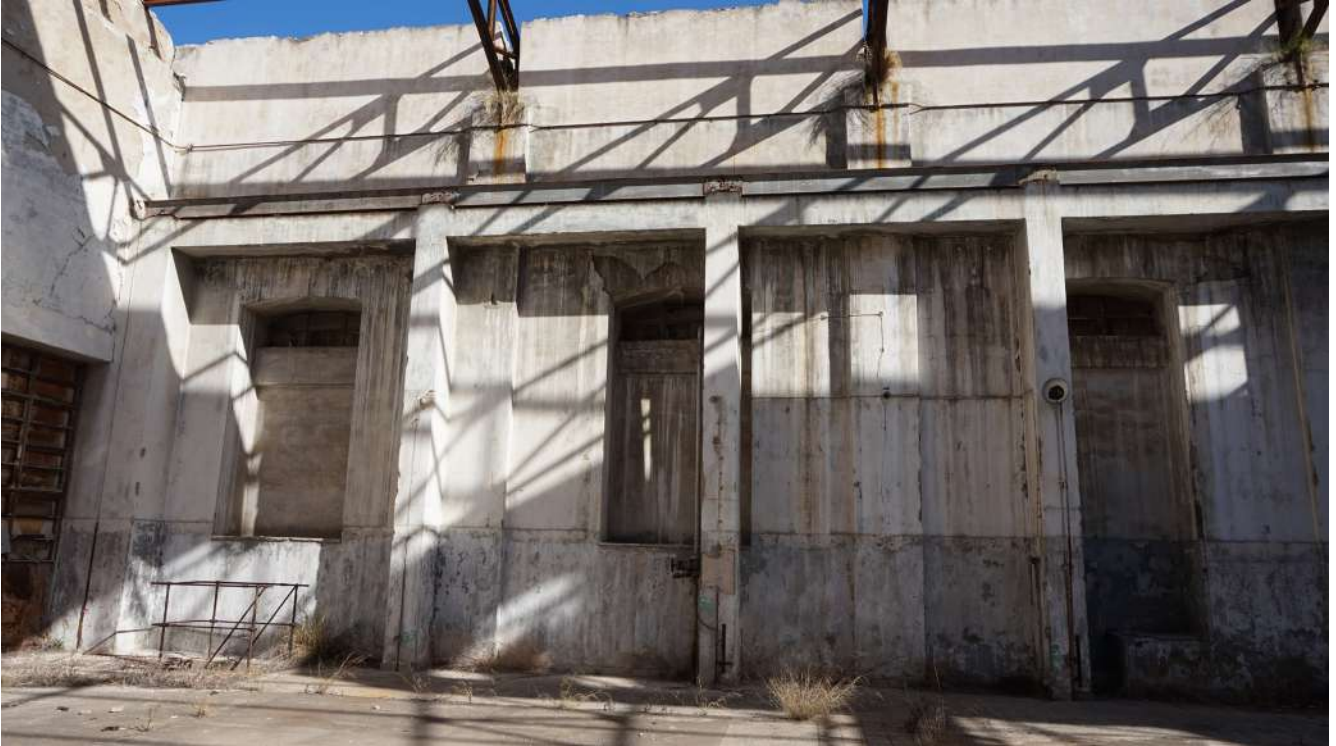
Εικόνα 99 : Έδραση μεταλλικών ζευκτών σε λιθινες νευρώσεις, ΚΤΓ
