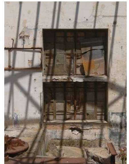
Εικόνα 170 :Άνοιγμα με μεταλλικό κούφωμα της βόρειας όψης, ΚΤΑ
