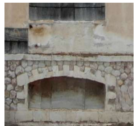
Εικόνα 162 :Ανοίγμα υπογείου νότιας όψης ΚΤΒ με λαξευτό λίθινο τόξο
