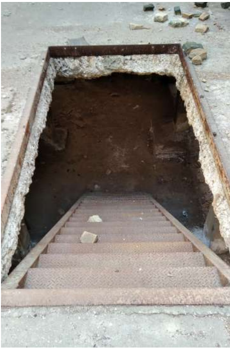
Εικόνα 177 :Μεταλλική κλίμακα χωρίς χειρολισθήρες, ΚΤΒ
