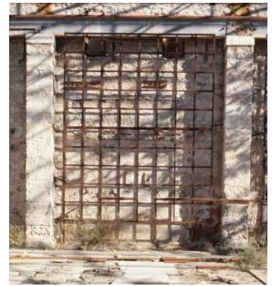
Εικόνα 173 :Άνοιγμα άνω στάθμης πληρωμένο με σπλόπλιθο, ΚΤΑ
