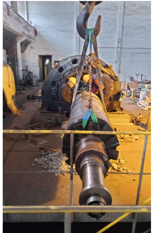
Εικόνα 11 : Στρόβιλος προς τοποθέτηση στη θέση Η Πηγή : Αρχείο ομάδας, 2021
