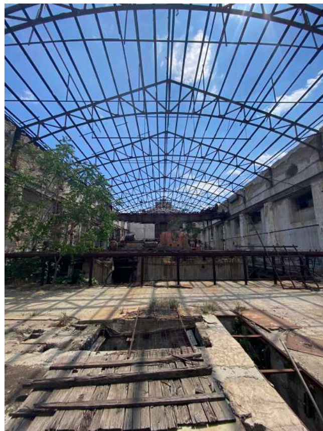
Εικόνα 77 : Το εσωτερικό του κτιρίου Α σήμερα. Μηχανοστάσιο
