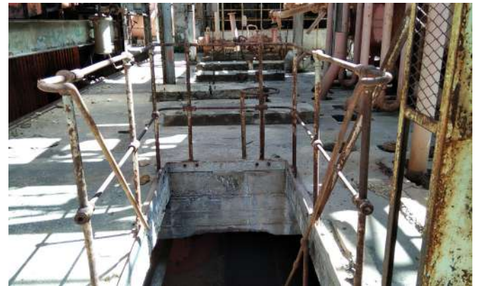
Εικόνα 182 : Χειρολισθήρες με λεπτομέρειες, ΚΤΒ
