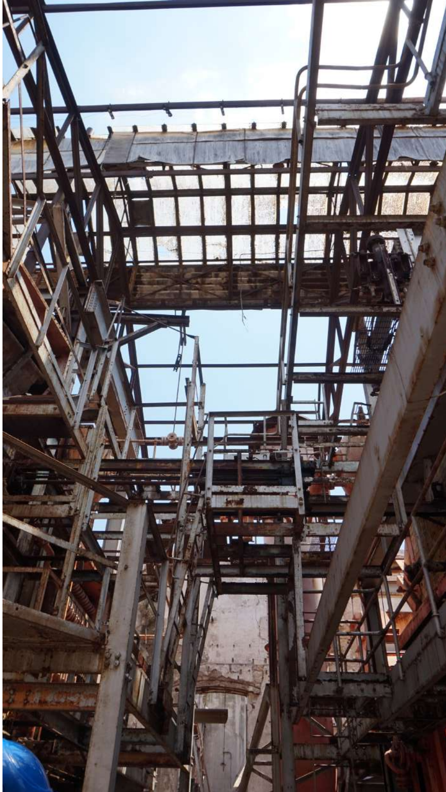
Εικόνα 114 : Κτίριο Β. Εσωτερική άποψη. Ο φεγγίτης της Β πτέρυγας πάνω από τον λέβητα Babcock Wilcox Πηγή : Αρχείο ομάδας μελέτης, 2021-2022
