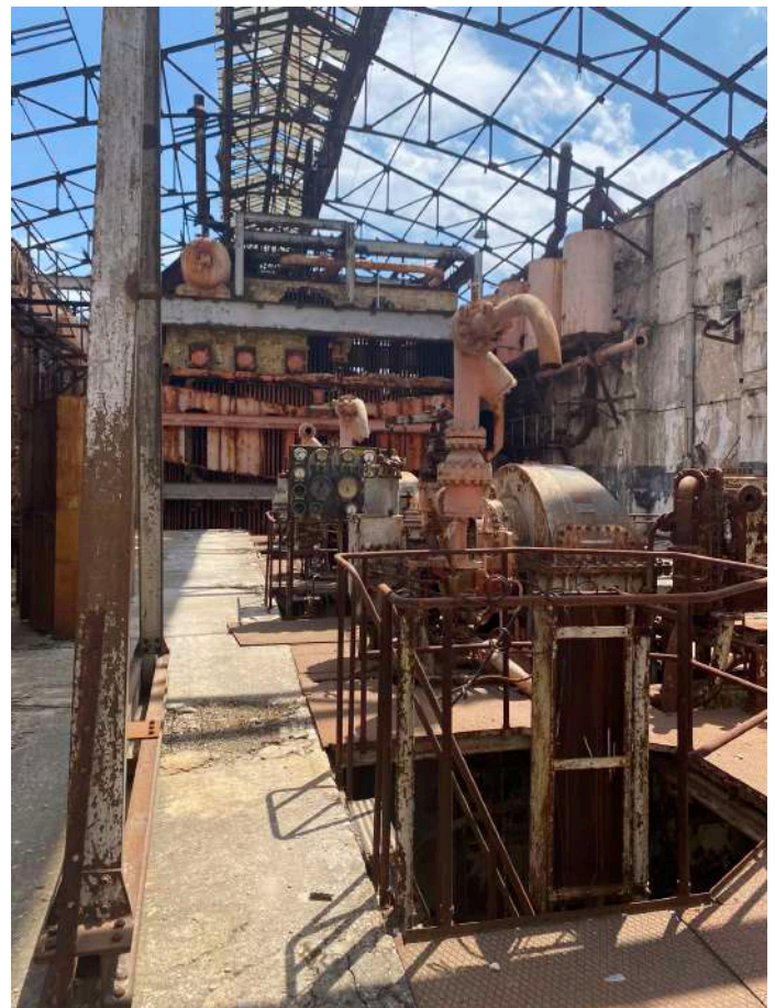
Εικόνες 30, 31 : Ατμοστρόβιλοι General Electric και λέβητες Foster Wheeler, στο βόρειο τμήμα του κτιρίου Β Πηγή : Αρχείο ομάδας, 2021
