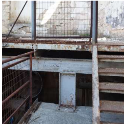
Εικόνα 133 : Δάπεδο με μεταλλικές δοκούς επί μεταλλικών υποστηλωμάτων, ΚΤΑ
