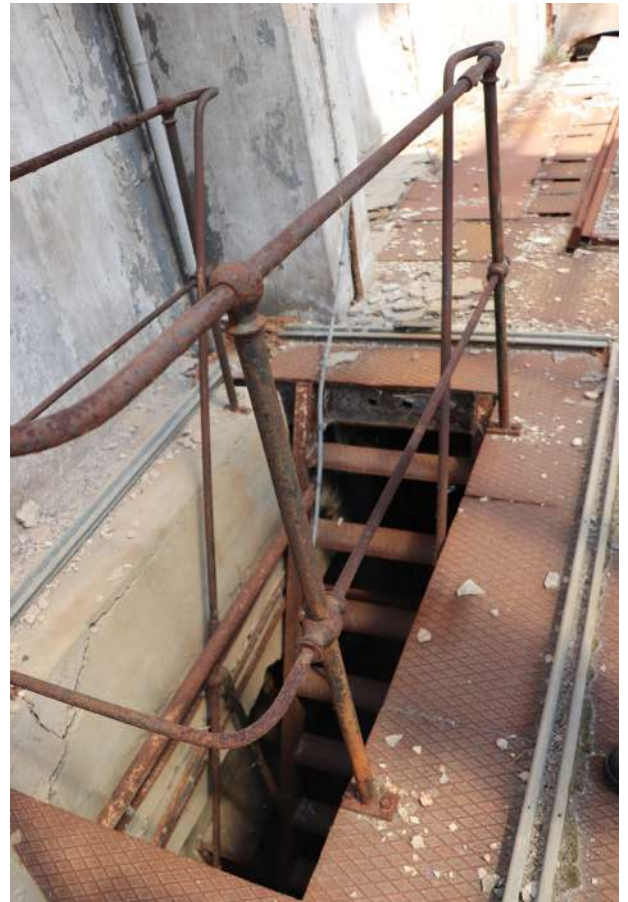
Εικόνα 217 :Εσωτερική μεταλλική οξειδωμένη κλίμακα, ΚΤΓ Πηγή : Αρχείο ομάδας μελέτης, 2021-2022
