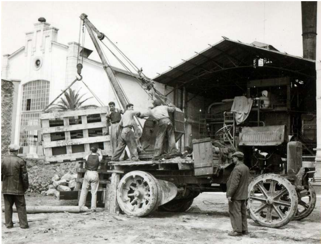
Εικόνα 70 : Εκφόρτωση μηχανημάτων στο λεβητοστάσιο κατά την εγκατάσταση των νέων λεβήτων Babcock & Wilcox, 1 Απριλίου 1950.
