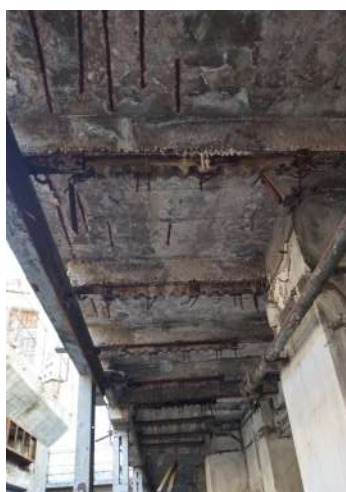
Εικόνα 201 : Οξειδωμένος οπλισμός δαπέδου, κατώτερη στάθμη ΚΤΑ
