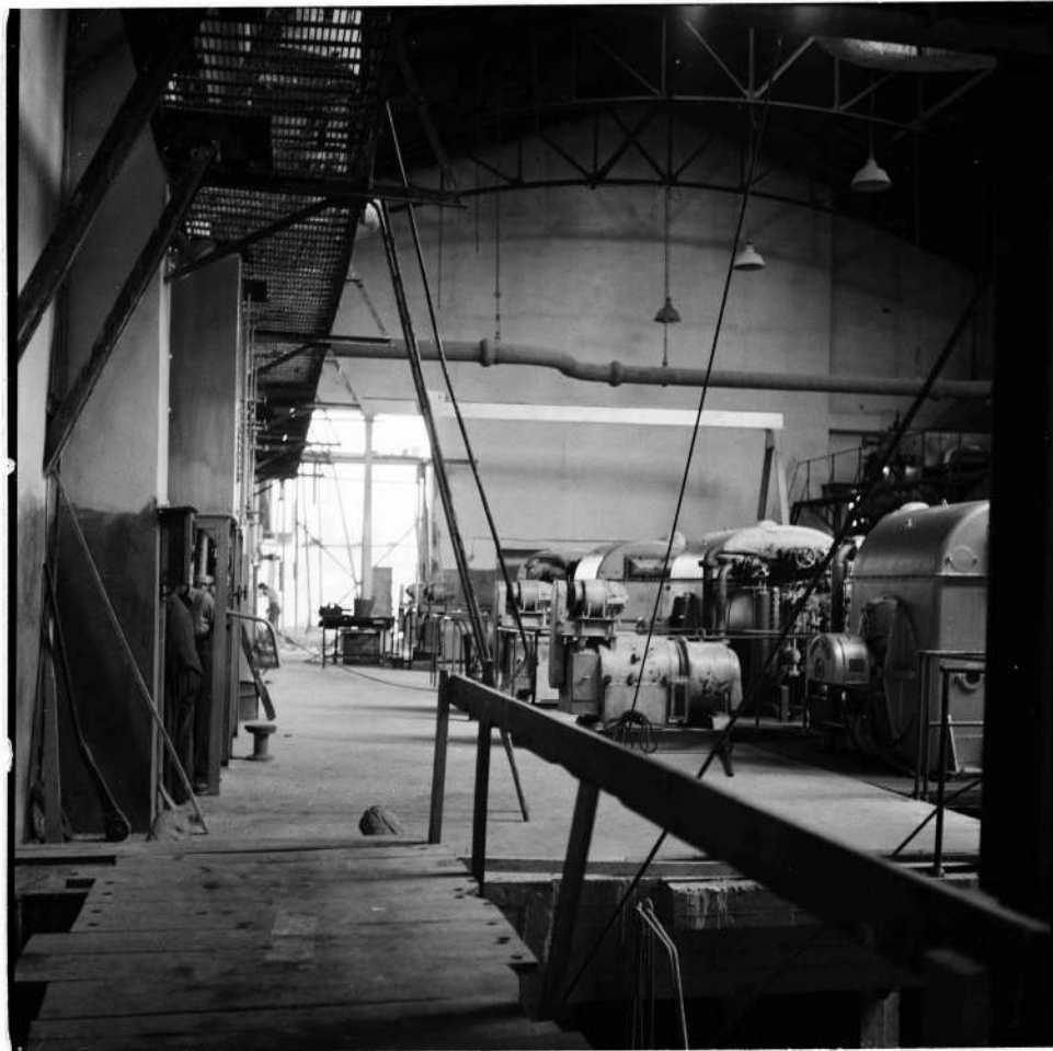
Εικόνα 68 : Άποψη εντός του κτιρίου Β (Λεβητοστασίου), από νότο προς βορρά, με ξύλινο διάδρομο για γεφύρωση ανοίγματος δαπεδου. (1933-1941)
