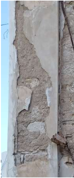
Εικόνα 187 :Νότια Όψη, Αποκόλληση επιχρίσματος, ΚΤΑ
