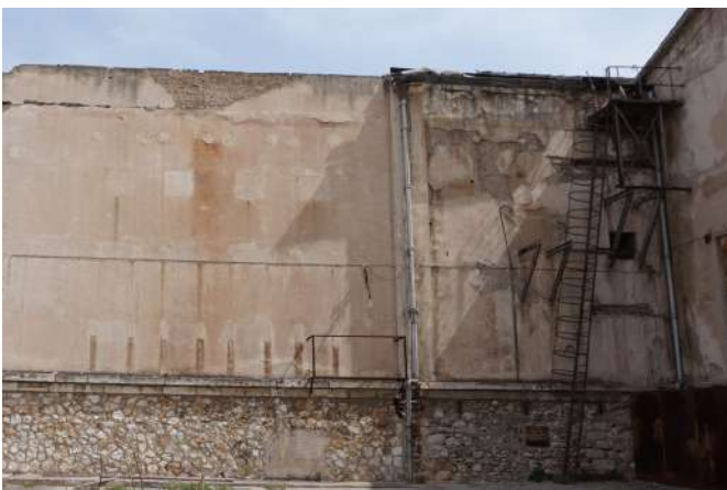
Εικόνα 190 : Νότια Όψη, Αποκόλληση επιχρίσματος και αποσάθρωση κονιάματος, ΚΤΒ
