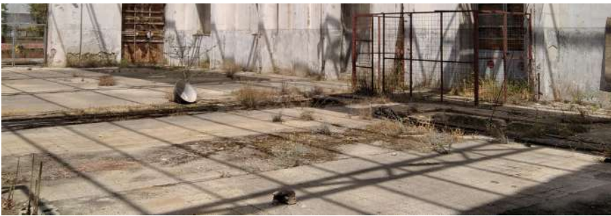
Εικόνα 151 :Δάπεδο άνω στάθμης με συνδυασμό πλακιδίων, σκυροδέματος και οπές με ξύλινες σανίδες στις πρώην θέσεις ντιζελομηχανών, ΚΤΓ
