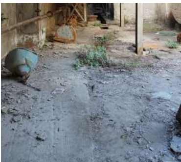
Εικόνα 145 :ατητή τσιμεντοκονία κάτω στάθμης, ΚΤΑ
