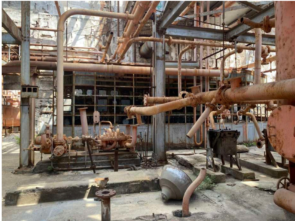
Εικόνα 219 :Οξειδωμένος in situ εξοπλισμός
