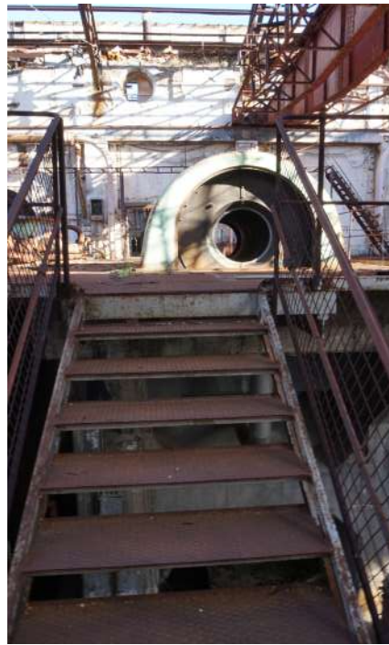
Εικόνα 183 :Μεταλλική κλίμακα χωρίς ρίχτι, μεχειρολισθήρες, ΚΤΑ
