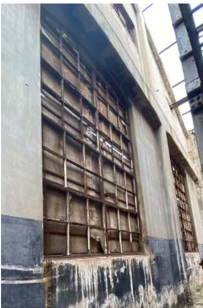
Εικόνα 166 :Μεταλλικό κούφωμα, νότια όψη ΚΤΒ
