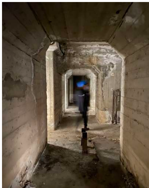
Εικόνα 135 : Δάπεδο από κατασκευή με οπλισμένο σκυρόδεμα, ΚΤΓ
