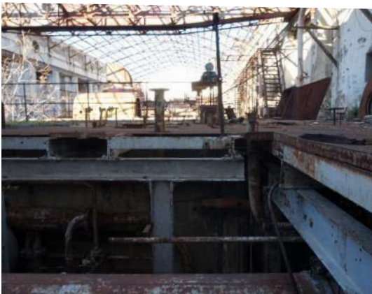
Εικόνα 130 : Δάπεδο με μεταλλικές δοκούς επί μεταλλικών υποστηλωμάτων, ΚΤΑ
