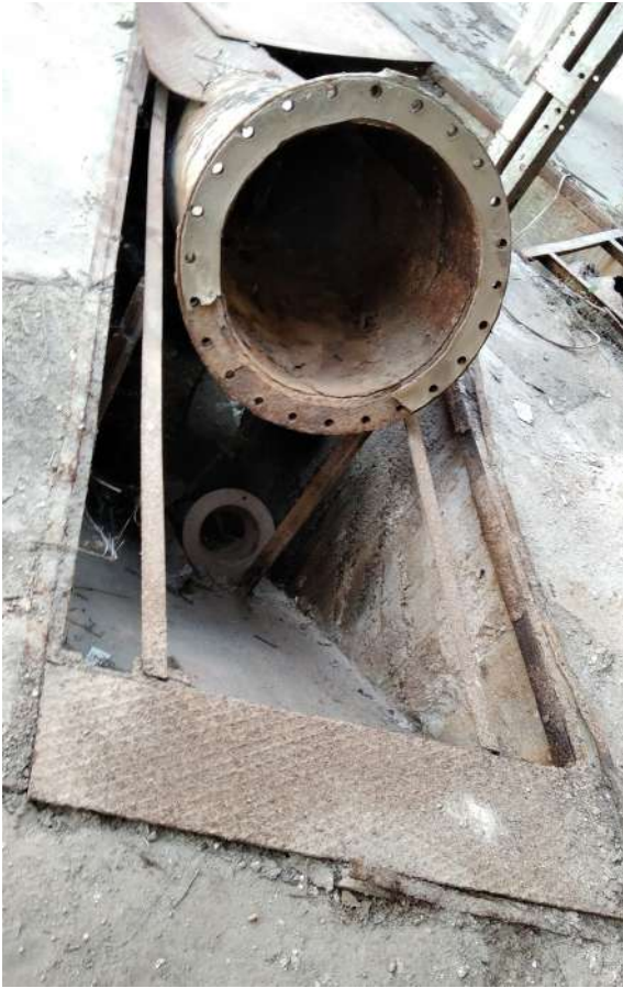
Εικόνα 103 : Βάθος θεμελίωσης από βύθιση για αγωγό, ΚΤΑ
