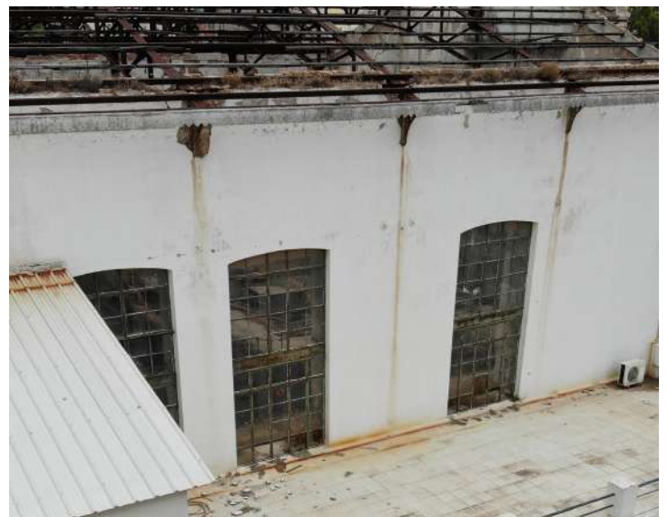
Εικόνα 192 : Υγρασία διαρροής στέγης, μικροφθορές στα σημεία έδρασης των μεταλλικών ζευκτών, ΚΤΒ
