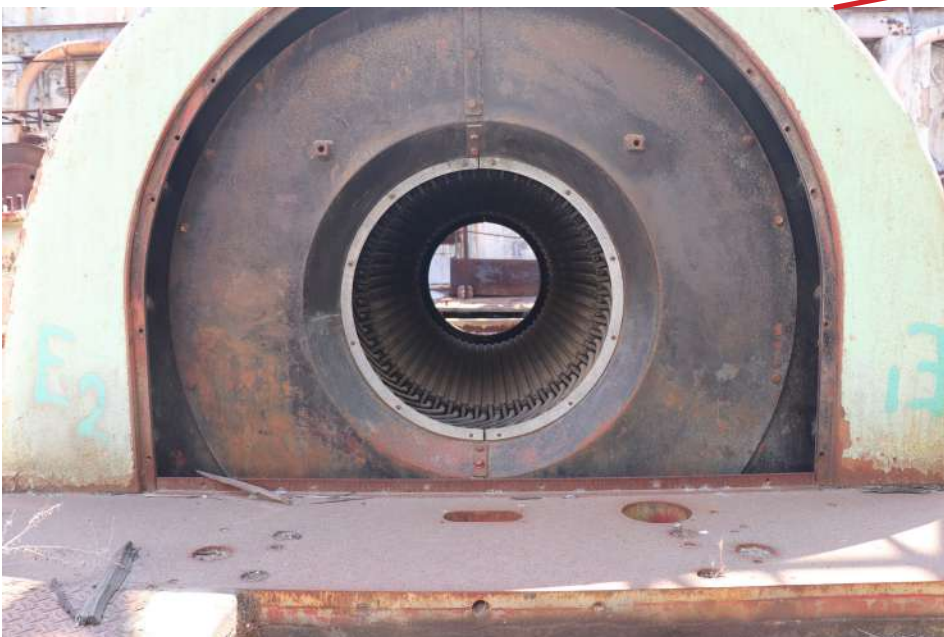
Εικόνα 12 : Θέση Β, σωζόμενος στάτης της γεννήτριας in situ Πηγή : Αρχείο ομάδας, 2021
