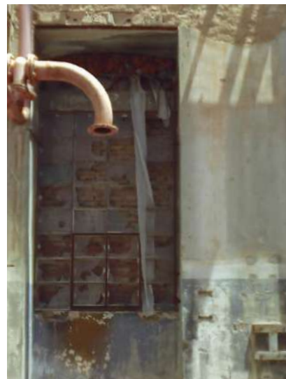
Εικόνα 176 :Μεταλλικό κούφωμα σε φραγμένο με οπτόπλινθους άνοιγμα, ανατολική όψη ΚΤΓ
