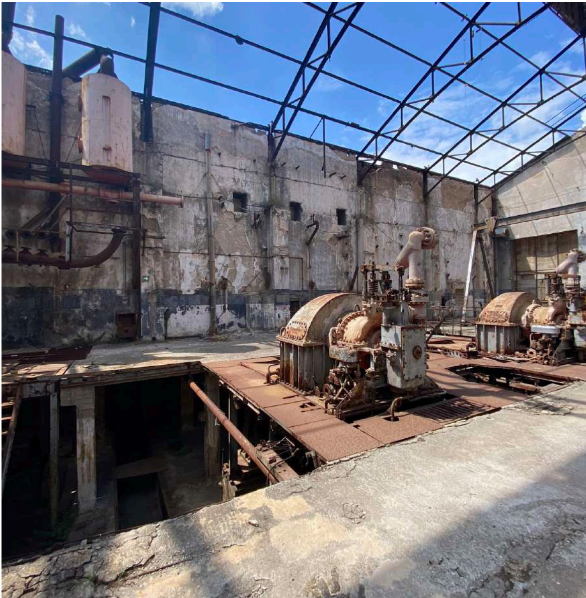
Εικόνα 98 : Φέρουσα τοιχοποιία και πλήρωση άνω απόληξης με οπτόπλινθο ΚΤΒ Πηγή : Αρχείο ομάδας μελέτης, 2021-2022
