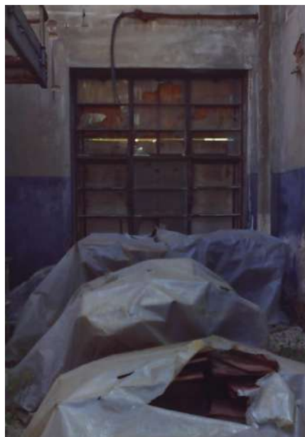
Εικόνα 167 :Μεταλλικό κούφωμα, ανατολική όψη, νότιο άκρο ΚΤΒ
