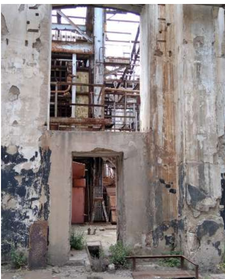
Εικόνα 156 :Μεταγενέστερο κάτω άνοιγμα, ΚΤΓ
