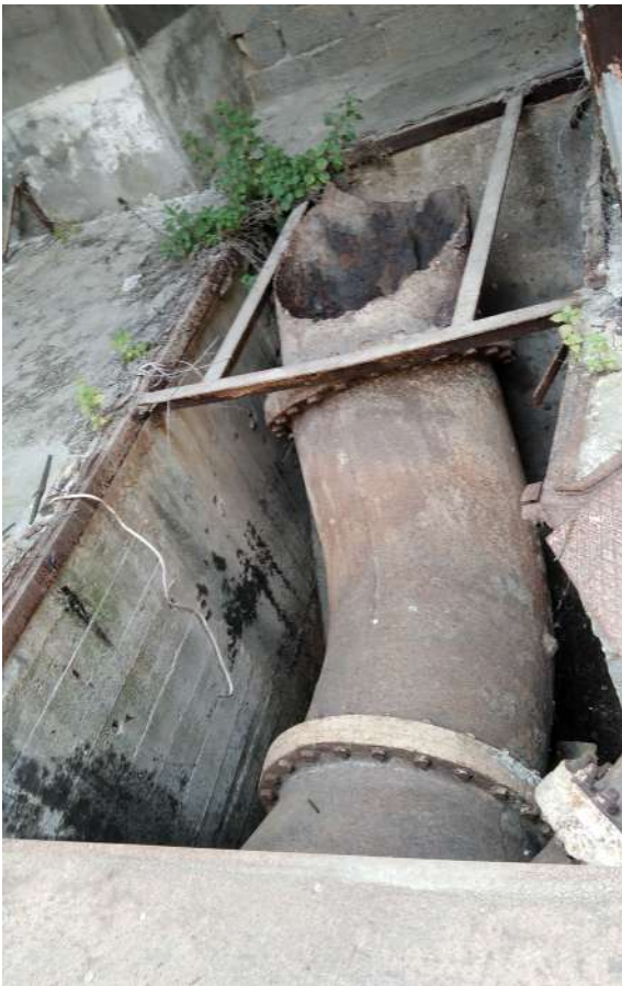
Εικόνα 104 : Βάθος θεμελίωσης από βύθιση για αγωγό, ΚΤΑ
