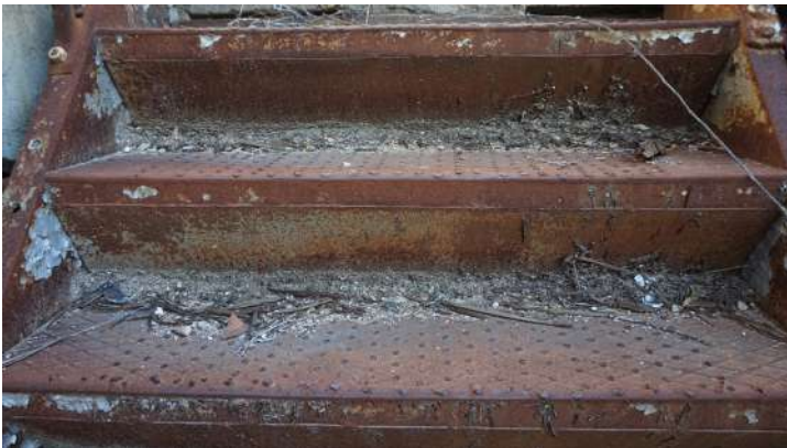
Εικόνα 178 :Μεταλλική κλίμακα με ρίχτι, ΚΤΑ
