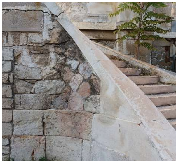
Εικόνα 186 :Το στηθαίο και η περιμετρική λιθοδομή της κλίμακας, ΚΤΑ Πηγή : Αρχείο ομάδας μελέτης, 2021-2022
