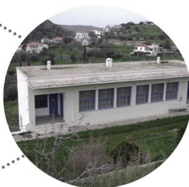
Αξιοποίηση κοινοτικού κτιρίου Γεωργικής Σχολής Πρότυπες καλλιέργειες/σεμινάρια επισκεπτών-κατοίκων
