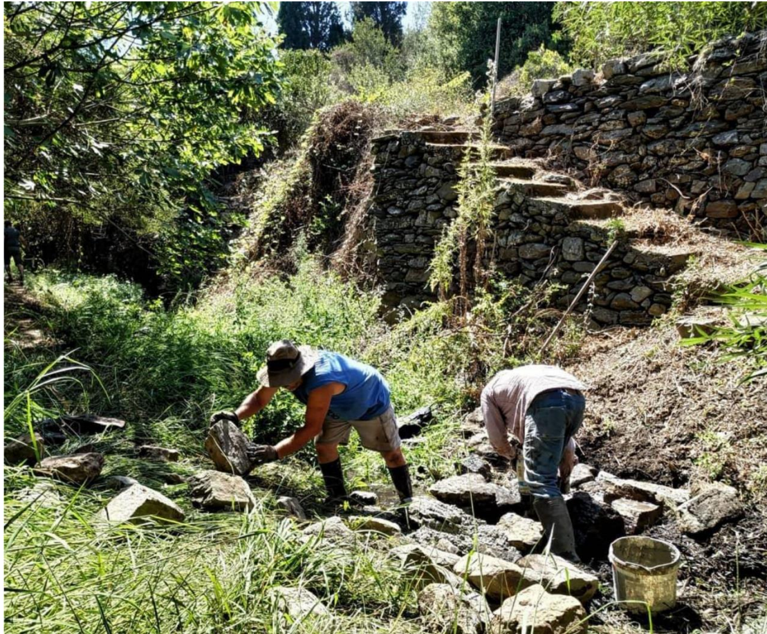
Εικόνα 4.1.75 Εργασίες αποκατάστασης των μικροφραγμάτων στον Καραβά-πηγή kira.org
