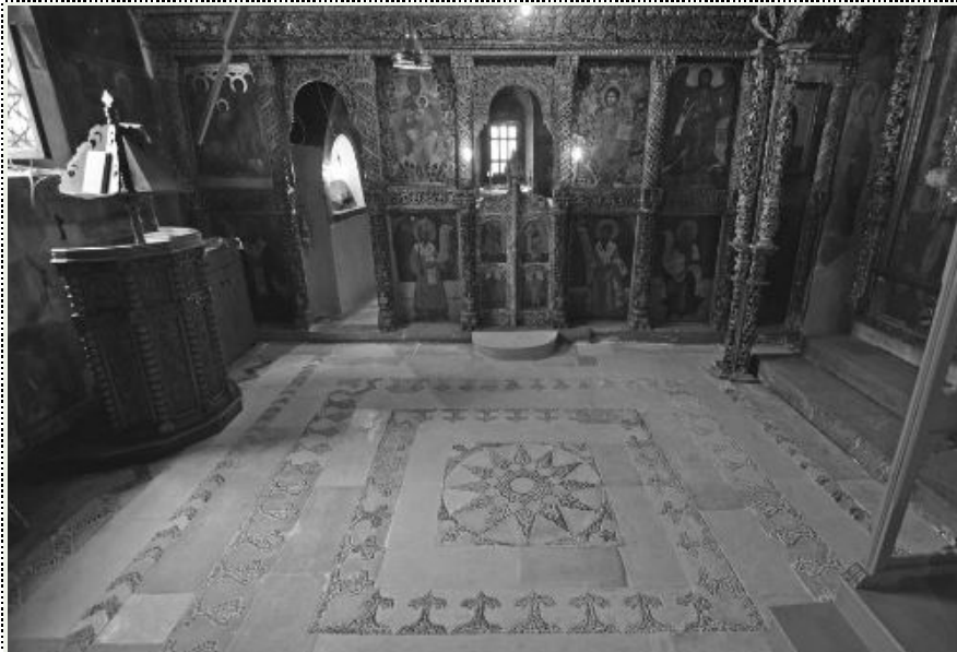
Τμήμα βοτσαλωτού δαπέδου του άνω καθολικού μετά τις εργασίες αποκατάστασης
