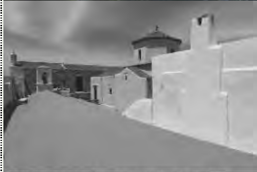
Αποψη της οροφής της νέας τράπεζας μετά τις εργασίες μόνωσης
