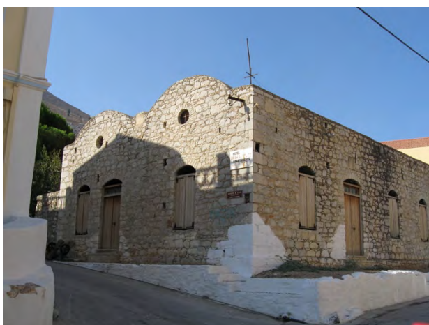
Εικόνα 64 Σιδηρουργείο Βολανάκη, εξωτερική άποψη
