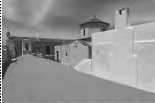
Άποψη της οροφής της νέας τράπεζας μετά τις εργασίες μόνωσης
