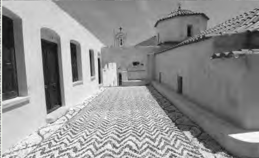
Βοτσαλωτό δάπεδο στην ανώτερη στάθμη των κελιών μετά τις εργασίες αποκατάστασης
