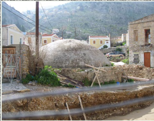
φωτογραφία από την υφιστάμενη κατάσταση της δεξαμενής
