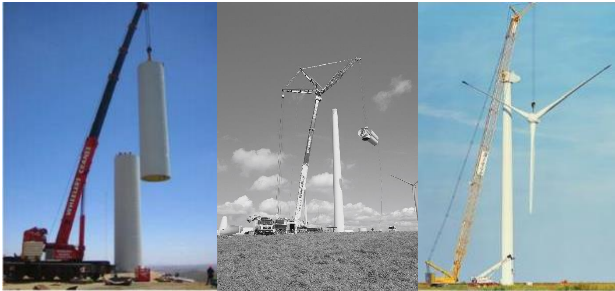
Σχήμα 2-11 Ανέγερση τμήματος πυλώνα, ατράκτου και δρομέα [1]
