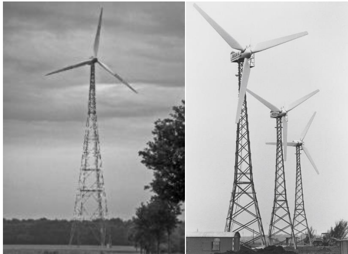
Σχήμα 2-1: Ανεμογεννήτριες με πυλώνα από χωροδικτυώματα [1]
