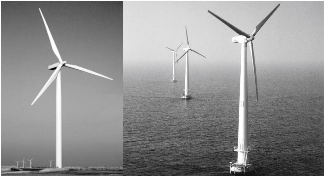
Σχήμα 2-3: Ανεμογεννήτριες με αυτόνομο χαλύβδινο σωληνωτό πυλώνα [1]
