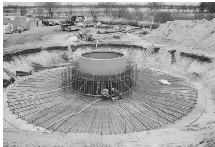
Σχήμα 2-10: Θεμελίωση κυκλικής μορφής ανεμογεννήτριας [1]
