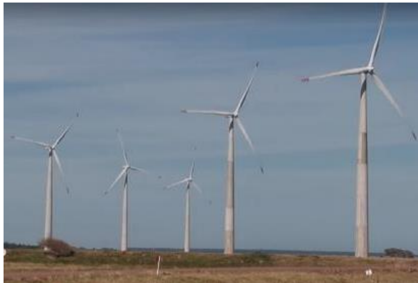
Σχήμα 2-2: Ανεμογεννήτριες με πυλώνα από οπλισμένο σκυρόδεμα
