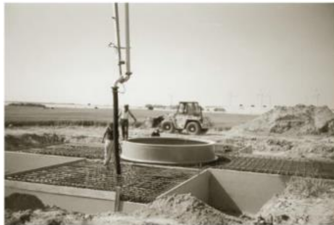
Σχήμα 2-9: Θεμελίωση σταυροειδούς μορφής ανεμογεννήτριας [1]
