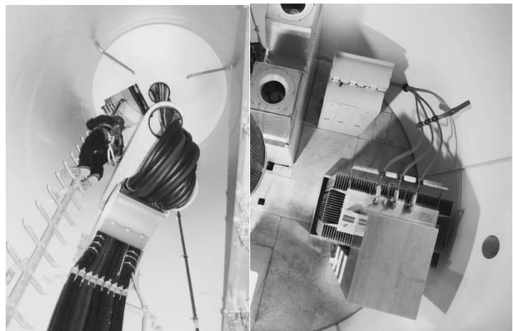
Σχήμα 2-7: Συστατικά μέρη ενός αυτόνομου χαλύβδινου σωληνωτού πυλώνα [1]
