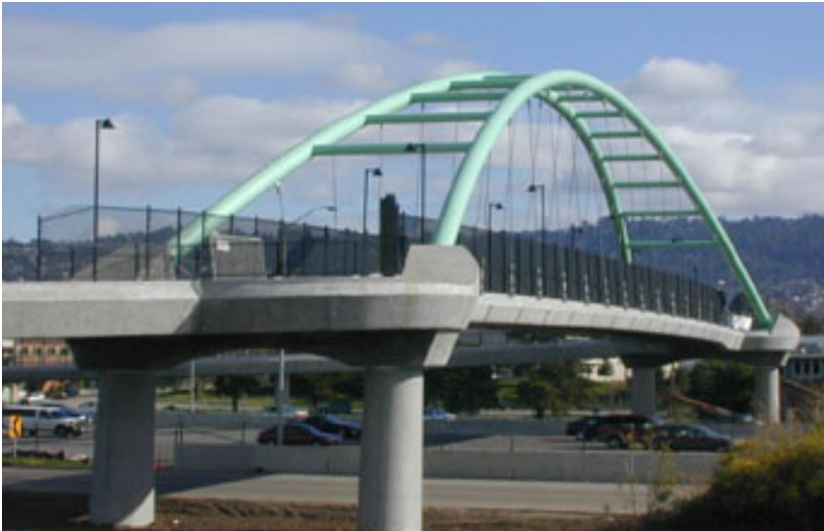
Σχήμα 1-2 Γέφυρα Berkeley I-80 στην Καλιφόρνια
