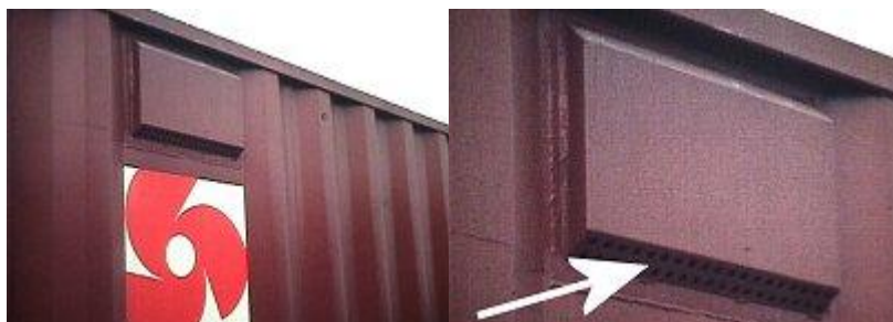
Σχήμα 2.1.2: Οπές εξαερισμού σε εμπορευματοκιβώτια γενικού σκοπού Πηγή: (1)
