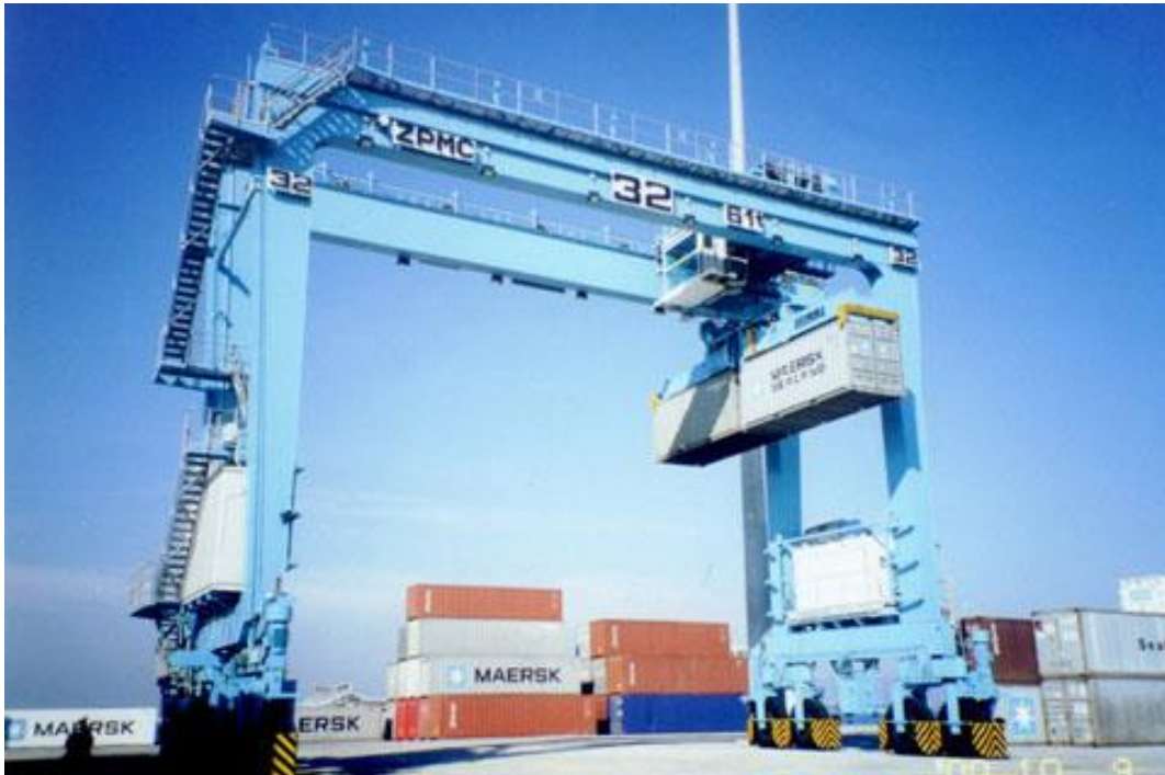
Σχήμα 3.3.8: Γερανογέφυρα με δυνατότητα ανύψωσης σε μεγάλο ύψος με ανελκυστήρα
