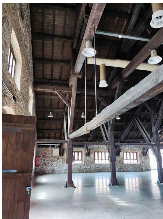
Εικόνα 5.9: Εσωτερική επισκόπηση πολυχώρου, «Κεντρική Σάλα» [Ιδία Επεξεργασία].
