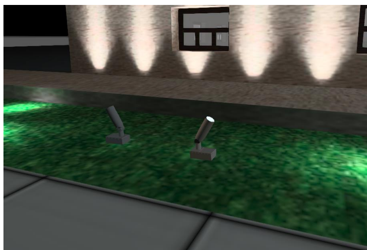
Εικόνα 6.43: Φωτιστικά spotlight για τον φωτισμό των δέντρων [Ίδια Επεξεργασία].
