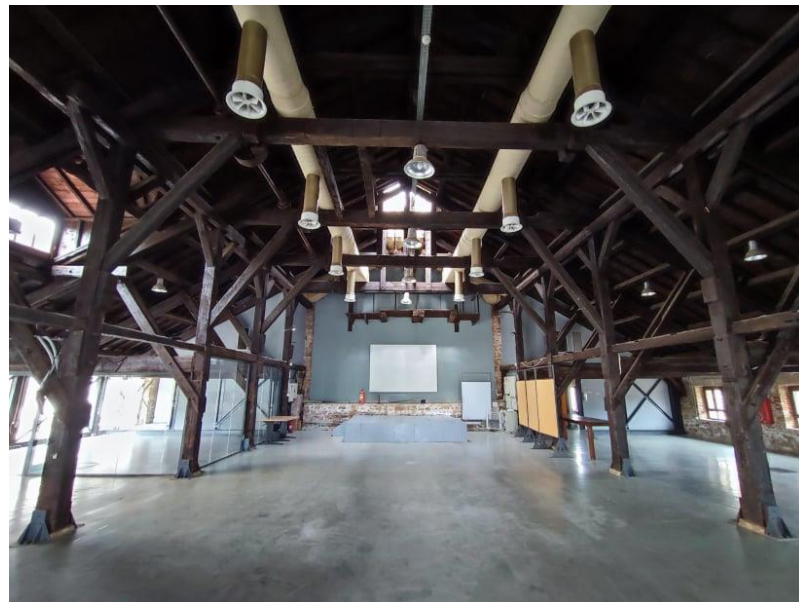
Εικόνα 5.5: Εσωτερική επισκόπηση πολυχώρου, «Κεντρική Σάλα» [Ιδία Επεξεργασία].
