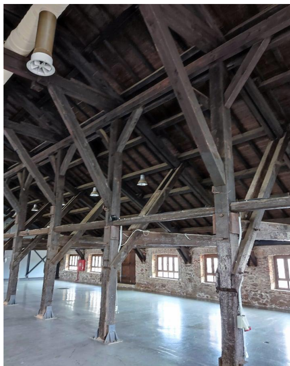
Εικόνα 5.6: Εσωτερική επισκόπηση πολυχώρου, «Κεντρική Σάλα» [Ιδία Επεξεργασία].
