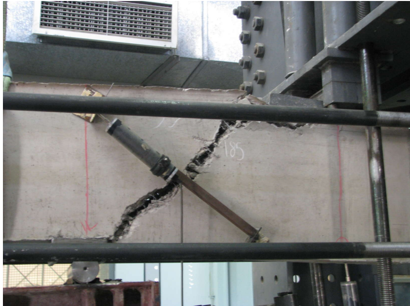
Εικόνα 5.6.1.7: Εικόνα διατμητικής ρωγμής που προκάλεσε την αστοχία
