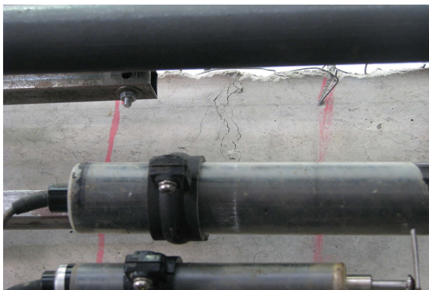
Εικόνα 5.5.1.5: Δημιουργία καμπτικής ρωγμής εντός της περιοχής καταγραφής των βελομέτρων
