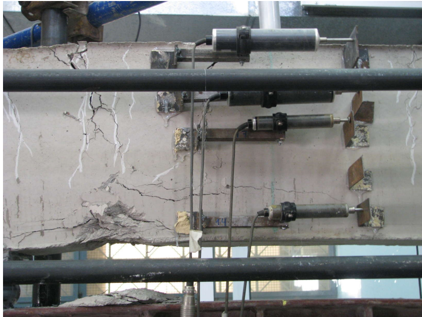
Εικόνα 5.5.1.7: Εικόνα καμπτικής ρωγμής που προκάλεσε την αστοχία αριστερά από την περιοχή των βελομέτρων
