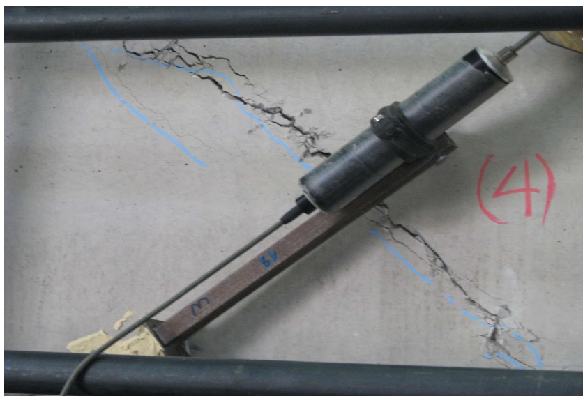
Εικόνα 5.3.1.4: Ταχεία επέκταση της διατμητικής ρωγμής στην αριστερή πλευρά του δοκιμίου
