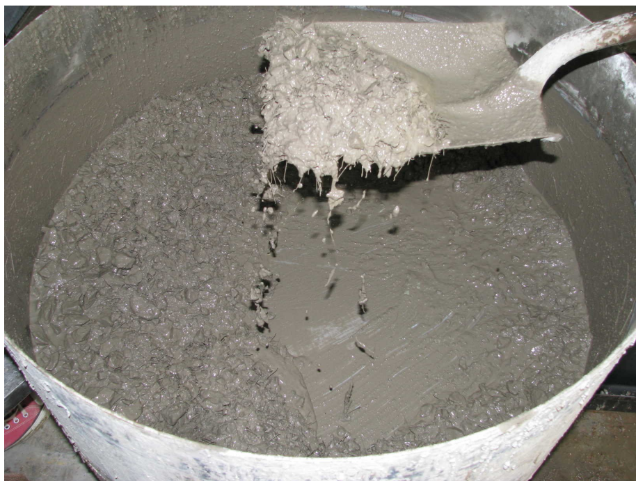
Εικόνα 3.1.5: Τελικό μείγμα ινοπλισμένου σκυροδέματος
