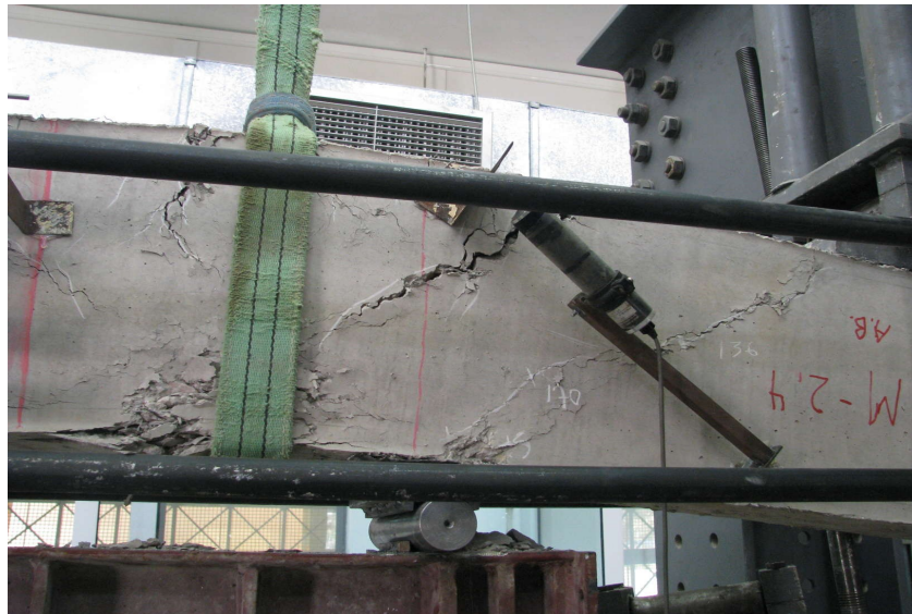
Εικόνα 5.7.1.7: Συνδυασμός ρωγμών που προκάλεσαν την αστοχία
