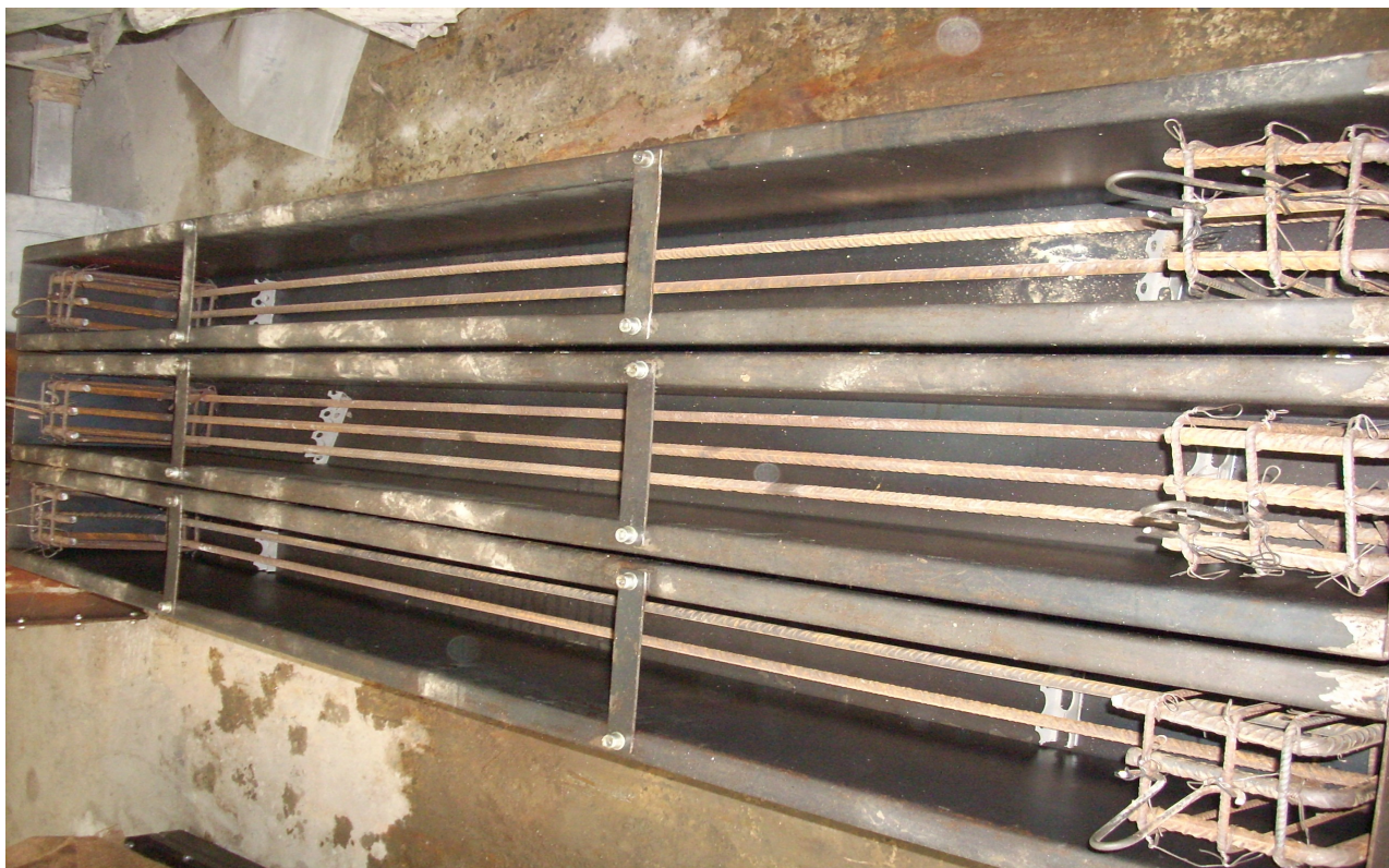
Εικόνα 3.1.1: Σιδηρότυποι δοκών πριν τη σκυροδέτηση
