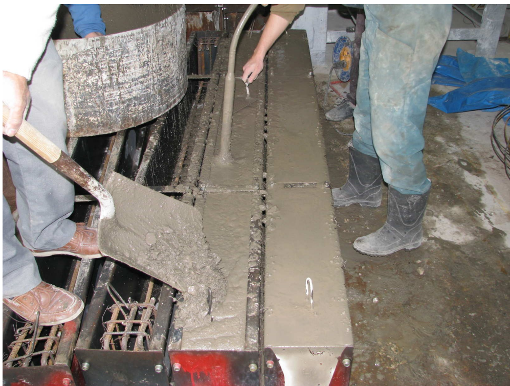
Εικόνα 3.1.6: Τοποθέτηση στα καλούπια και δόνηση του σκυροδέματος
