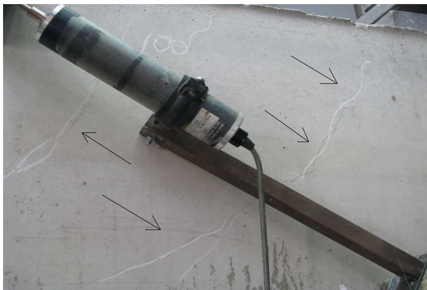
Εικόνα 5.5.1.2: Εμφάνιση διατμητικών ρωγμών δεξιά
