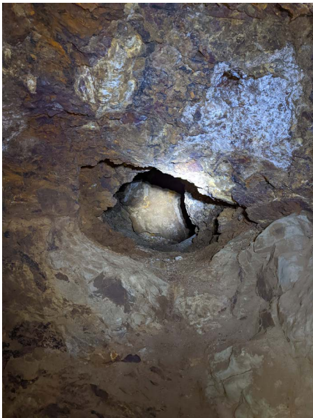
Εικ. 3.4: Καμινάδα αερισμού
