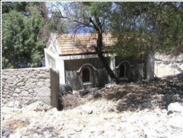
Εικόνα 19. Η νότια πλευρά του ναού (φωτ. Ν. Πιτσινός 2007, πηγή: Σιγάλα Μ., 2011)
