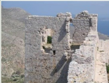
Figure 3. Πύργος από τη Β πλευρά του Φρουρίου (πηγή: Σιγάλα Μ., 2011)
