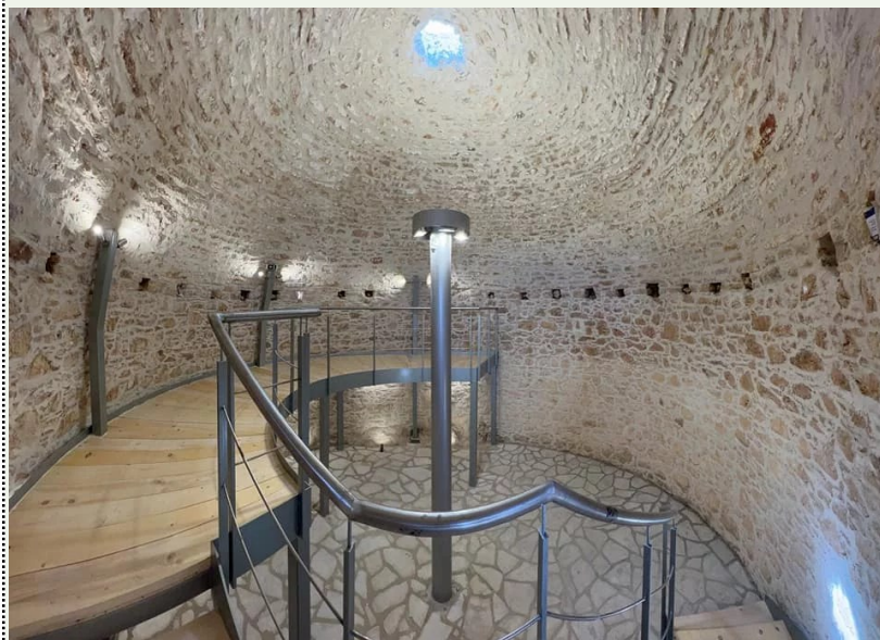
Figure 20. Το εσωτερικό της δεξαμενής μετά τις εργασίες αποκατάστασης (πηγή: Ιστοσελίδα Δήμου Χάλκης)
