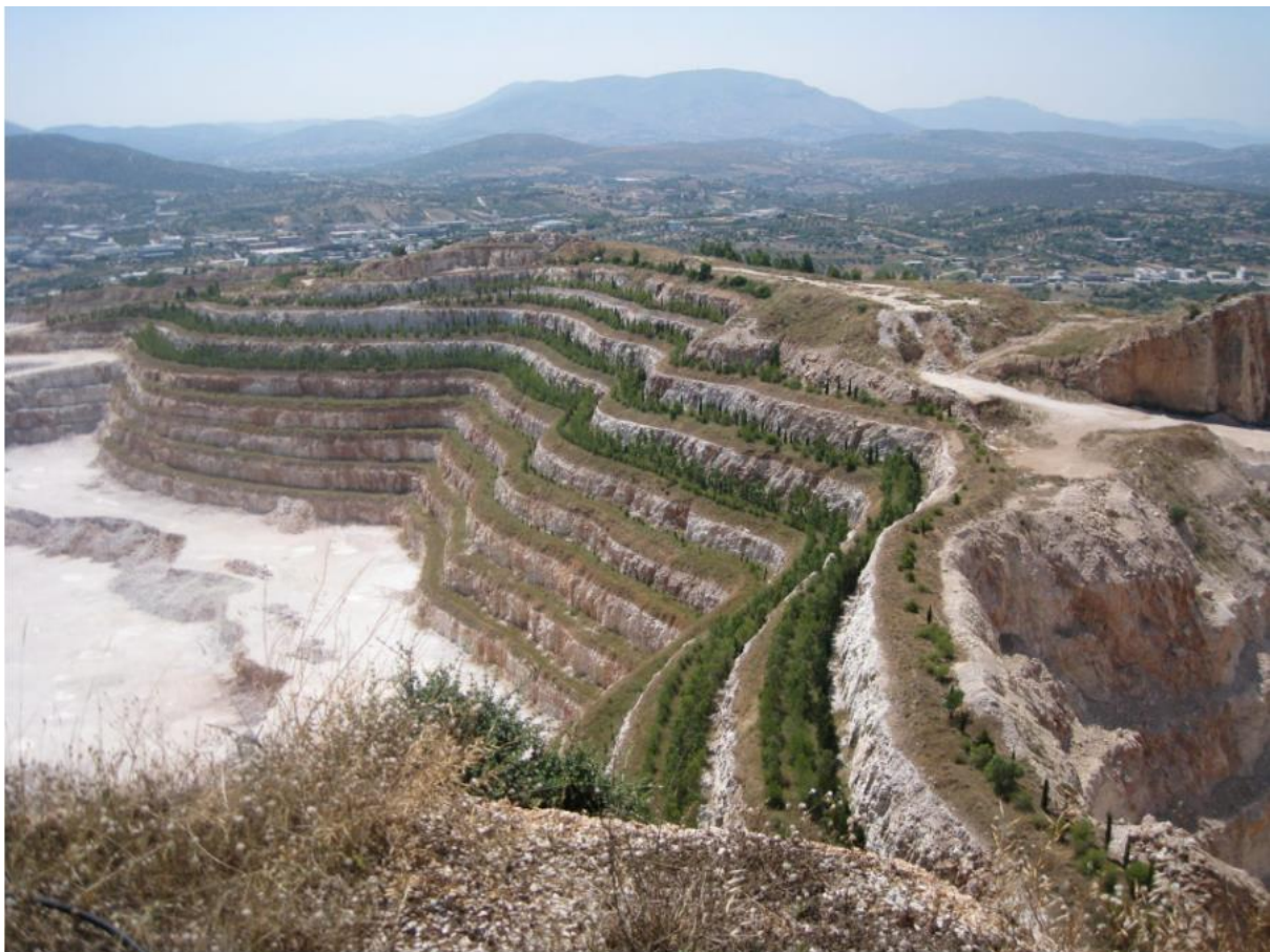
ΕΙΚΟΝΑ 10: ΑΠΟΚΑΤΑΣΤΑΣΗ ΑΝΕΝΕΡΓΟΥ ΛΑΤΟΜΕΙΟΥ (ORYKTOSPLOUTOS.NET)
