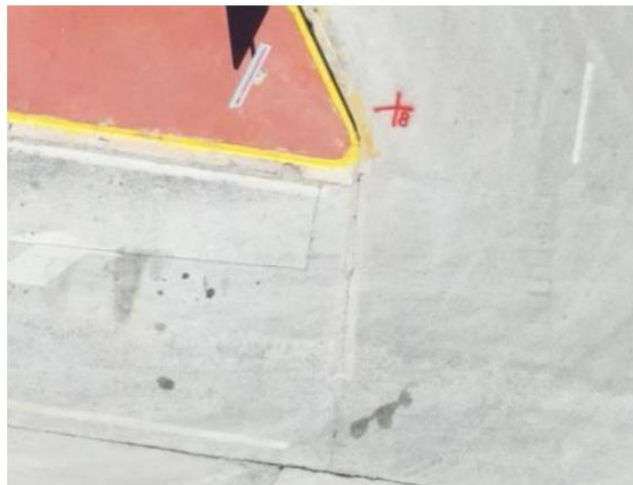
Εικόνα 5.7 Σημείο ελέγχου στο λιμάνι του Λαυρίου (Τσάιμου, 2022)
