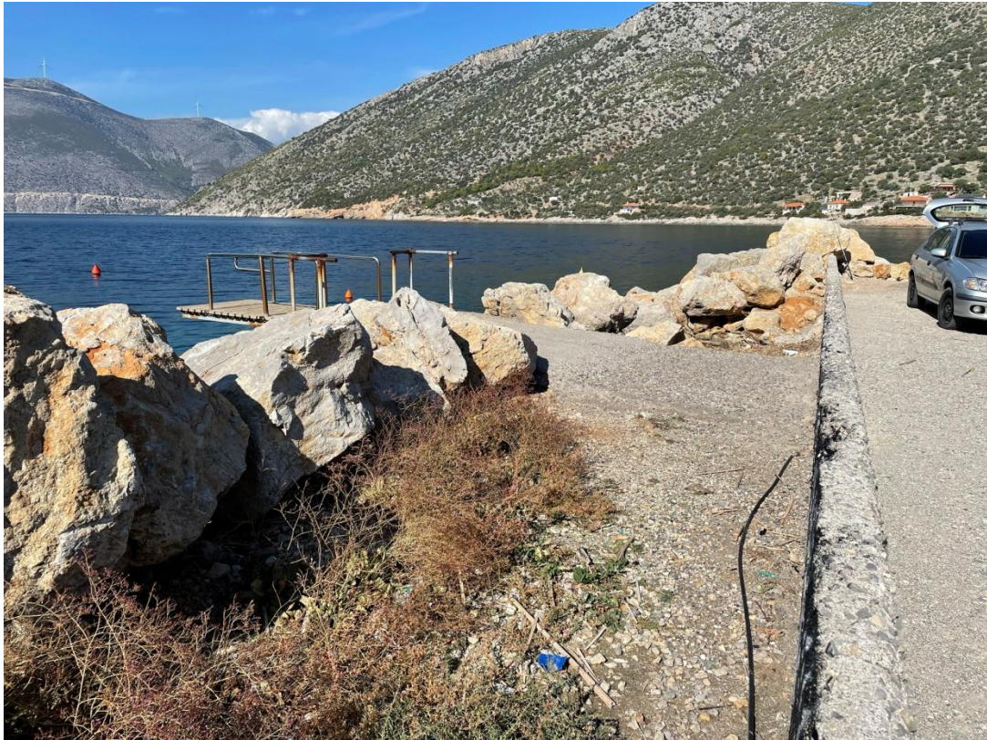
Εικόνα 4.30 Λιθορριπή και προφυλακτήριος τοίχος αλιευτικού καταφυγίου Αγίου Βασιλείου (ΕΛΕ, 2021)
