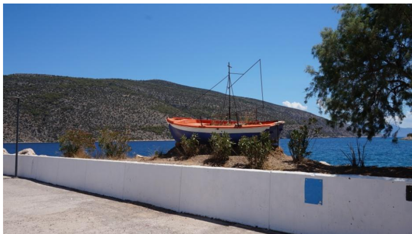
Εικόνα 5.5 Εξωτερικό έργο προφυλακτήριου τοίχου στο αλιευτικό καταφύγιο Παραλίας Σαράντη
