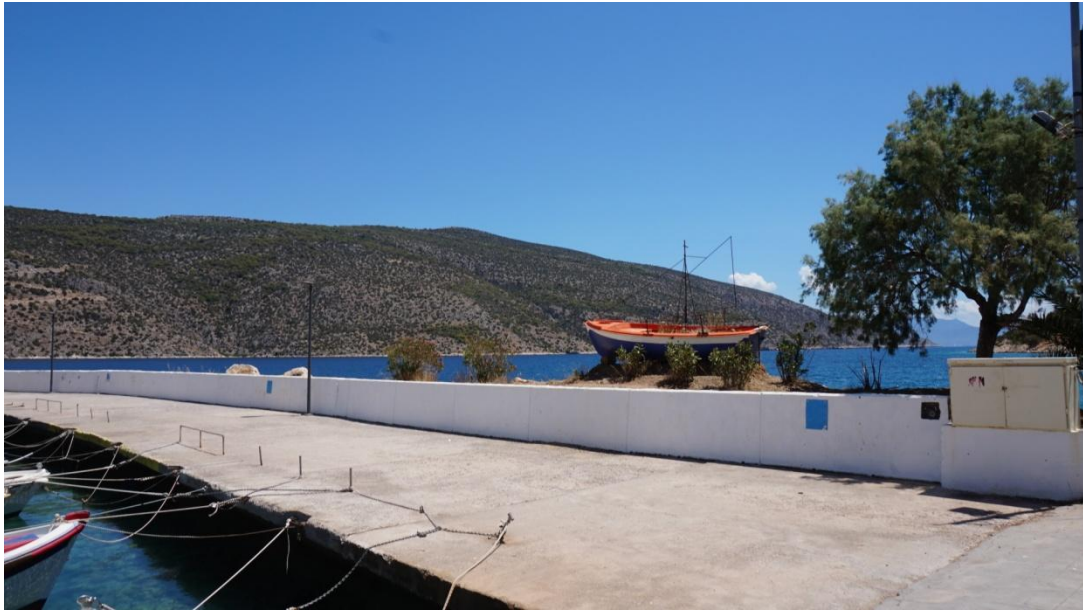
Εικόνα 4.7 Αποβάθρα και προφυλακτήριος τοίχος αλιευτικού καταφυγίου Παραλίας Σαράντη (ΕΛΕ, 2021)
