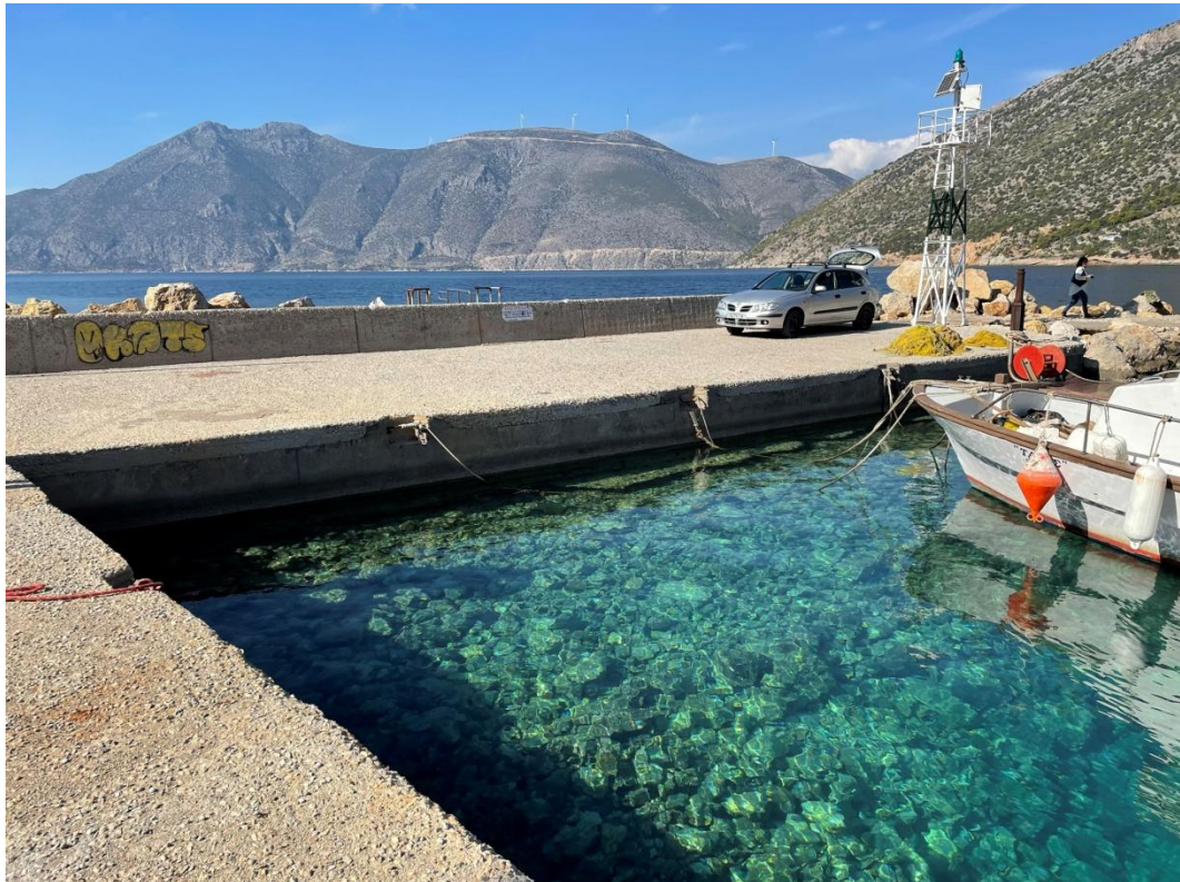
Εικόνα 4.27 Προσήνεμος μόλος και προφυλακτήριος τοίχος Αγίου Βασιλείου (ΕΛΕ, 2021)
