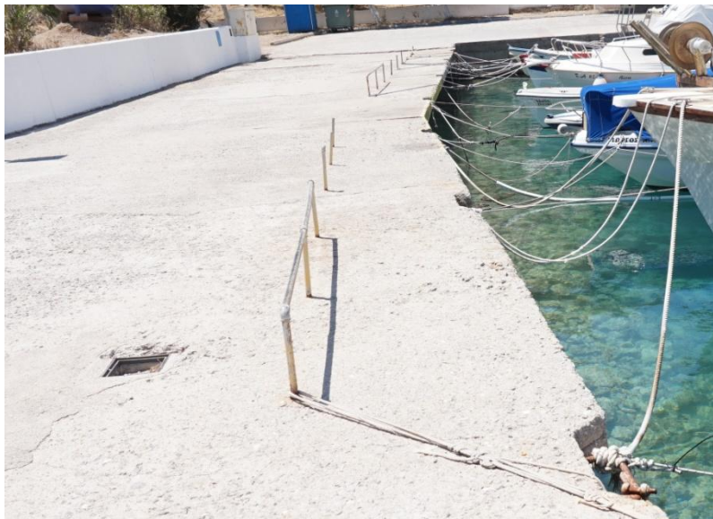
Εικόνα 6.1 Επιφάνεια προβλήτα αλιευτικού καταφυγίου Παραλίας Σαράντη με ρηγματώσεις
