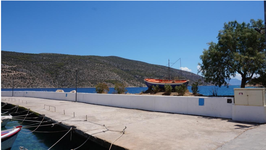
Εικόνα 6.6 Προφυλακτήριος τοίχος αλιευτικού καταφυγίου Παραλίας Σαράντη
