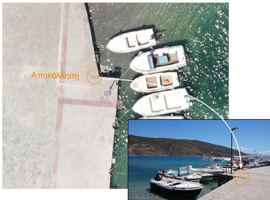
Εικόνα 6.3 Αποκόλληση προβλήτα αλιευτικού καταφυγίου Παραλίας Σαράντη
