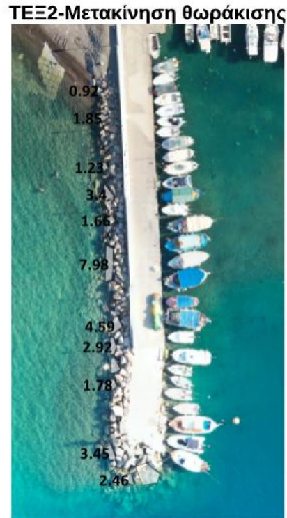
Εικόνα 6.15 Μετακίνηση θωράκισης στο αλιευτικό καταφύγιο Αλυκής (ΤΕΞ2)
