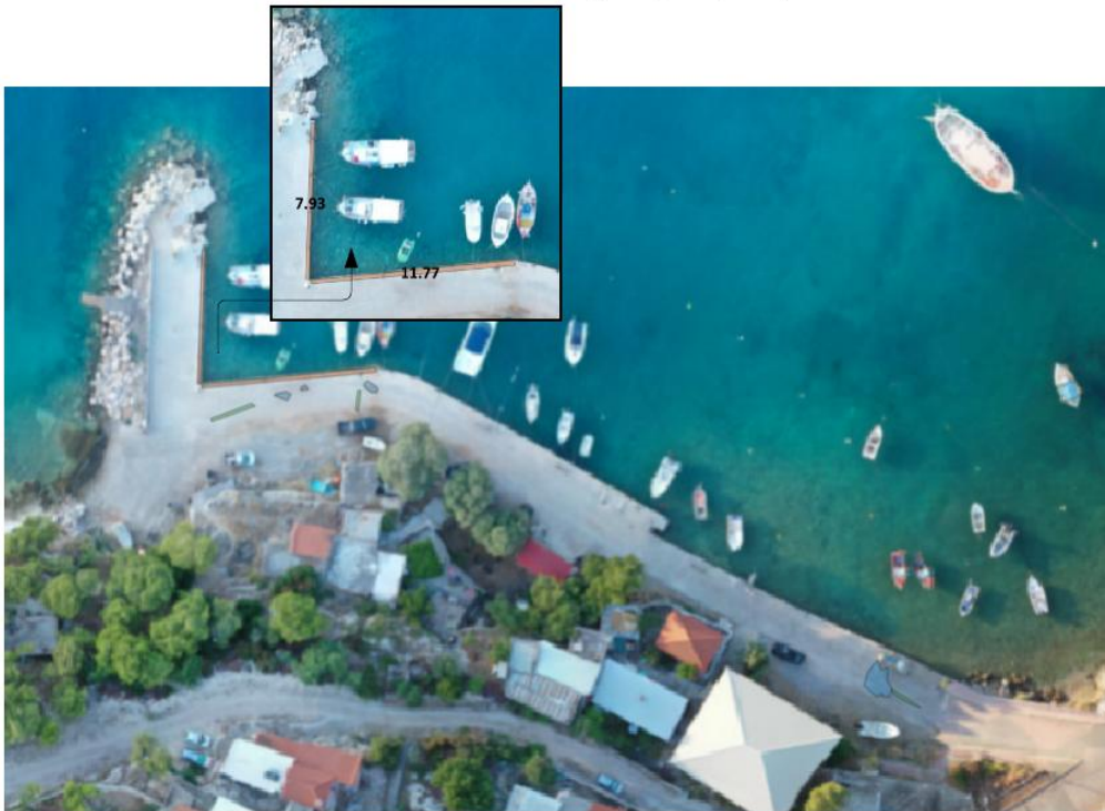
Εικόνα 6.19 Αποκόλληση σκυροδέματος στο αλιευτικό καταφύγιο Αγίου Βασιλείου (ΤΕΣ3)
