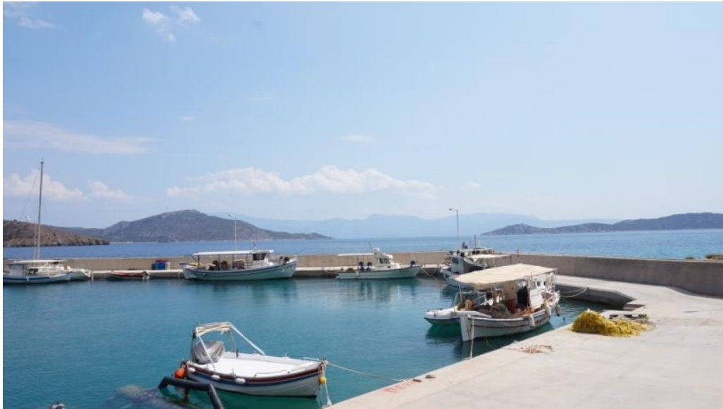
Εικόνα 6.11 Προφυλακτήριος τοίχος αλιευτικού καταφυγίου Αγίου Νικολάου
