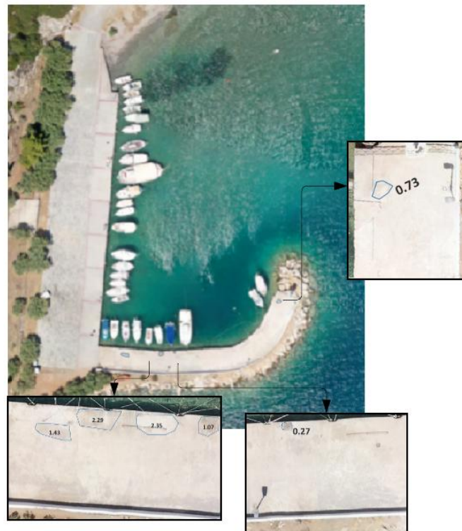
Εικόνα 6.2 Διάβρωση προβλήτα αλιευτικού καταφυγίου Παραλίας Σαράντη (ΤΕΣ2)
