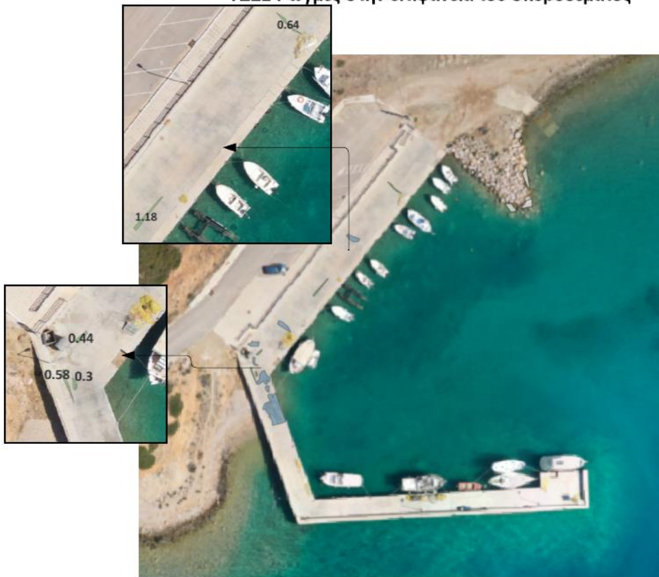
Εικόνα 6.8 Ρωγμές στην επιφάνεια του σκυροδέματος στο αλιευτικό καταφύγιο Αγίου Νικολάου (ΤΕΣ1)
