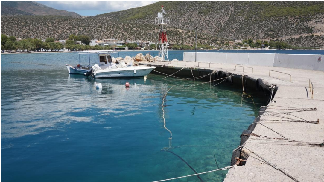
Εικόνα 4.9 Προσήνεμος μόλος και δέστρες αλιευτικού καταφυγίου Παραλίας Σαράντη (ΕΛΕ, 2021)
