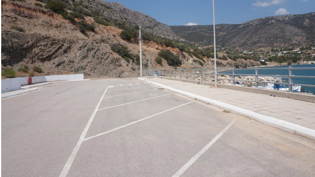
Εικόνα 4.15 Δάπεδο στάθμευσης στο αλιευτικό καταφύγιο Αγίου Νικολάου (ΕΛΕ, 2021)
