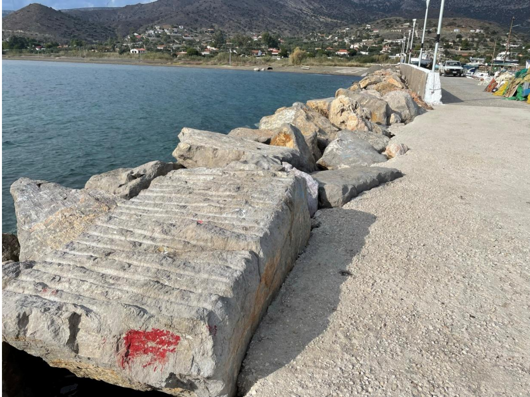
Εικόνα 4.19 Προφυλακτήριος τοίχος και θωράκιση αλιευτικού καταφυγίου Αλυκής (ΕΛΕ, 2021)
