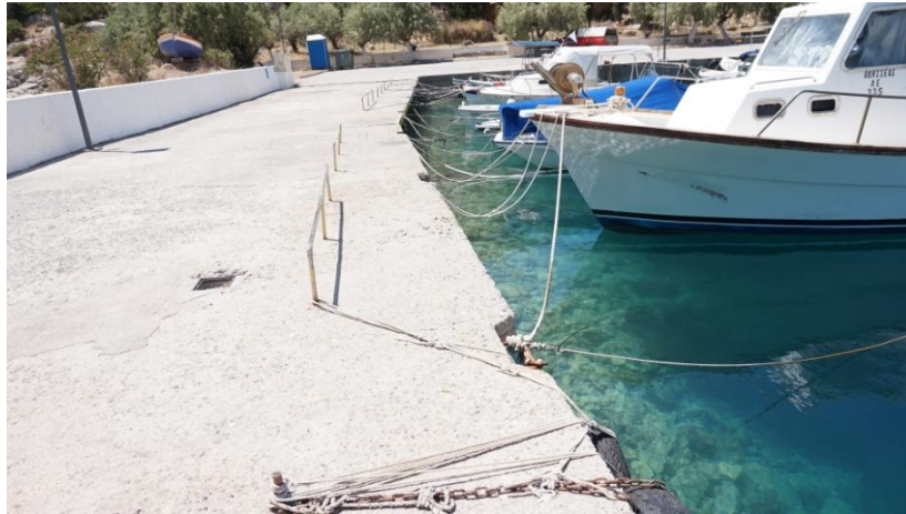
Εικόνα 5.3 Εσωτερικό έργο προβλήτα στην Παραλία Σαράντη
