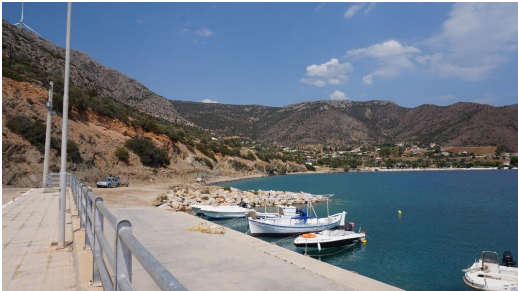
Εικόνα 4.14 Υπήνεμος μόλος στο αλιευτικό καταφύγιο Αγίου Νικολάου (ΕΛΕ, 2021)
