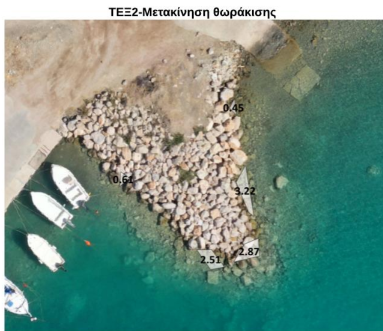
Εικόνα 6.10 Μετακίνηση θωράκισης υπήνεμου μόλου αλιευτικού καταφυγίου Αγίου Νικολάου
