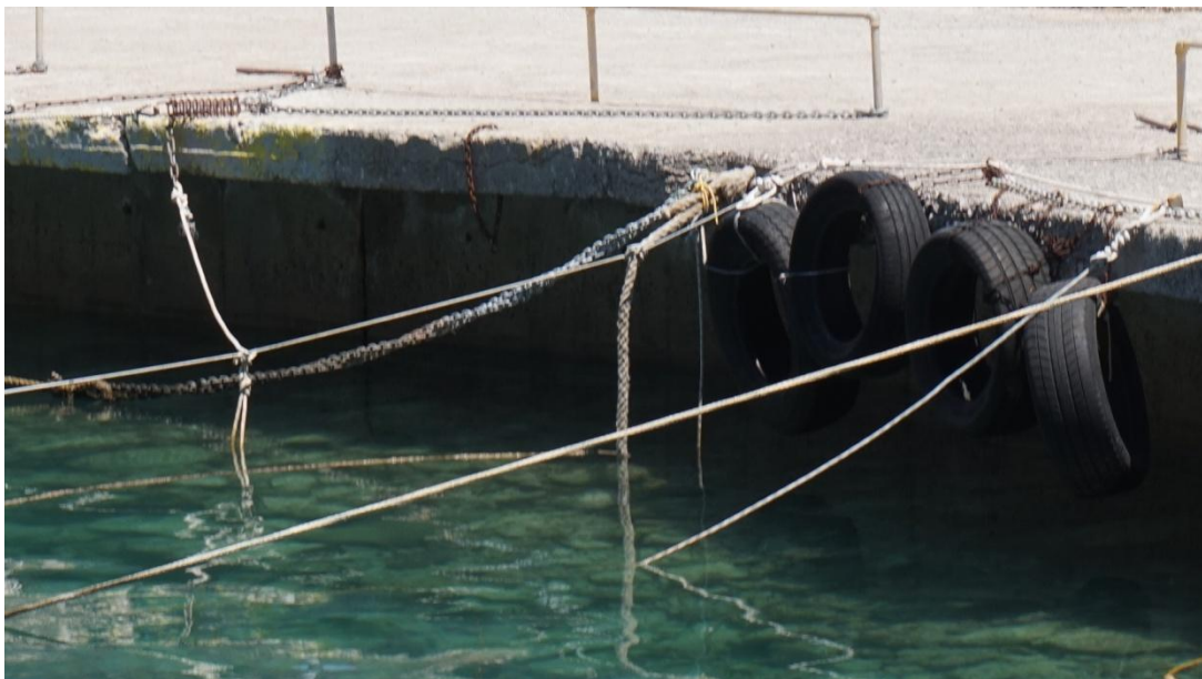
Εικόνα 4.10 Αποβάθρα και κρηπιδότοιχος αλιευτικού καταφυγίου Παραλίας Σαράντη (ΕΛΕ, 2021)
