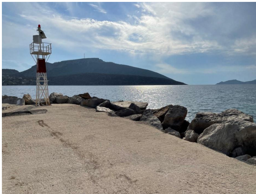
Εικόνα 5.4 Εξωτερικό έργο κυματοθραύστη με θωράκιση στο αλιευτικό καταφύγιο Αλικής
