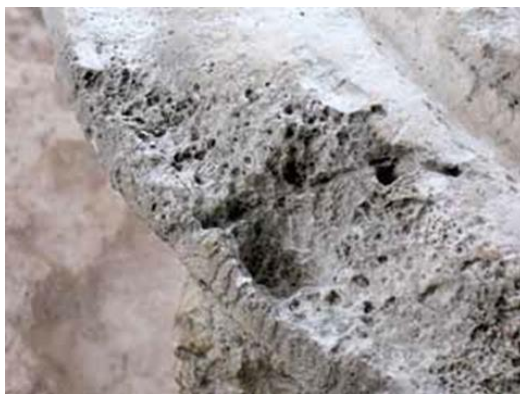
Εικ.17. Τυπική φθορά της γύψου μετά από παρατεταμένη έκθεση στο νερό [15].
