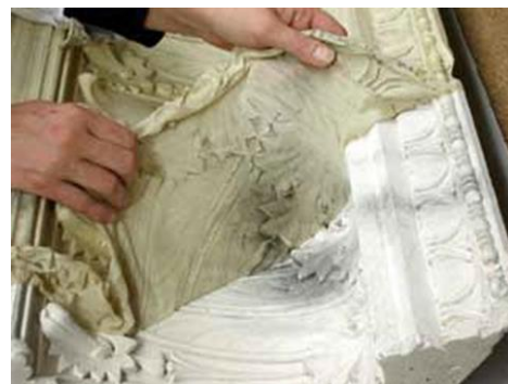
Εικ.23. Κατά την αφαίρεση αυτοβουλκανιζόμενης πάστας από «λάτεξ» που εφαρμόστηκε για καθαρισμό [15].
