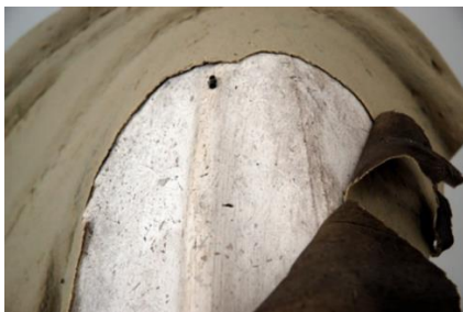
Εικ. 20. Καθαρισμός με επίθεμα σε γύψινη επιφάνεια. Η επιφανειακή ρύπανση διαχωρίζεται από την επιφάνεια κατά την αφαίρεση του επιθέματος [2].
