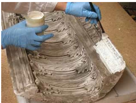
Εικ.22. Κατά την εφαρμογή αυτοβουλκανιζόμενης πάστας από «λάτεξ» που εφαρμόστηκε για καθαρισμό σε γύψινο αντικείμενο χωρίς επικαλύψεις [15].
