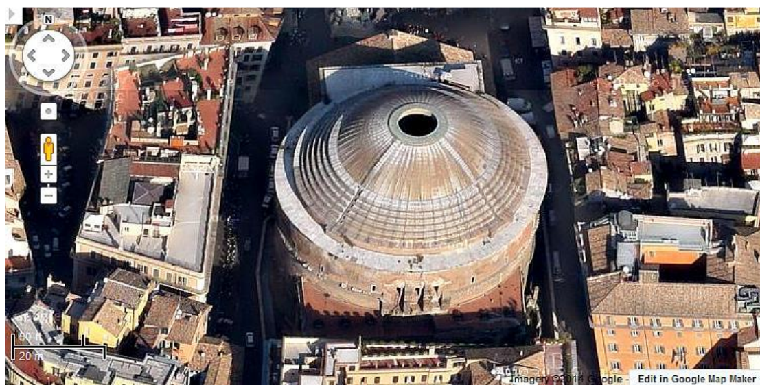
Εικόνα 2.3: Η τσιμεντένια θόλος του Πανθέου, με τον γνωστό οφθαλμό (occulus, φωτ. από το άρθρο “Some Notes on Ancient Concrete”)
