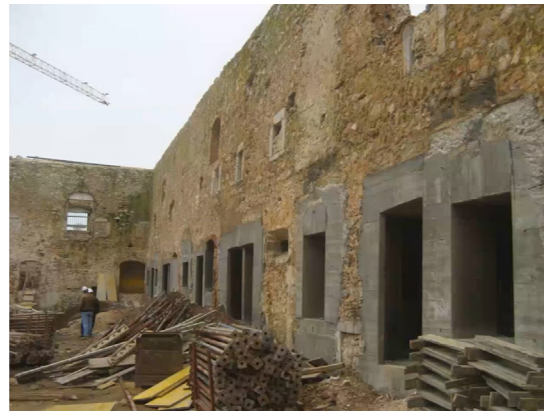
Εικ.83 Εργασίες αποκατάστασης στην εσωτερική αυλή του μοναστηριού Bernardas
