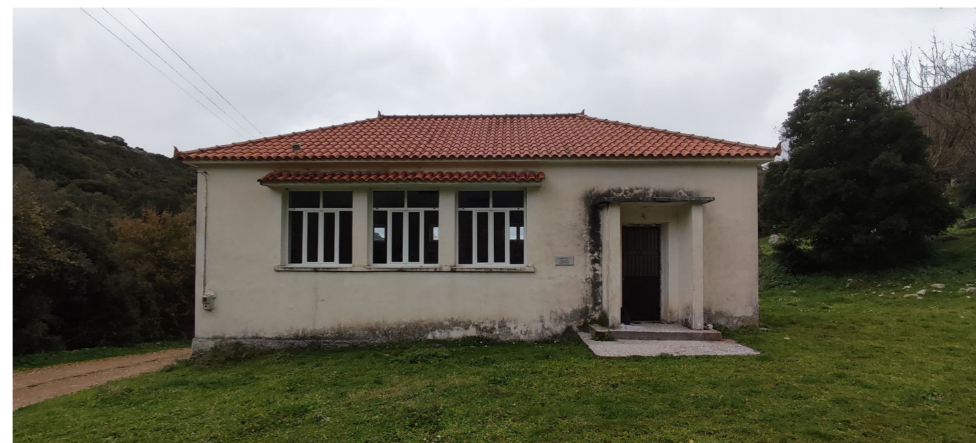
Εικ.99 Ρωμύρι, Νέο σχολείο, υπάρχουσα κατάσταση
