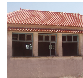
Επαναφορά ξύλινων κουφωμάτων, σε λουλακί χρωματισμό
