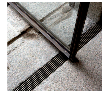
Ελάχιστες μεταλλικές διατομές στην φυσική απόχρωση του σιδήρου.
