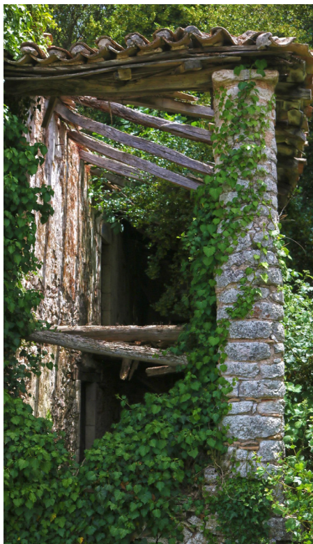
Εικ.9 Λεπτομέρεια πατώματος και στέγης
