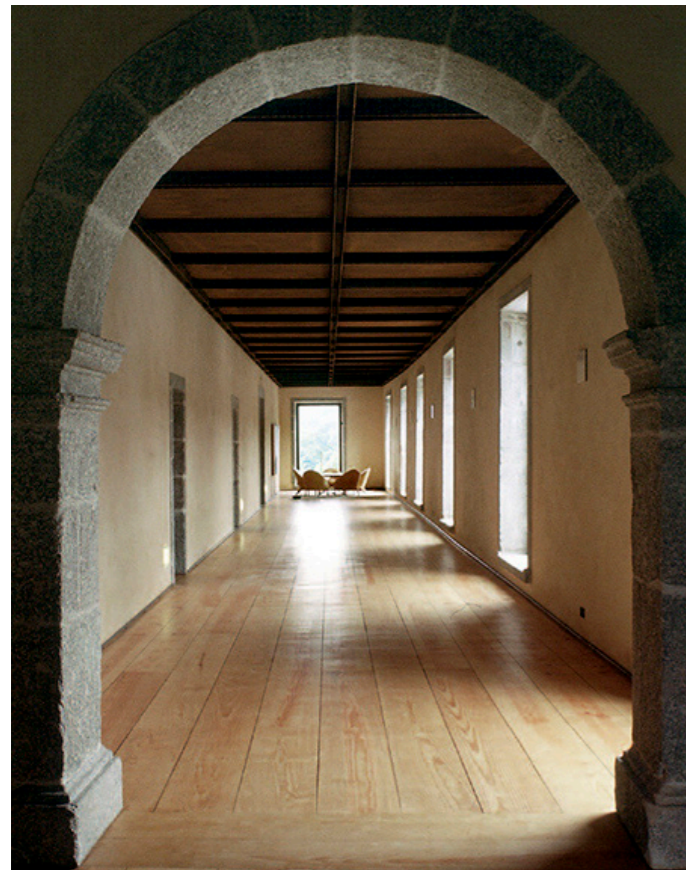
Εικ.72 Σοβάς σε υπόλευκο χρώμα και ξύλινο δάπεδο στο εσωτερικό του κτηρίου στο συγκρότημα Santa Maria do Bouro
