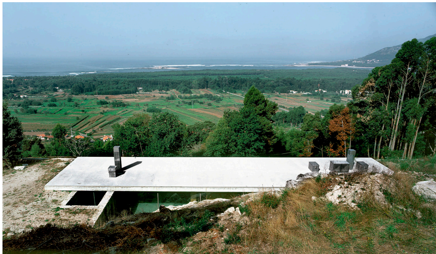
Εικ.91 Η νέα οριζόντια βατή πλάκα από οπλισμένο σκυρόδεμα, ως στέγαση της κατοικίας, αποκαθιστώντας το έδαφος του υπερκείμενου αναβαθμού
