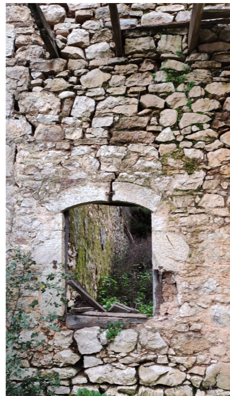
Εικ.11 Ημικυκλικά διαμορφωμένο πρέκι, μη αποκατεστημένο κτήριο
