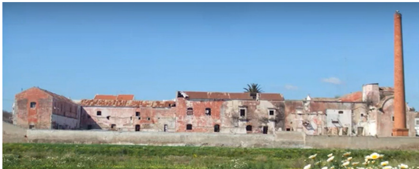
Εικ.77 Ανατολική όψη για του μοναστηριού Bernardas πριν την αποκατάσταση
