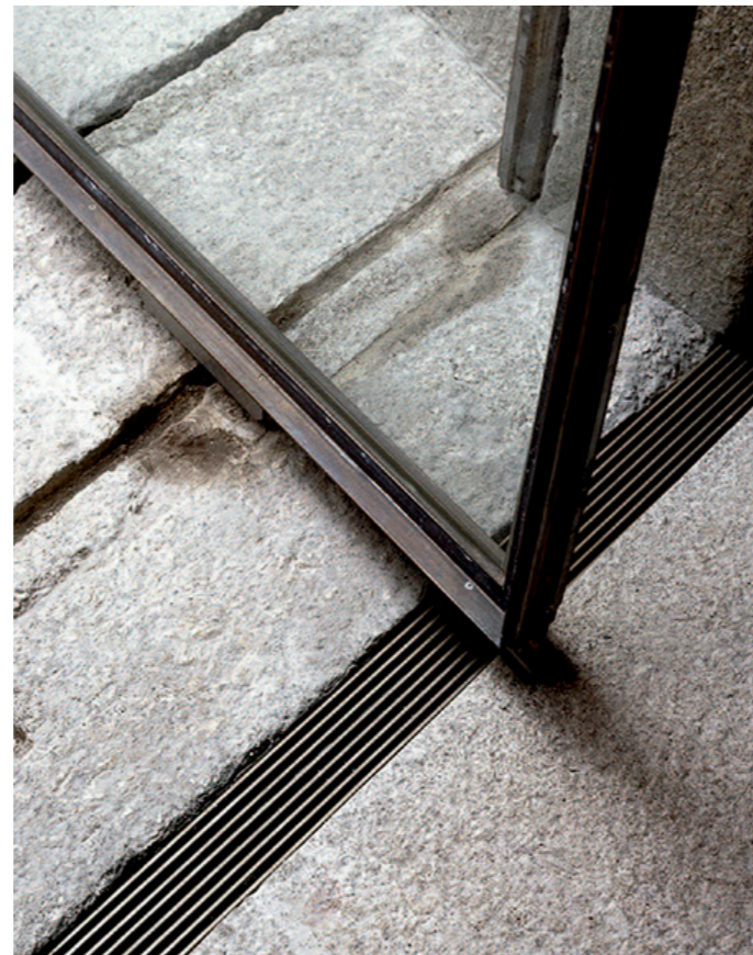
Εικ.73 Οικοδομική λεπτομέρεια επεξεργασία των ανοιγμάτων με σύγχρονες, σύγχρονες, μεταλλικές διατομές εσωτερικά του συγκροτήματος Santa Maria do Bouro
