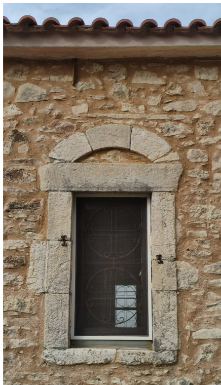
Εικ.10 Ημικυκλικά διαμορφωμένο πρέκι, αποκατεστημένος Ναός
