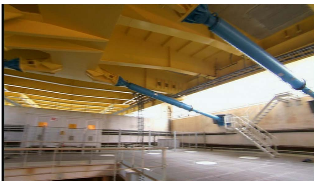
Σχήμα 1.13 : Σύνδεση καταστρώματος-πυλώνων στη γέφυρα Ρίου-Αντιρρίου
