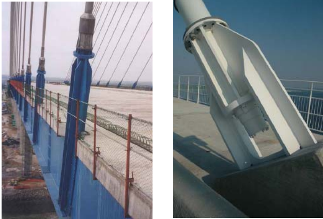
Σχήμα 1.8: Αγκυρώσεις καλωδίων επί του καταστρώματος 1.6 Κατάστρωμα
