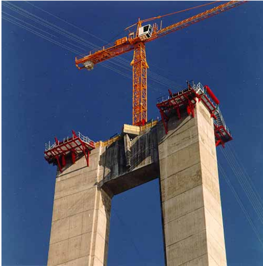
Σχήμα 1.5: Ανέγερση πυλώνα μορφής Α
