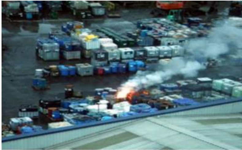
Εικόνα 2.3 Ατύχημα σε εγκατάσταση διαχείρισης αποβλήτων όταν απόβλητο αντέδρασε με νερό - Cannock της Αγγλίας – Σεπτέμβριος 2006
