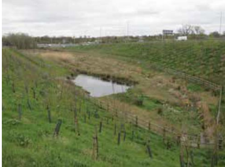
Σχ. 4. Υγρότοπος για αποστράγγιση δρόμου. Πηγή: (Woods-Ballard et al., 2007)
