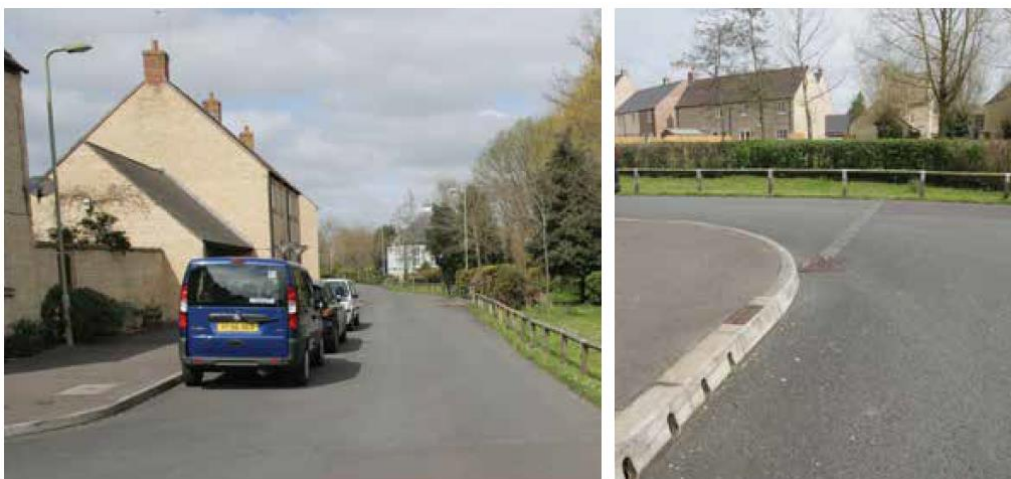
Σχ. 11. Αποστράγγιση από κράσπεδο και κανάλι συνδεδεμένο σε τάφρο. Πηγή: (Woods-Ballard et al., 2007)
