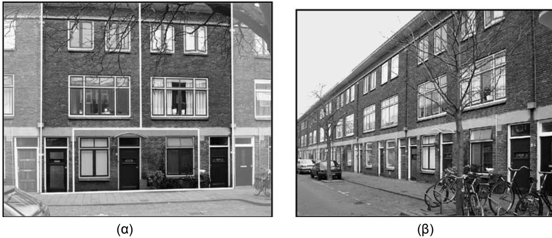
Εικόνα 1.6. (α) Παράδειγμα του κτιριακού συγκροτήματος και (β) επισκόπηση της γύρω περιοχής
