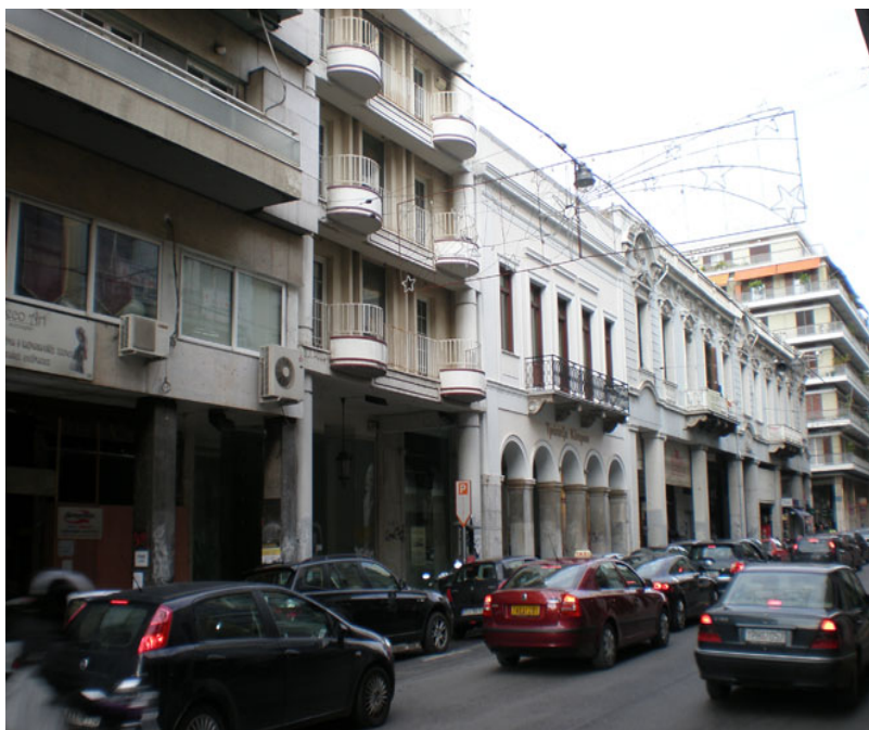
Εικόνα 2.15. Παρόδιες στοές που ανήκουν εντός των ορίων των ιδιόκτητων κτιριακών εγκαταστάσεων
