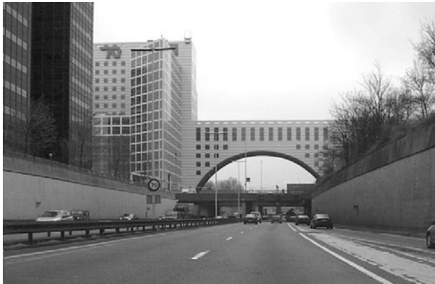
Εικόνα 1.15. Σύνθετο κτιριακό συγκρότημα χτισμένο πάνω από δρόμο
