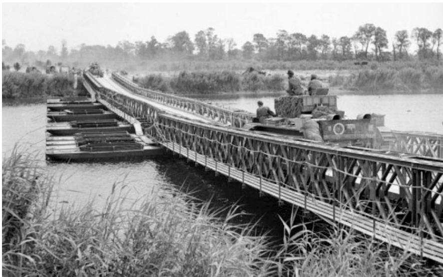
Σχήμα 6.1. Διέλευση τεθωρακισμένου οχήματος από γέφυρα τύπου Bailey κατά τον Β' παγκόσμιο πόλεμο
