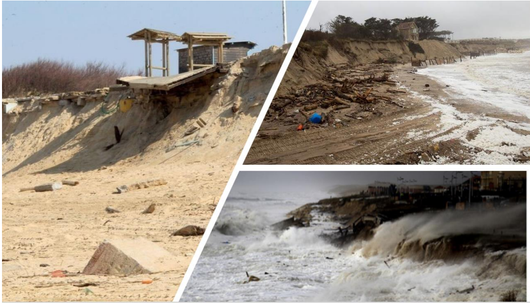
Εικόνα 1 Παράκτια διάβρωση και καταστροφές υποδομών στη νοτιοδυτική πλευρά της Γαλλίας το χειμώνα του 2013/2014
