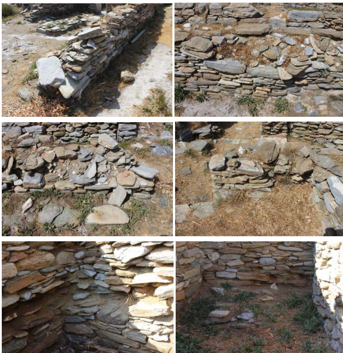
Εικόνες 2.26 - 2.28 : Αποδιοργάνωση τοιχοποιίας στην βορειοανατολική εξωτερική τοιχοποιία.
