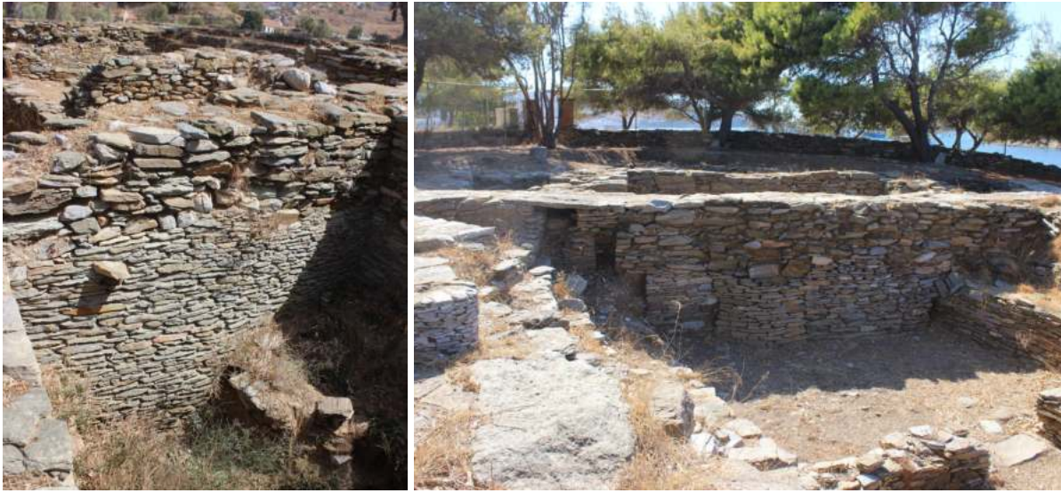
Εικόνες 2.5 - 2.6 : Προσθήκες νέας τοιχοποιίας σε αρχαίους τοίχους.
