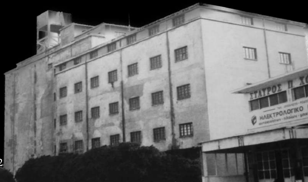
Εικόνα 2.71 | Η είσοδος στην Αλευροβιομηχανία SAMICA
