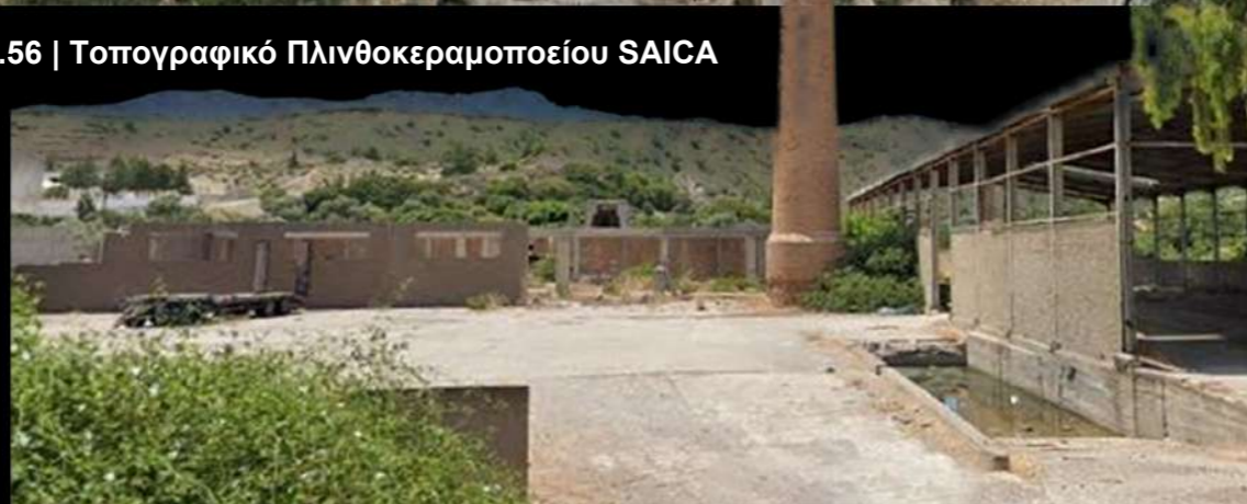
Εικόνα 2.57 | Κάμινος συνεχούς καύσεων τύπου Hofmann ύψους 45 μέτρων
