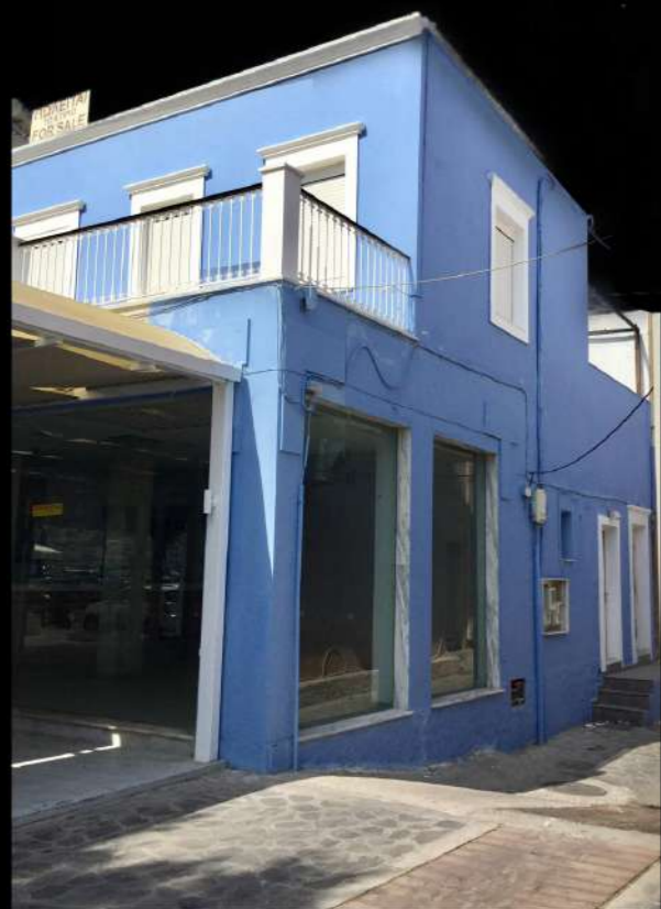
Εικόνα 2.121 | Μετά την Κατεδάφιση του 1985
