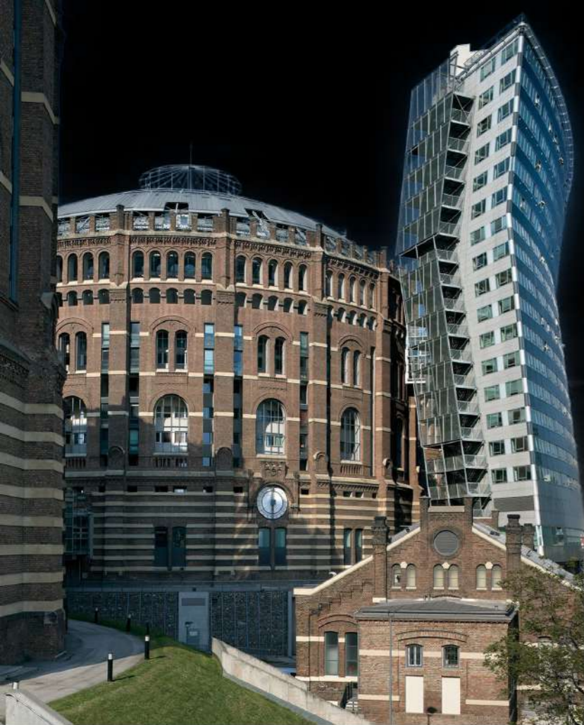
Εικόνα 3.13 | Εξωτερική άποψη δεξαμενής Β
