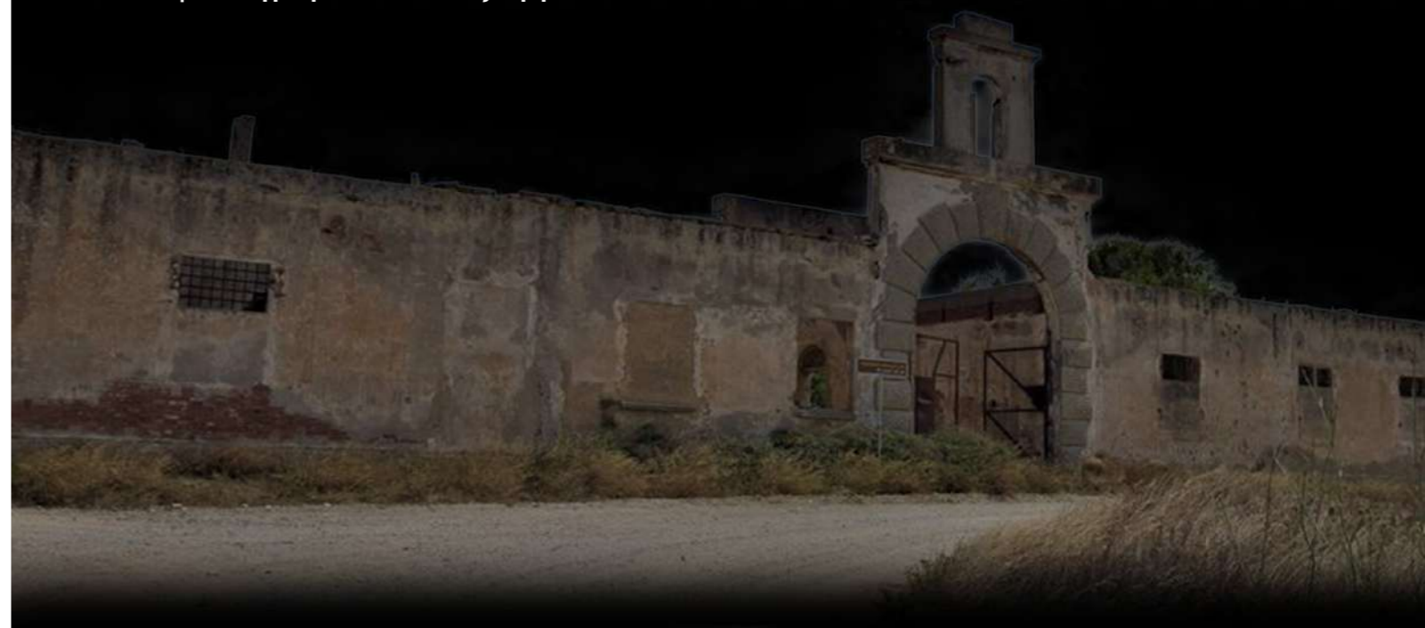
Εικόνα 2.13 | Η είσοδος στο Μεταξουργείο
