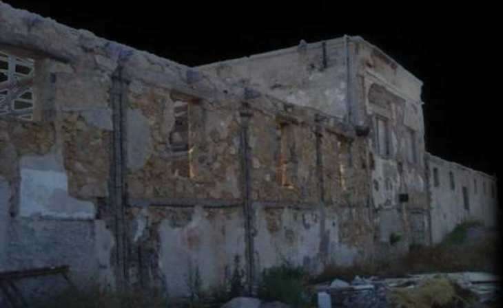
Εικόνα 2.62 | Άποψη του κεντρικού κτηρίου από την μεριά της θάλασσας (Ανατολικά)
