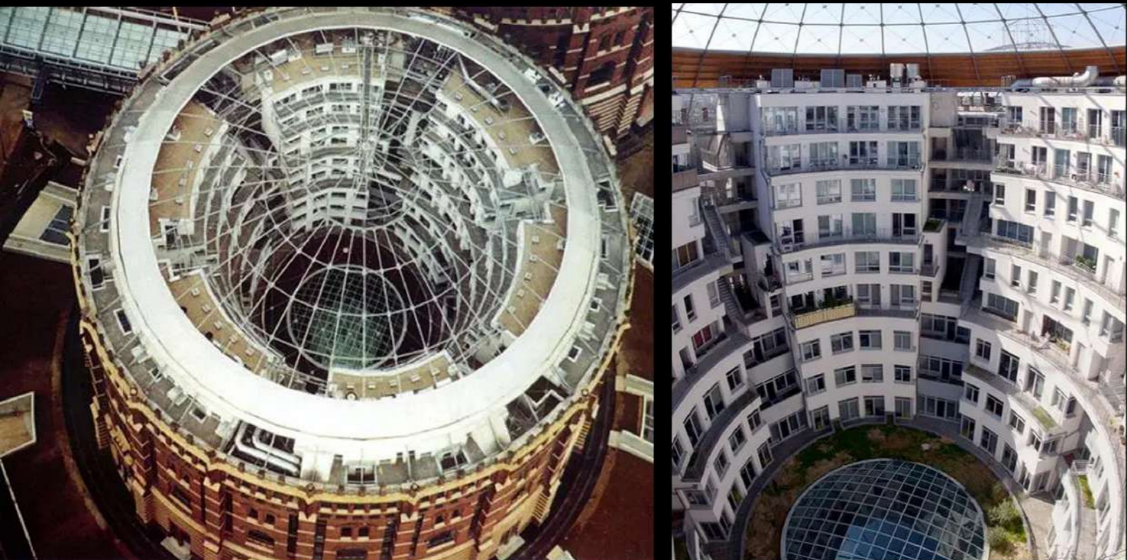
Εικόνα 3.11 | Εναέρια άποψη (αριστερά) και εσωτερική άποψη (δεξιά) από τη Δεξαμενή C
