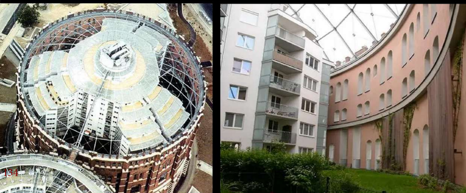
Εικόνα 3.12 | Εναέρια άποψη (αριστερά) και εσωτερική άποψη (δεξιά) από τη Δεξαμενή D
