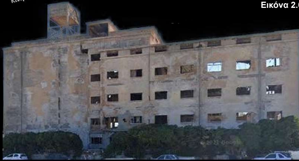
Εικόνα 2.70 | Επίχρισμα από finta pietra - Σημερινή κατάσταση
