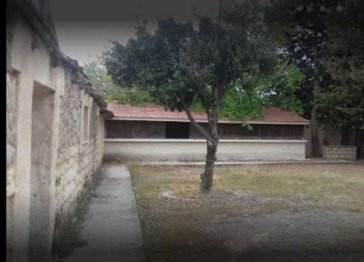
Εικόνα 2.43 | Επιχρισμένη (πριν) και ανεπίχρηστη (μετά) φέρουσα λιθοδομή του οινοποιείου στις Φάνες
