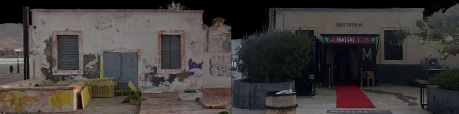
Εικόνα 2.77 | Βόρεια Όψη Δημοτικών Σφαγείων Κω (2008, 2022)
