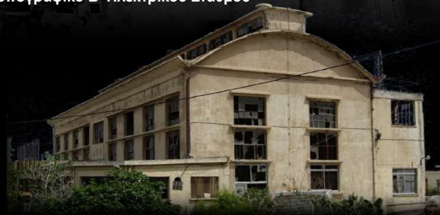
Εικόνα 2.8 | Ανατολική όψη Β' Ηλεκτρικού Σταθμού
