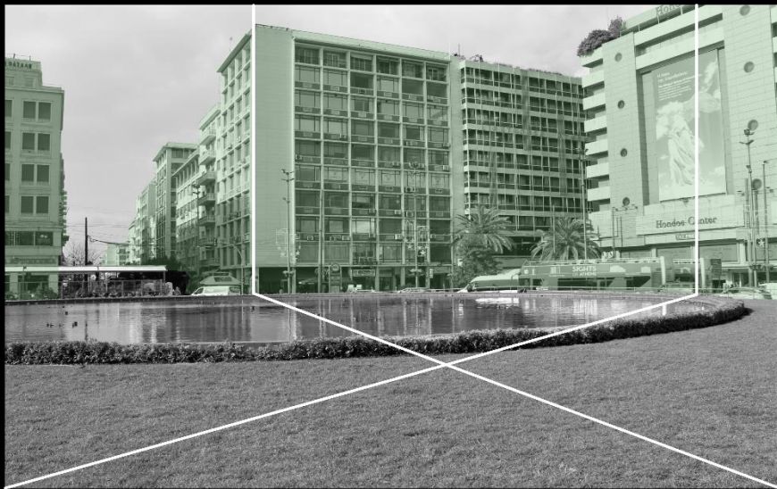
ΕΝΔΕΞΗ ΣΧΕΣΗΣ ΠΛΑΤΕΙΑΣ - ΚΤΗΡΙΑΚΩΝ ΜΕΤΩΠΩΝ
