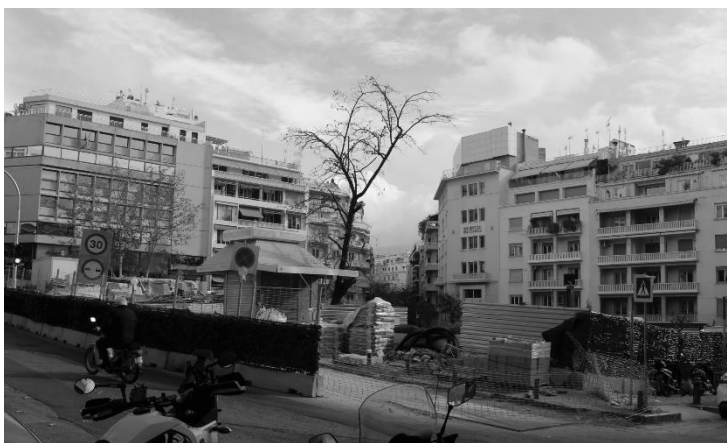
ΕΙΚΟΝΑ 1 – Πλατεία Κολωνακίου – εικόνα εργοταξίου για την κατασκευή του μετρό.
