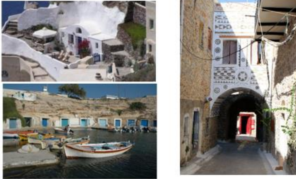
Εικόνα 30: Υπόσκαφο (πάνω) , σύρματα (κάτω) , καμάρα (δεξιά)
