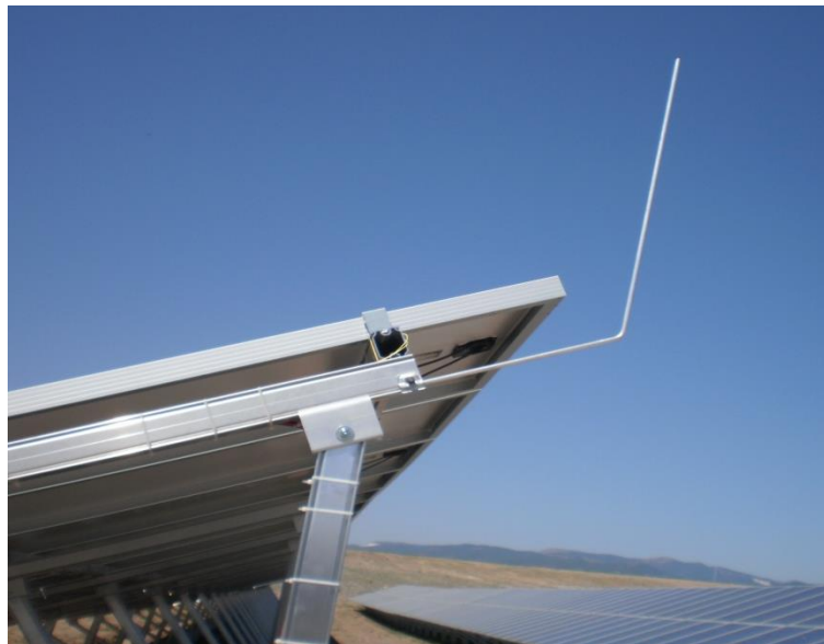
Σχήμα 4.6 Μη απομονωμένη ακίδα προσαρτημένη στη βάση στήριξης
