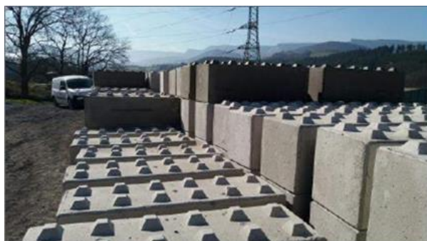
Εικόνα 23: α) αριστερά - Προκατασκευασμένα μπλοκ από σκυρόδεμα τύπου LEGO, β) δεξιά - Προκατασκευασμένα φρεάτια (Malumbres, 2017).
