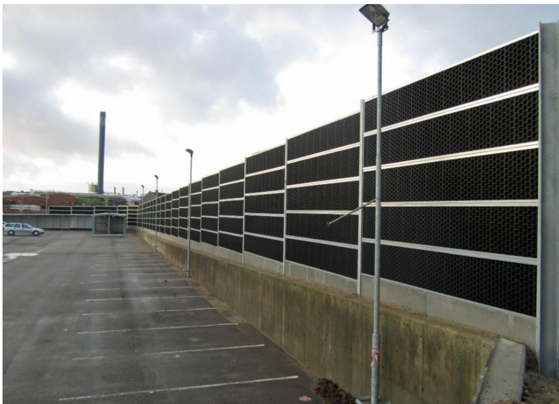
Εικόνα 25: Φράγματα μόνωσης θορύβου στο Θίστιντ ( Noise Barrier in Thisted 2019 - Miljøskærm , n.d.).
