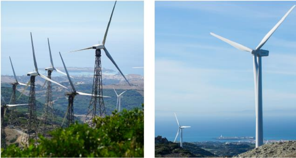
Εικόνα 15: Ανατροφοδότηση αιολικού πάρκου στην Ισπανία (WindEurope, 2020).
