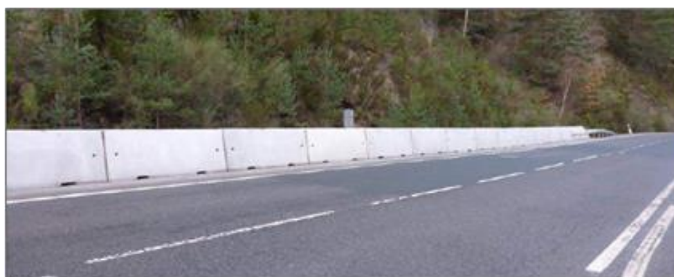
Εικόνα 24: Προστατευτικά κιγκλιδώματα από σκυρόδεμα (Malumbres, 2017).
