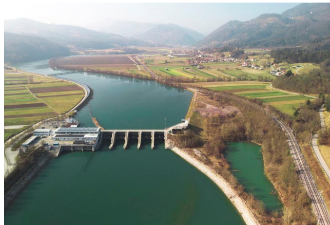
Εικόνα 1.5: Υδροηλεκτρικό Φράγμα στη Σλοβενία [5]
