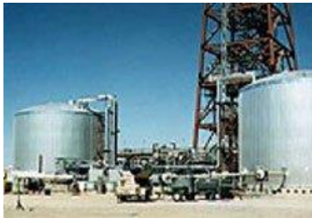
ΕΙΚΟΝΑ 13 ΣΥΣΤΗΜΑ ΑΠΕΥΘΕΙΑΣ ΑΠΟΘΗΚΕΥΣΗΣ ΘΕΡΜΙΚΗΣ ΕΝΕΡΓΕΙΑΣ ΔΥΟ ΔΕΞΑΜΕΝΩΝ. ΠΗΓΗ: « HTTPS://WWW.ENERGY.GOV/EERE/SOLAR/THERMAL-STORAGE-SYSTEM-CONCENTRATING-SOLAR-THERMAL-POWER-BASICS »
