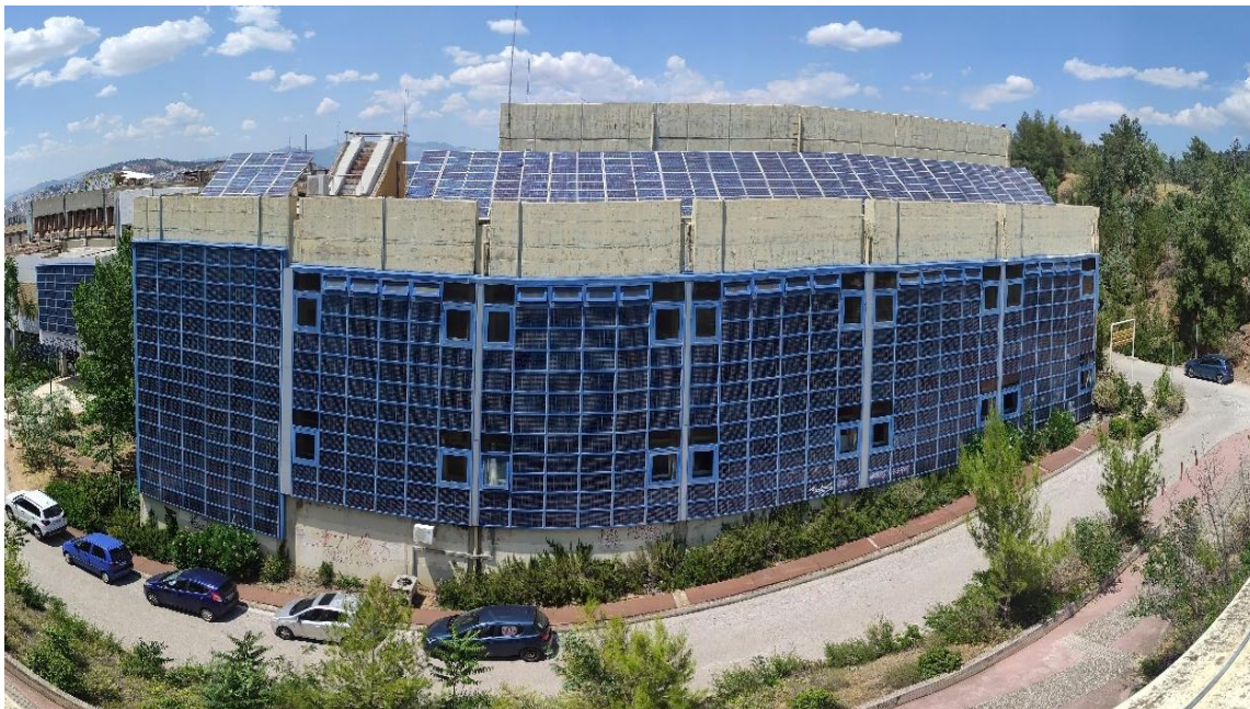
ΕΙΚΟΝΑ 19 ΦΩΤΟΒΟΛΤΑΪΚΑ ΣΥΣΤΗΜΑΤΑ ΣΤΗΝ ΤΑΡΑΤΣΑ ΤΟΥ ΚΤΗΡΙΟΥ ΤΟΥ ΤΜΗΜΑΤΟΣ ΧΗΜΙΚΩΝ ΜΗΧΑΝΙΚΩΝ ΕΜΠ.
