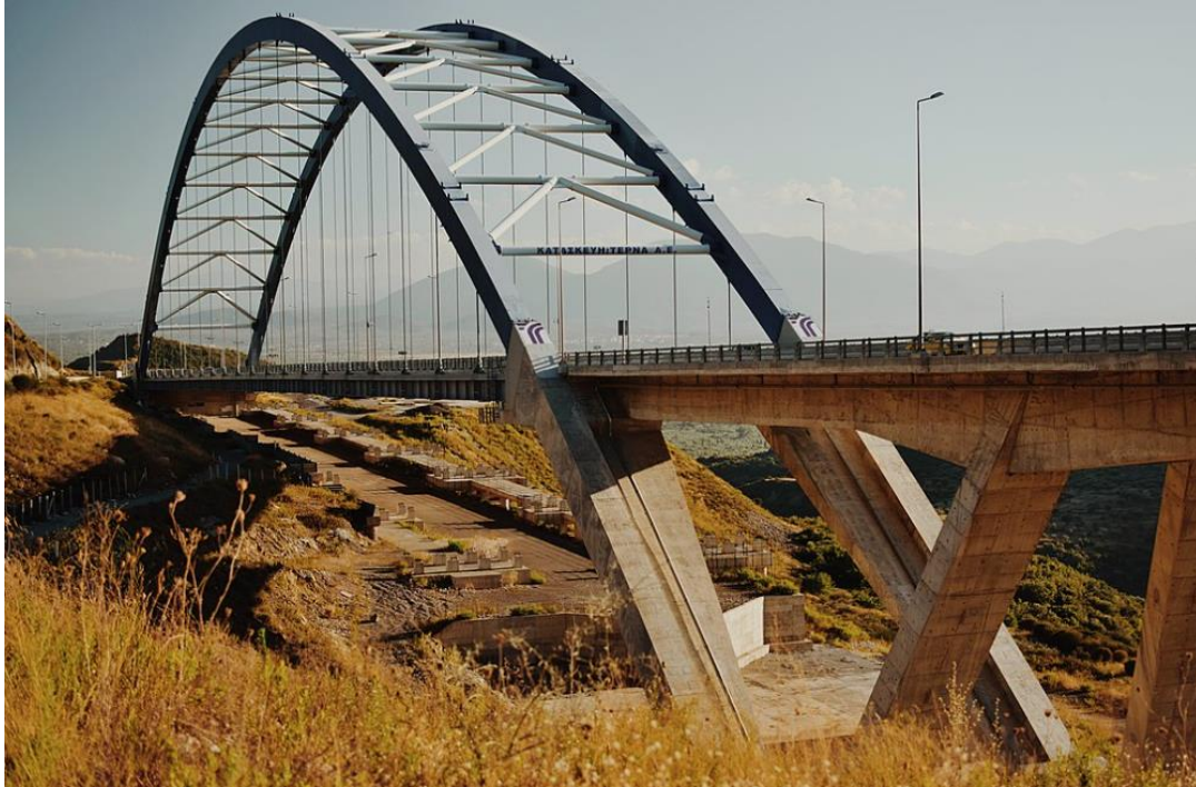
Σχήμα 1.4 : Τοξωτή Γέφυρα Τσακόνας
