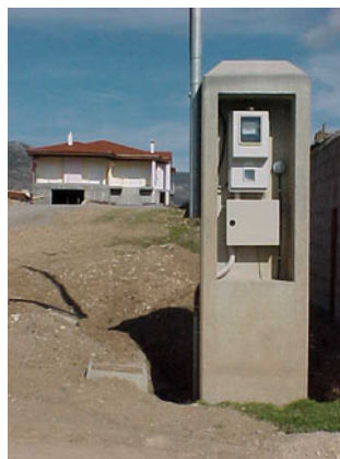
Σχήμα 1.3: Στύλος μετρητή ΔΕΗ.
