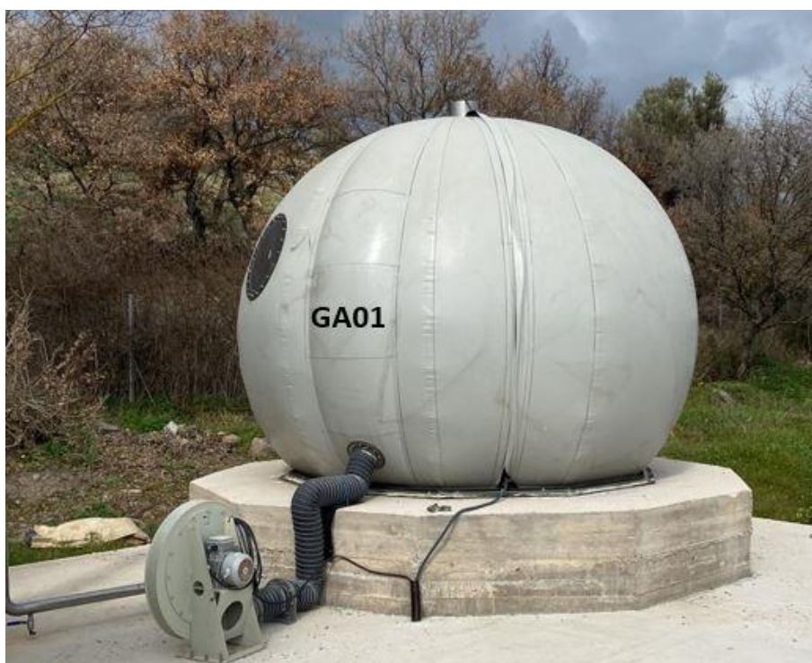
Σχήμα 15: Διάταξη μονάδας αντιδραστήρα Upflow Anaerobic Sludge Blanket (UASB) όπου, R01A & R01B, TA02, TA03 και GA01 είναι οι αντιδραστήρες, δεξαμενή εισόδου, δεξαμενή εξόδου και αεροφυλάκιο
