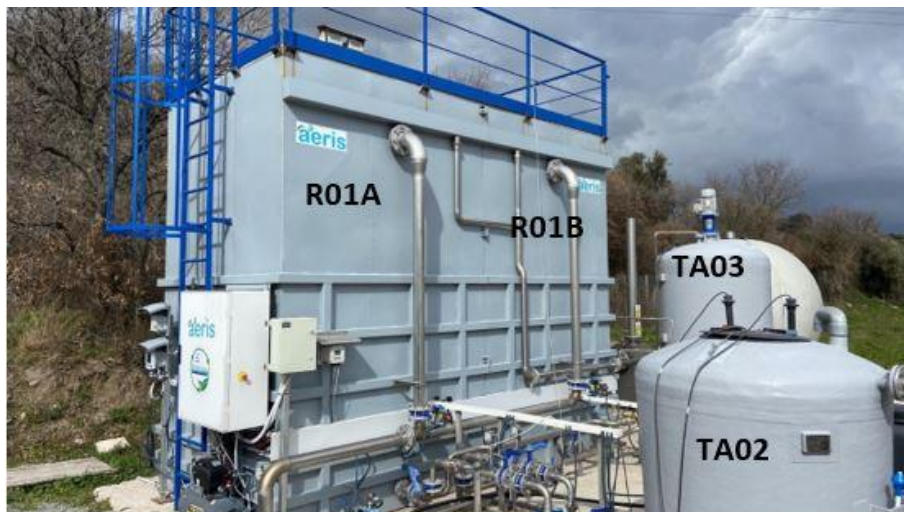
Σχήμα 15: Διάταξη μονάδας αντιδραστήρα Upflow Anaerobic Sludge Blanket (UASB) όπου, R01A & R01B, TA02, TA03 και GA01 είναι οι αντιδραστήρες, δεξαμενή εισόδου, δεξαμενή εξόδου και αεροφυλάκιο
