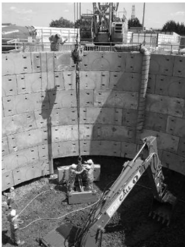
Εικόνα 1 Ανέγερση προκατασκευασμένων τμημάτων για Ref. National Grid (2015).
