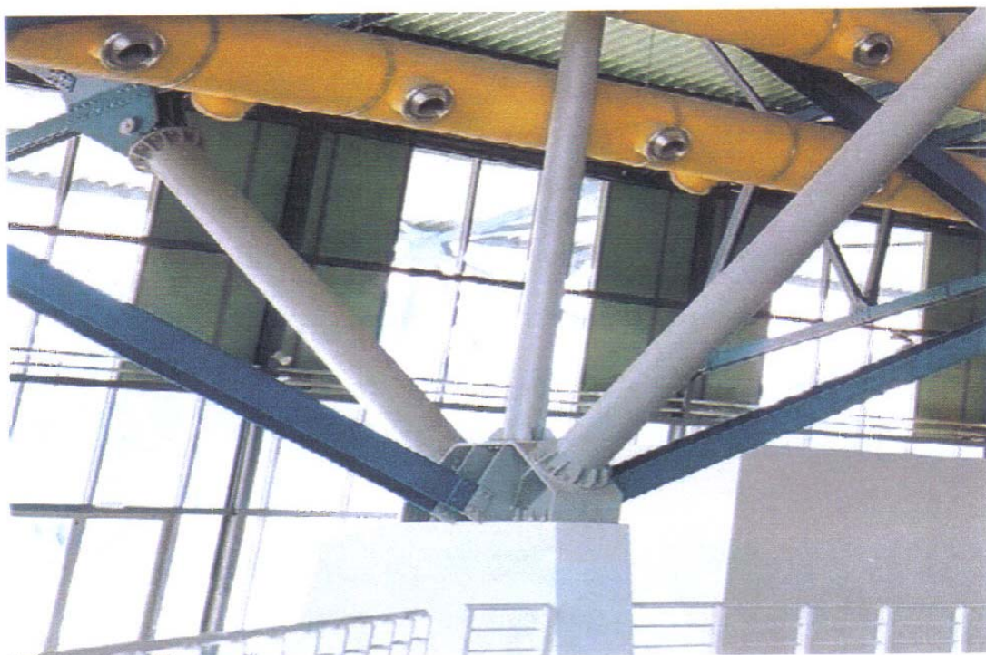
Σχήμα 7: Λεπτομέρεια στήριξης του χαλύβδινου υποστυλώματος
