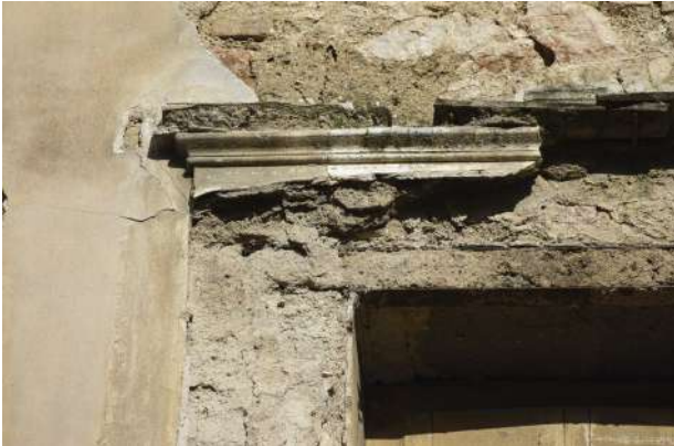
Νότια όψη, λεπτομέρεια κορνιζώματος στην μπαλκονόρτα του ορόφου
