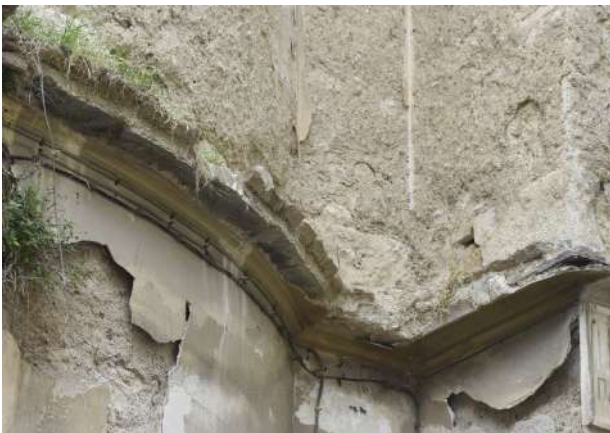
Ανατολική όψη, λεπτομέρεια γείσου στη θέση την ένωσης με τον πύργο
