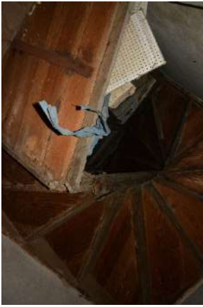
Στάθμη υπογείου - Λήψη προς τα πάνω
