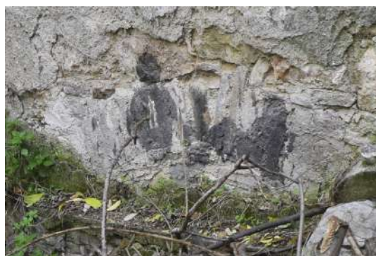
Τόξο στο δεξί τμήμα της βόρεια όψης της Β' φάσης στη στάθμη του ισογείου (βλ. βόρεια όψη)
