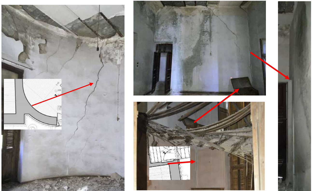
Πάνω στον πύργο στον όροφο στην ένωση με τον νότιο τοίχο και κάτω στους χώρους 2.02 και 3.02.
