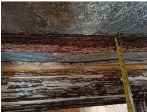
Δώμα Β' φάσης - πλάκα από οπλισμένο σκυρόδεμα
