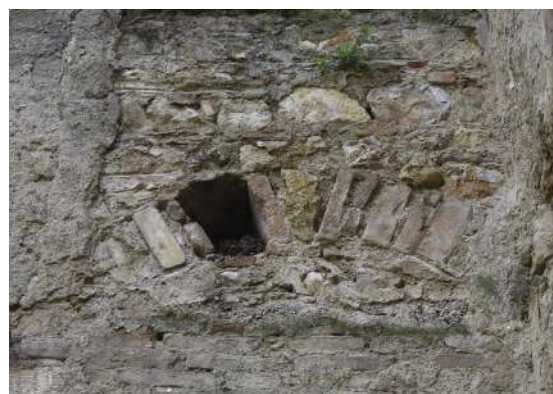
Τόξο στο δεξί τμήμα της βόρεια όψης της Β' φάσης στην ποδιά του παραθύρου (βλ. βόρεια όψη)
