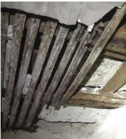
Ξύλινο με επικάλυψη τσιμέντου (Α' φάση)
