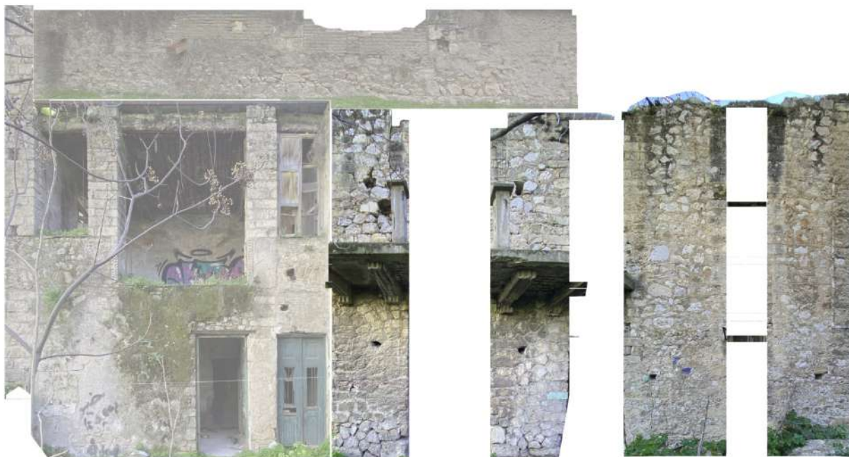
Βορεια άποψη της οικίας Καλλισπέρη, επεξεργασία εικόνων για την παραγωγή δυσδιάστατης απεικόνισης
