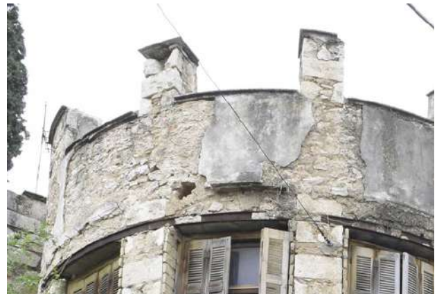
Πύργος, λεπτομέρεια επάλξεων
