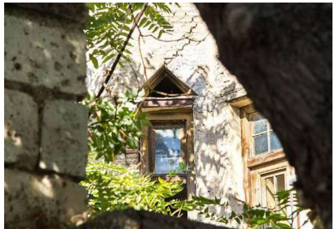
Δυτική όψη, ανακουφιστικό τρίγωνο στον όροφο
