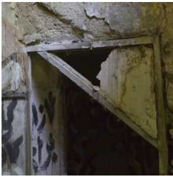
Ερμάριο μεταξύ χώρων 2.11 και 2.14
