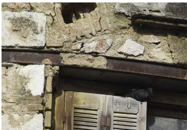
Πύργος, διπλά T σε όλο το πρέκι και κορνίζωμα μπαλκονόπορτας
