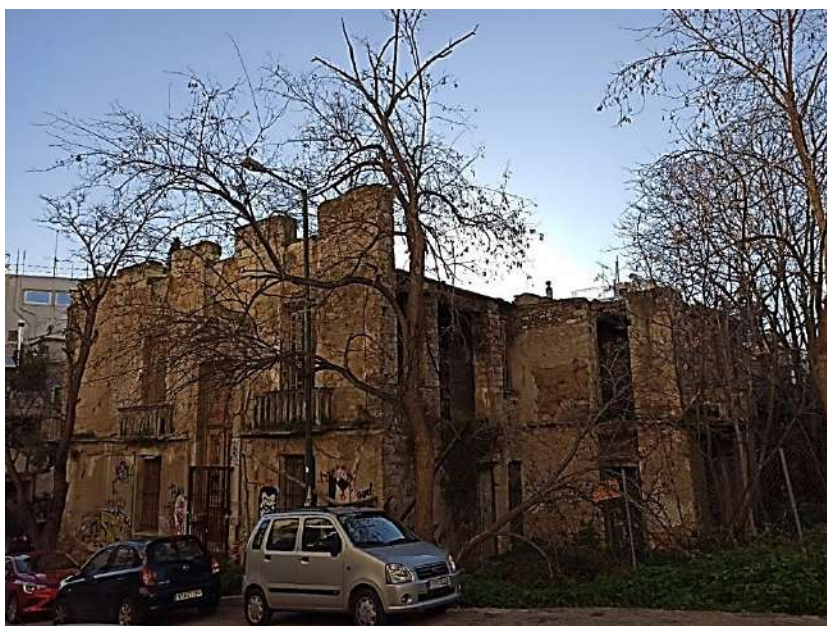
Βορειοανατολική άποψη της οικίας Καλλισπέρη
