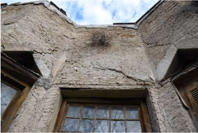
Δυτική όψη, εξώστης ορόφου
