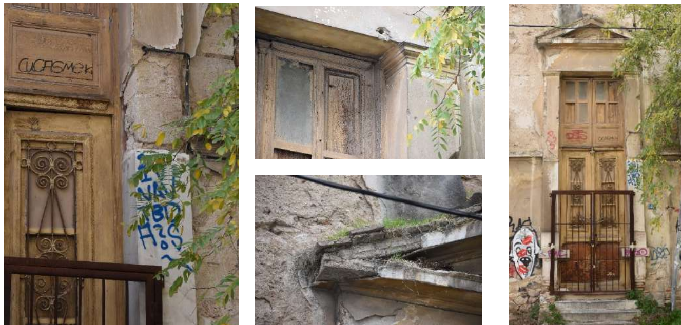
Αριστερά: Λεπτομέρειες εξώθυρας επί της οδού Παρθενώνος: Σιδεριά, Επίκρανο και αέτωμα Δεξιά: μετωπική φωτογραφία όψης
