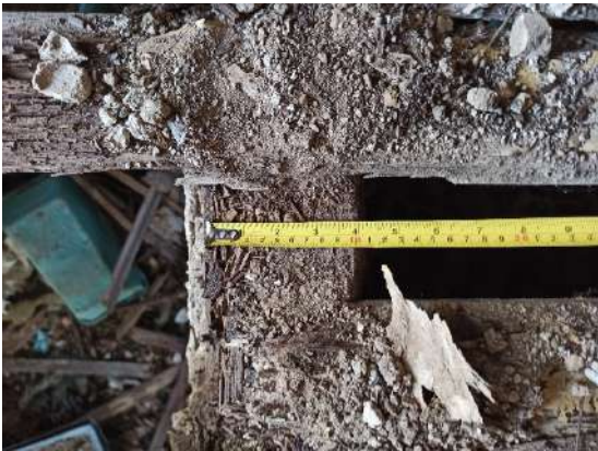
Λεπτομέρειες ξύλινου πατώματος. Αριστερά: μέτρηση πατόξυλου στο χώρο 2.06. Δεξιά: ταβάνι χώρου 2.10 και κάτω 1.05
