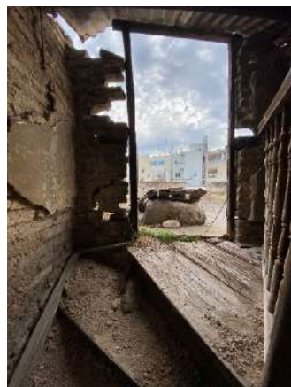
Στάθμη δώματος - Λήψη από μέσα
