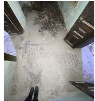
Αριστερά: λεπτομέρεια δαπέδου χώρου 3.08, Μέση: διαστάσεις πλακακιού, Δεξιά: χώρος 3.08
