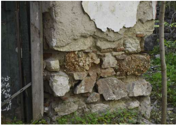
Εσωτερική βορειοανατολική γωνία: κροκαλοπαγές πέτρωμα, πωρόλιθος και ασβεστόλιθος και συμπλήρωση με κεραμικά στοιχεία
