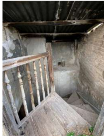
Στάθμη δώματος - Λήψη από έξω
