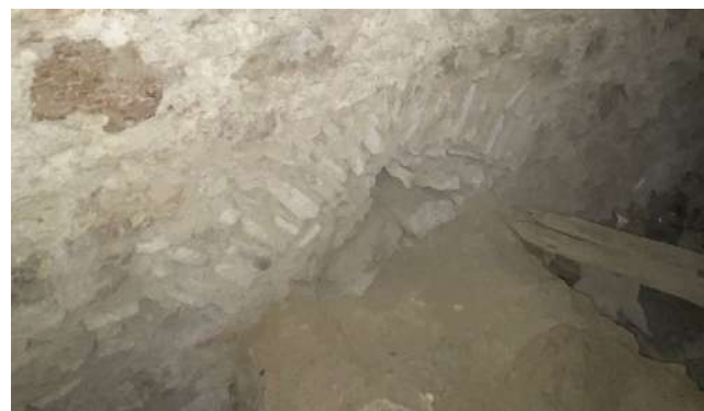
Τόξο πάνω από τον αποχετευτικό αγωγό στο υπόγειο, χώρος 1.07, δυτική πλευρά (βλ. κάτοψη υπογείου)
