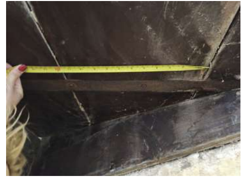
Στάθμη δώματος- Λάμα σύνδεσης ξύλινων σανίδων τελευταίου μεγάλου σκαλοπατιού
