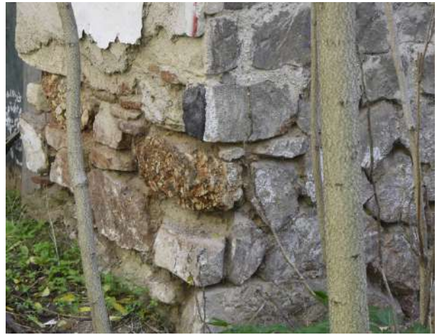
Εσωτερική βορειοανατολική γωνία: κροκαλοπαγές πέτρωμα, πωρόλιθος και ασβεστόλιθος και συμπλήρωση με κεραμικά στοιχεία
