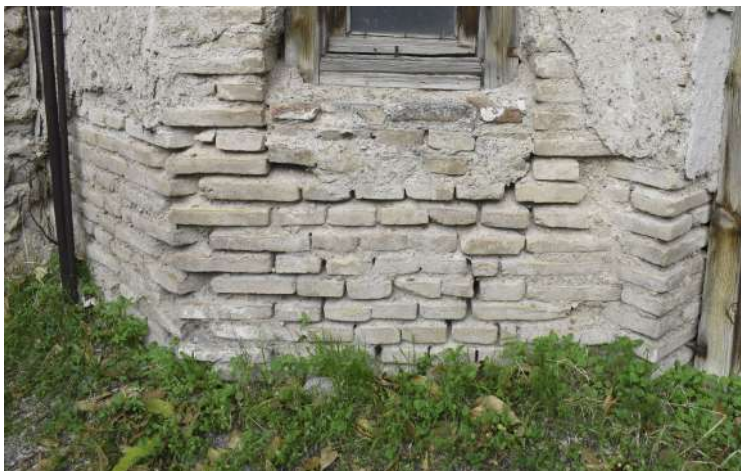
Λεπτομέρεια οπτοπλινθοδομής στη σύνδεση. Αμβλεία γωνία
