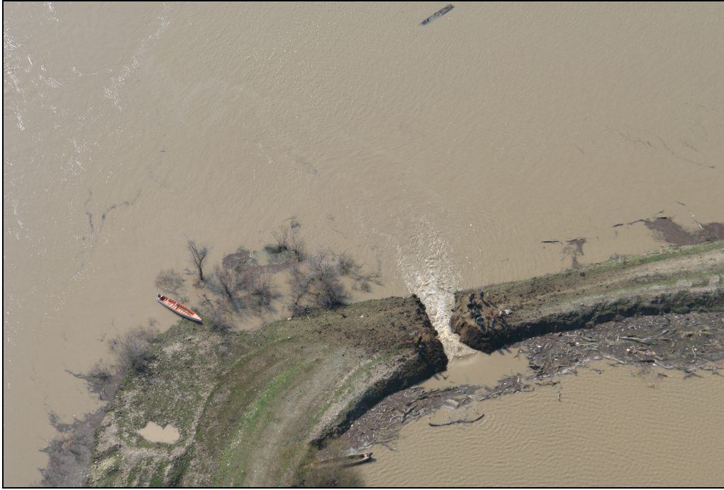
Εικόνα 4.3: Ανατίναξη τμήματος αναχώματος στα ελληνοτουρκικά σύνορα, με σκοπό την εκτόνωση του φαινομένου, Φεβρουάριος 2005.
