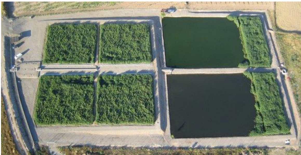
Εικόνα 2.1: Τεχνητοί Υγροβιότοποι πλήρους κλίμακας για την επεξεργασία υγρών αποβλήτων στην περιοχή Verdu στην Καταλονία της Ισπανίας (Τέσσερα (4) παράλληλα συστήματα Τεχνητών Υγροβιότοπων οριζόντιας υποεπιφανειακής ροής και δύο (2) Τεχνητοί Υγροβιότοποι επιφανειακής ροής) (Πηγή: Roger Samsó, 2014).
