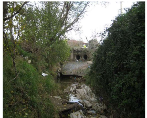
Εικόνα 3.3-10: Δίδυμος σωληνωτός οχετός Λ. Ιωνίας, Χ.Θ. 2+774.10, λήψη από την ανάντη κοίτη.
