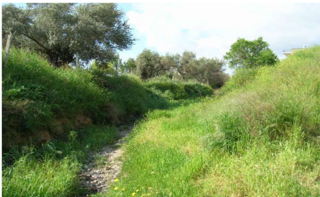
Εικόνα 3.3-1: Κοίτη ρέματος Αχαρνών κατάντη της Χ.Θ. 4+500 (λήψη προς τα κατάντη).
