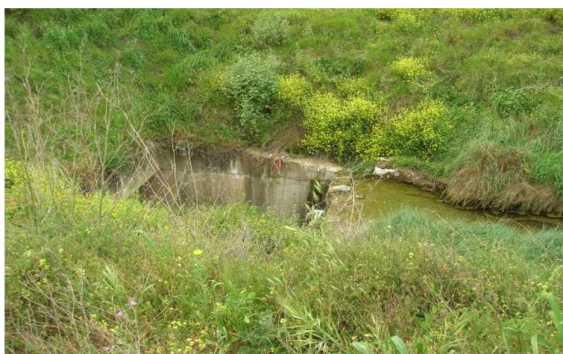
Εικόνα 3.3-17: Φρεάτιο εισόδου (καταβόθρα) στον κιβωτοειδή οχετό της οδού Σκρα, Χ.Θ. 0+500.
