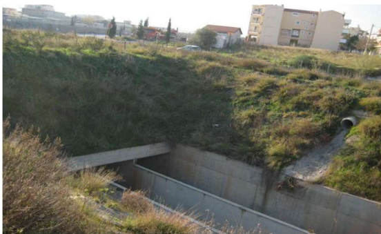
Εικόνα 3.3-11: Τρίδυμη ανοικτή ορθογωνική διατομή Αττικής οδού. Λήψη από την περιήφραξη της αριστερής όχθης.
