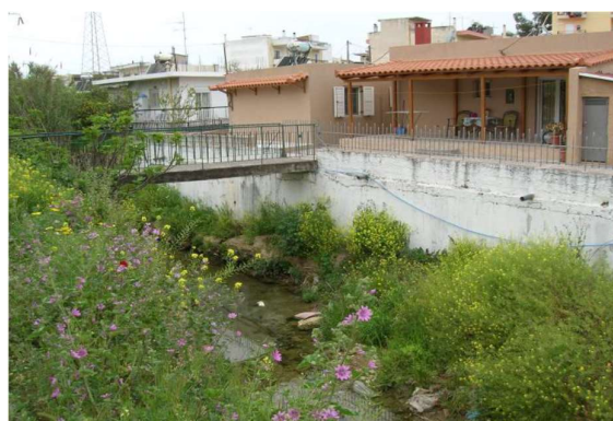
Εικόνα 3.3-14: Κατοικία στην αριστερή όχθη κατάντη 25ης Μαρτίου. Λήψη από τη δεξιά όχθη.
