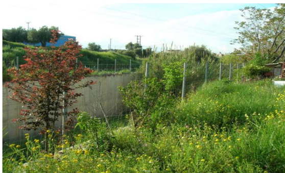
Εικόνα 3.3-12: Ανοικτή ορθογωνική διατομή κατάντη Αττικής Οδού. Λήψη από την αριστερή όχθη, Χ.Θ. 1+720.
