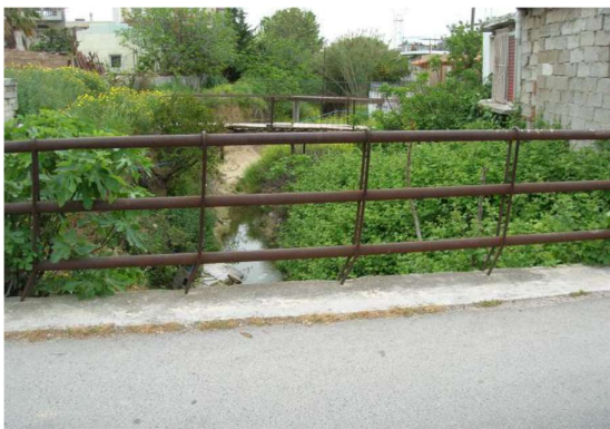
Εικόνα 3.3-13: Ρέμα Αχαρνών κατάντη οδού 25ης Μαρτίου, Χ.Θ. 1+355.80.
