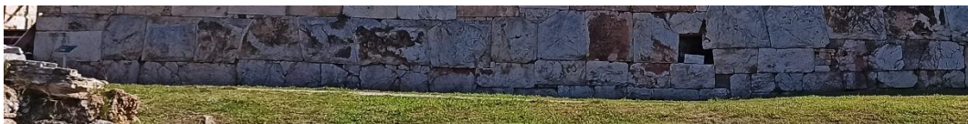
Εικόνα 35: Τμήμα τείχους της πόλης, το οποίο χρονολογείται περίπου στο 550 π.Χ.
