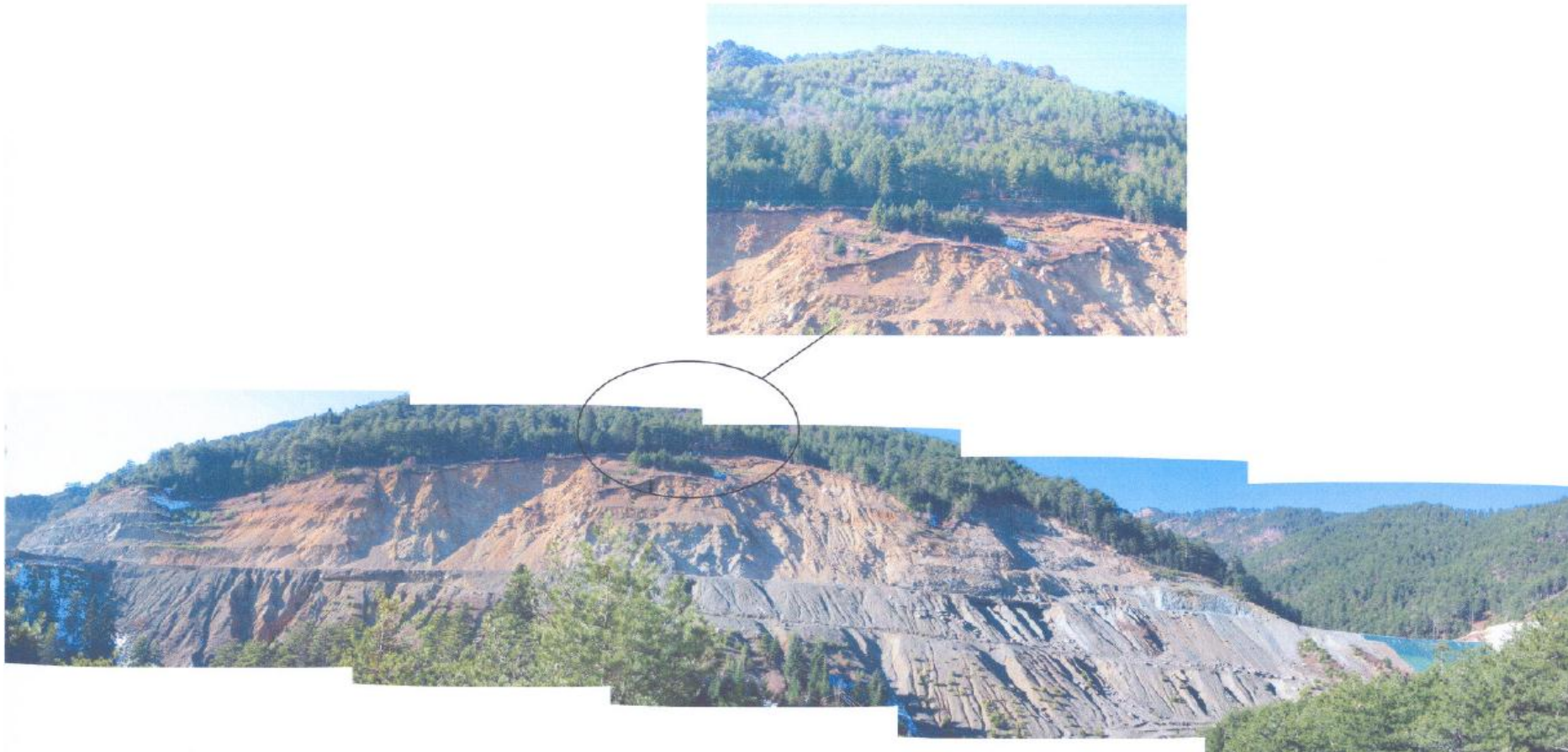
Εικόνα 4.10: Πανοραμική άποψη του Μεγάλου Ορύγματος και της κατάντη περιοχής δεξιά του άξονα του έργου. Διακρίνονται τα ίχνη των εκδηλωμένων αστοχιών και των χαραδροδιαβρώσεων. Στην άνω φωτογραφία διακρίνεται η ανάντη του χείλους του ορύγματος ολισθημένη περιοχή.
