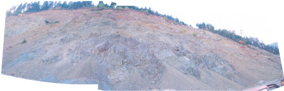
Εικόνα 4.14: Άποψη της περιοχής του Μεγάλου Ορύγματος (Χ.Θ. 18+500 έως 18+630). Διακρίνεται η βραχώμαζα στον πόδα του πρανούς, οι εδαφικές μάζες ανάντη και οι ριπιδιακοί κώνοι.
