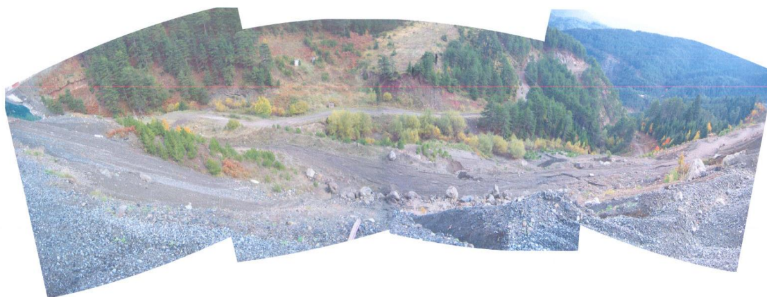
Εικόνα 4.19: Άποψη της περιοχής, δεξιά του δεξιού κλάδου. Παρατηρείται αριστερά το οπλισμένο επίχωμα, στο ρέμα κατάντη της εισόδου της σήραγγας Κωσταράκου, καθώς επίσης διακρίνονται και έντονες διαβρώσεις.
