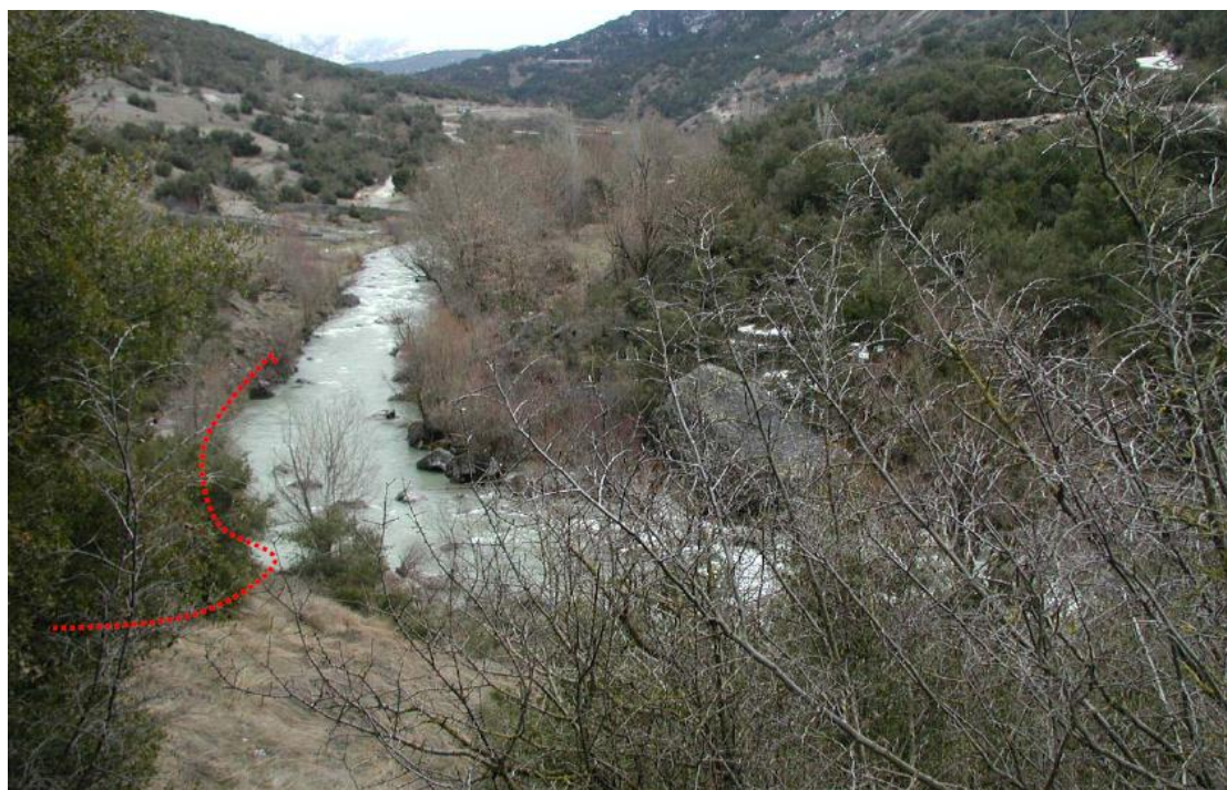
Εικόνα 4.8: Περιοχή κατασκευής του πόδα του οπλισμένου επιχώματος, στο τμήμα 2.4 της Εγνατίας Οδού, στην περιοχή Β (υποπεριοχή Β2).
