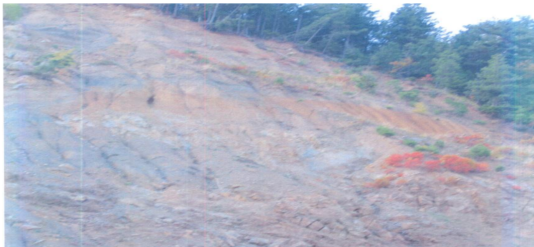
Εικόνα 4.15: Άποψη αργιλοποιημένης ζώνης μεγάλου πάχους. Διακρίνονται έντονες αστάθειες, ίχνη εδαφικών αστοχιών και πτώσεις δέντρων.
