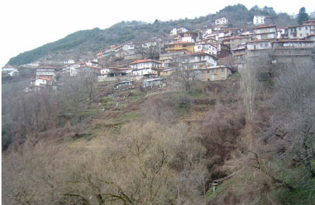
Εικόνα 3.13: Άποψη του πρανούς. Η κατολίσθηση σημειώθηκε στα όρια του οικισμού. Στο πρανές παρατηρούνται υψίπεδα (σκαλοπάτια) που αποτελούν ένδειξη παλαιότερων κατολισθήσεων.
