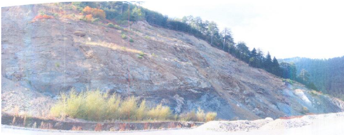
Εικόνα 4.13: Άποψη του Μεγάλου Ορύγματος, όπου διακρίνονται στον πόδα του πρανούς υπερβασικοί σχηματισμοί, αποτελούμενοι από οφιολιθικά μίγματα με ράκη ασβεστολίθων και σερπεντινίτες σε εναλλαγές.
