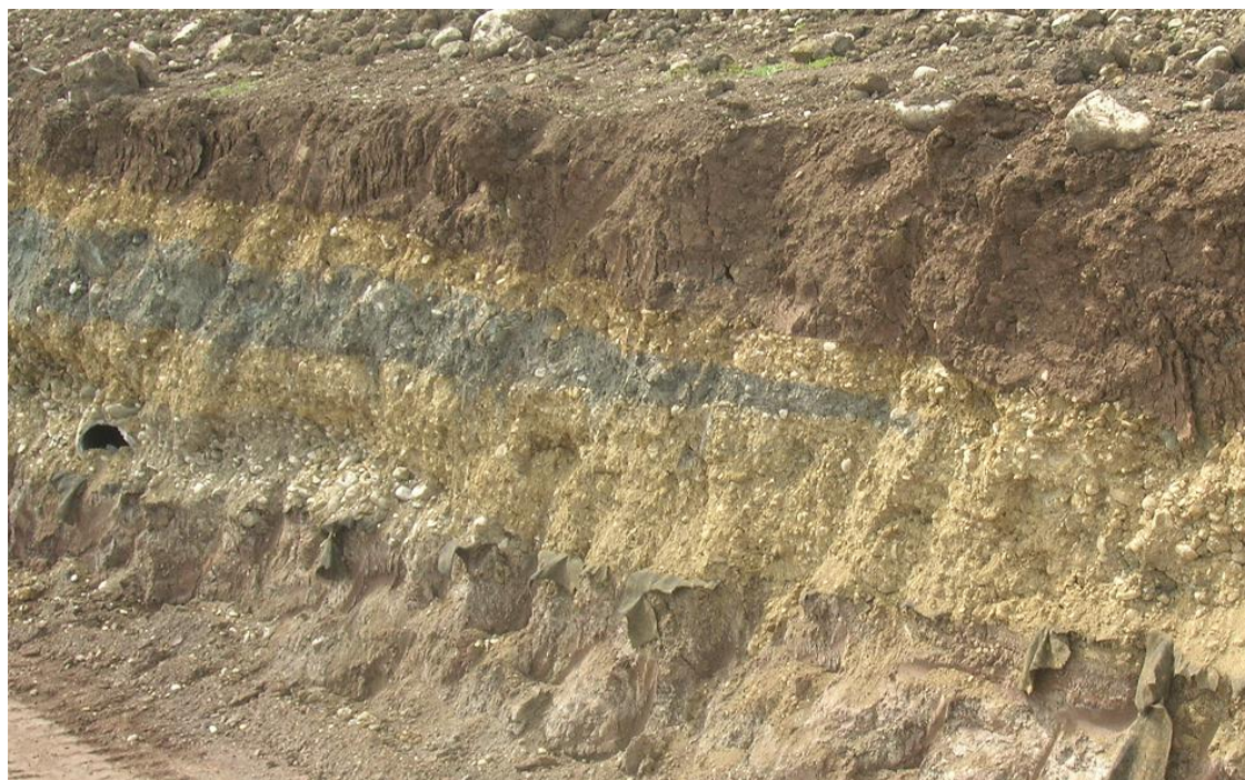
Εικόνα 4.26: Άποψη των ζωνών εναλλαγής των γεωϋλικών του επιχώματος: αργιλοϊλυώδεις-χαλικώδεις άμμοι, σκληρές άργιλοι με άμμο και κροκαλοπαγή.
