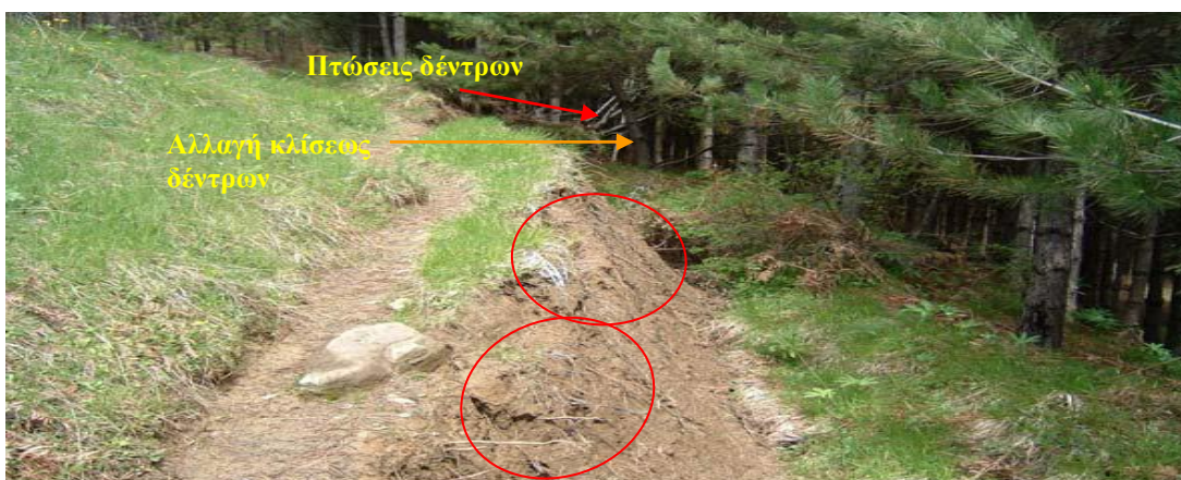
Εικόνα 3.18: Εδαφικές ρωγμές στην πευκόφυτη πλαγιά ανάντη του συγκροτήματος.
