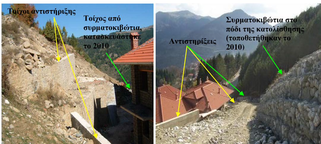
Εικόνα 3.19: Συνδυασμένη αντιστήριξη από οπλισμένο σκυρόδεμα και συρματοκιβώτια στον πόδα της κατολίσθησης.
