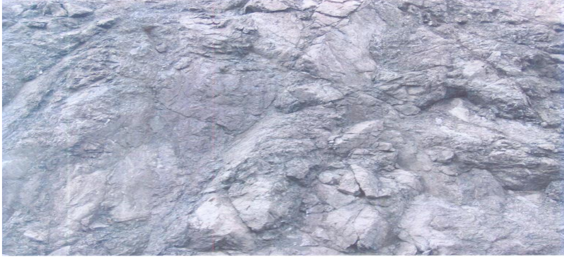
Εικόνα 4.12: Άποψη της βασικής οφιολιθικής βραχώμαζας, αριστερά του αριστερού κλάδου, όπου διακρίνονται η καλή ποιότητα της βραχώμαζας και τα ίχνη των εκδηλωμένων δομικών αστοχιών.
