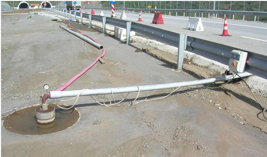
Εικόνα 4.31: Λειτουργία φρεάτων άντλησης για τη διατήρηση χαμηλής στάθμης των υπογείων νερών.
