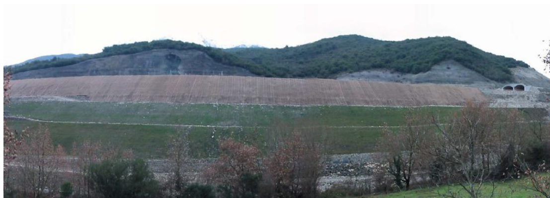
Εικόνα 4.9: Φωτογραφία της κατολίθησης της Περιοχής Δ3 μετά τα έργα σταθεροποίησης και του κατασκευασμένου τεχνικού (Σ2) του τμήματος 3.1 (Μ. Περιστέρι-Ανθοχώρι) της Εγνατίας Οδού. Στο βάθος αριστερά διακρίνεται η είσοδος της σήραγγας Ανθοχωρίου.
