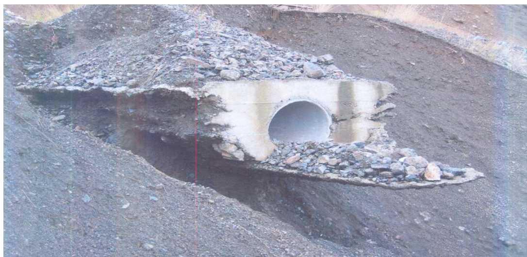
Εικόνα 4.21: Σωληνωτός οχετός (έξοδος) από τις υδραυλικές υποσκαφές στις τεχνητές επιχώσεις.
