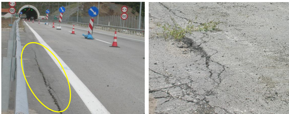
Εικόνα 4.27: Μετακινήσεις στο οδόστρωμα του δεξιού κλάδου (περίπου 30 cm και βυθίσεις 20-30 cm περίπου) και ρωγμές στην κεντρική νησίδα (Οκτώβριος, 2010).
