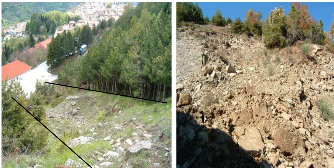
Εικόνα 3.17: Άποψη της κατολίσθησης ανάντη του συγκροτήματος Τσομπίκου. Τα μετακινούμενα υλικά κατευθύνονται προς το συγκρότημα.
