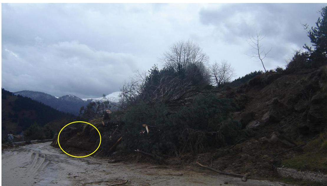
Εικόνα 3.26: Άποψη κατολίσθησης που εκδηλώθηκε ανάντη του εθνικού δρόμου. Τα μετακινούμενα υλικά κατέληξαν στον εθνικό δρόμο. Διακρίνεται η πτώση μεγάλων δέντρων και ογκόλιθοι ψαμμιτών.
