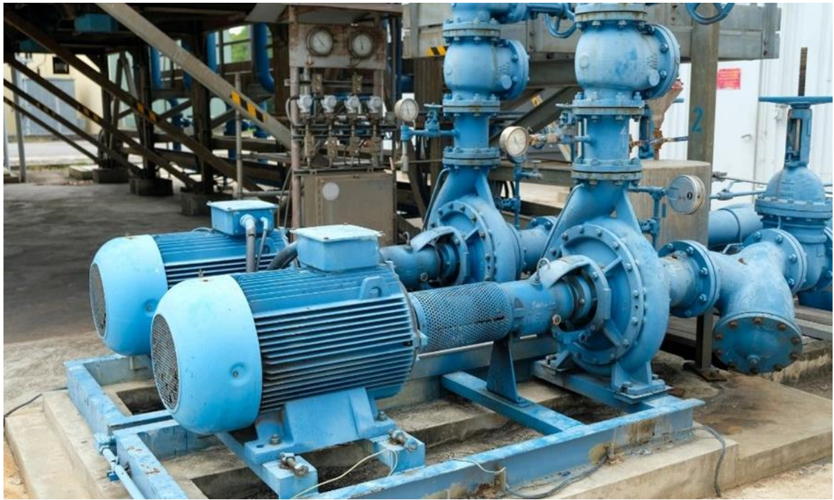
Εικόνα 4: Εξωτερική όψη μιας φυγοκεντρικής αντλίας [11] .
