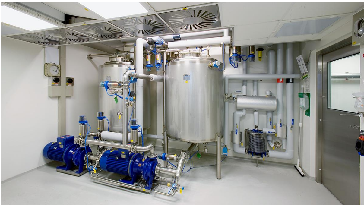
Εικόνα 12: Παράδειγμα εγκατάστασης CIP [43] .
