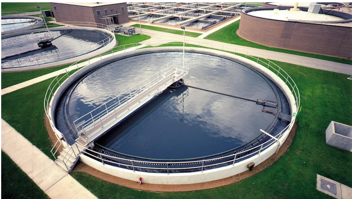
Εικόνα 13: Δεξαμενή πρώτου σταδίου επεξεργασίας υγρών αποβλήτων [45] .
