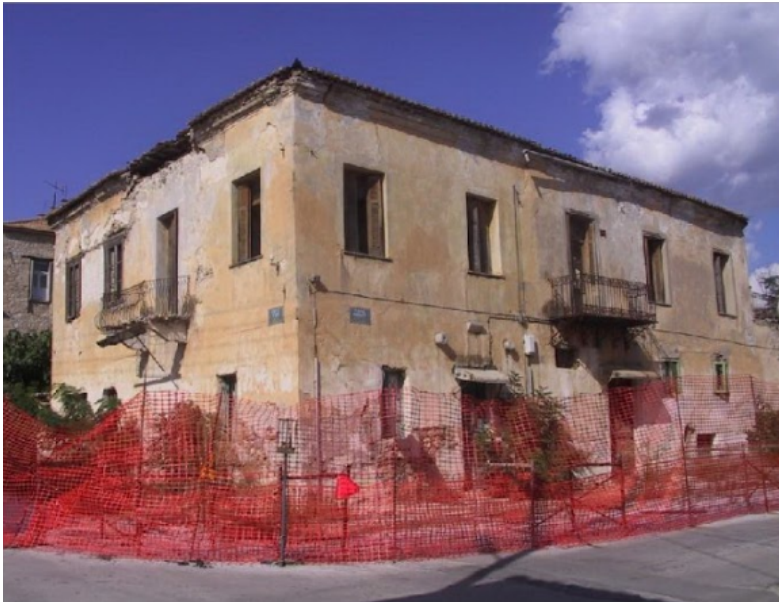
Εικ.3.2.5: Χαρακτηριστική κατοικία της Σπάρτης του 19ου αιώνα -Οικία Τζιβανοπούλου, λίγο πριν κατεδαφιστεί Πηγή Αρχείο Γιαξόγλου
