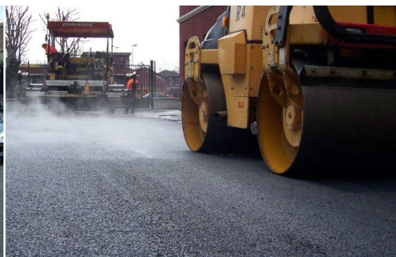
Εικόνα 3.5: Ψεκασμός και τελική συμπίεση στη «ζεστή μέθοδο» [13]
