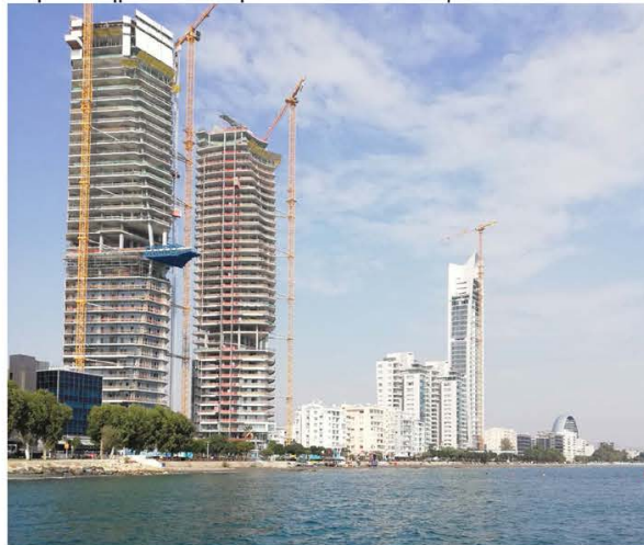
Εικόνα 9 Ψηλά Κτήρια στο Παράκτιο Μέτωπο Λεμεσού
