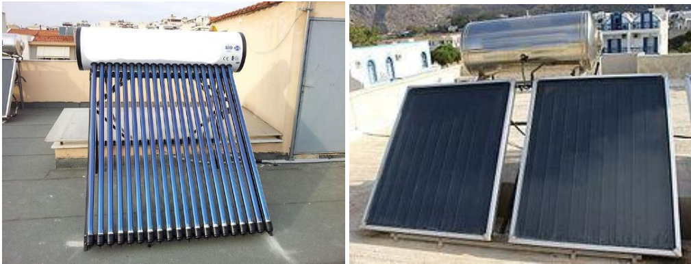
Εικόνα 5: Χαμηλής θερμοκρασίας Ηλιακός θερμοσίφωνας με συλλέκτες κενού, αριστερά και συλλέκτες επίπεδης επιφάνειας δεξιά.
