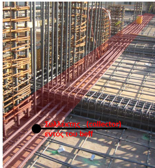
Εικόνα 2-14: Παράδειγμα τοποθέτησης συλλέκτη (collector) εντός του beff. (από Farzad Naeim, John A. Martin & Associates, Inc.)
