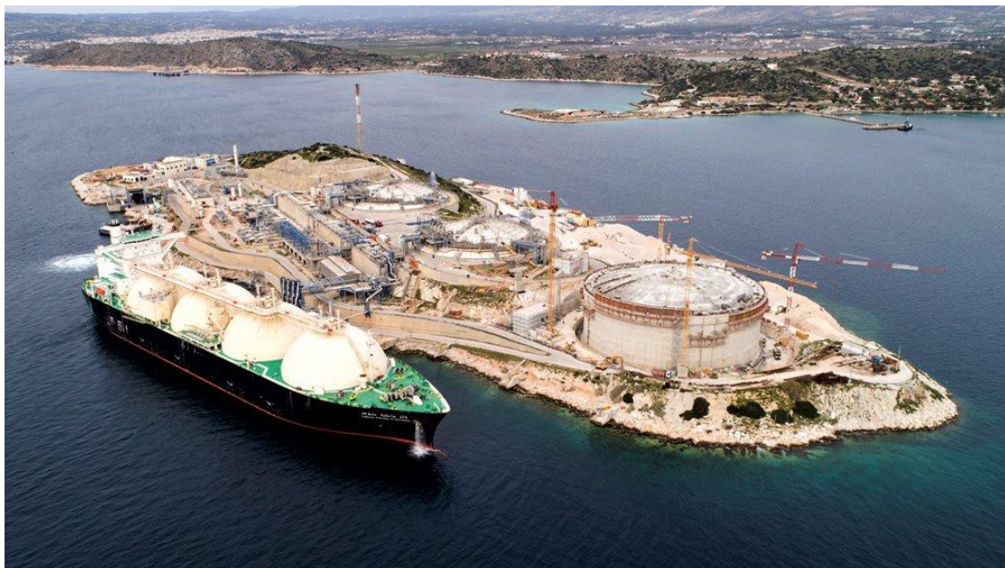
Σχήμα 4.2: Η νήσος Ρεβυθούσα σε διαδικασία τροφοδοσίας από πλοίο με LNG
