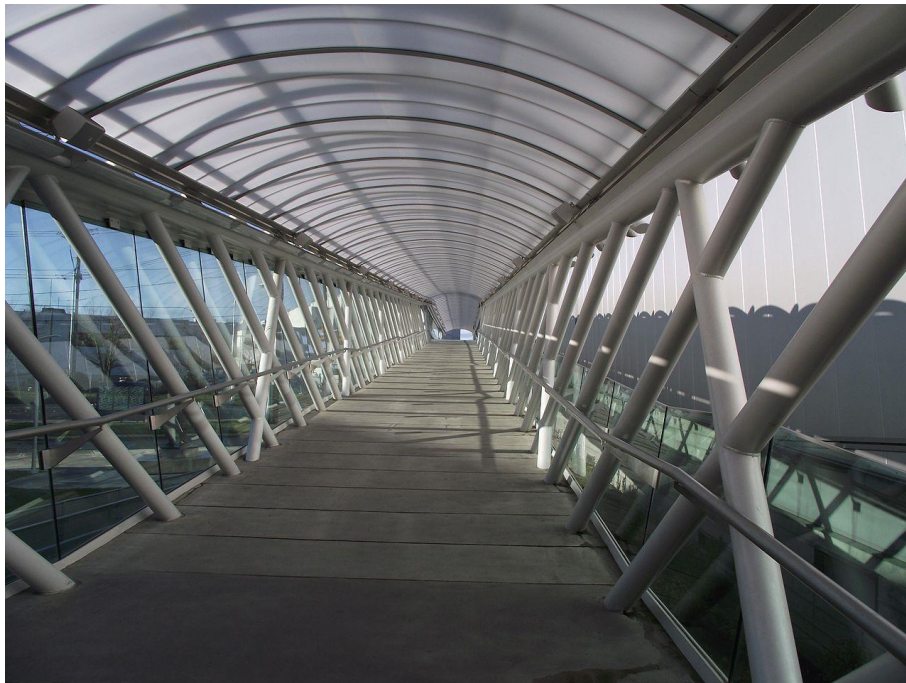
Σχήμα 1-3: Γέφυρα T. Evans Wyckoff στο Σιάτλ, ΗΠΑ
