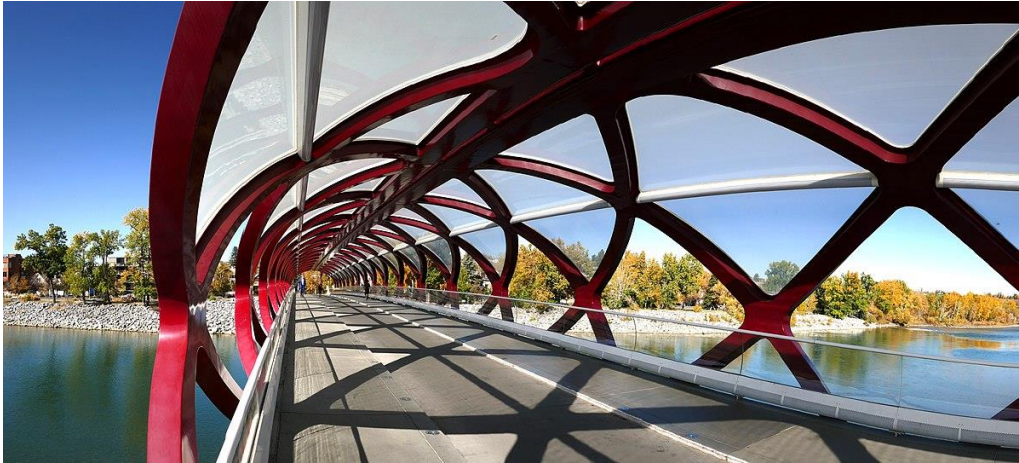
Σχήμα 1-2: Peace Bridge στο Κάλγκαρι, Καναδάς
