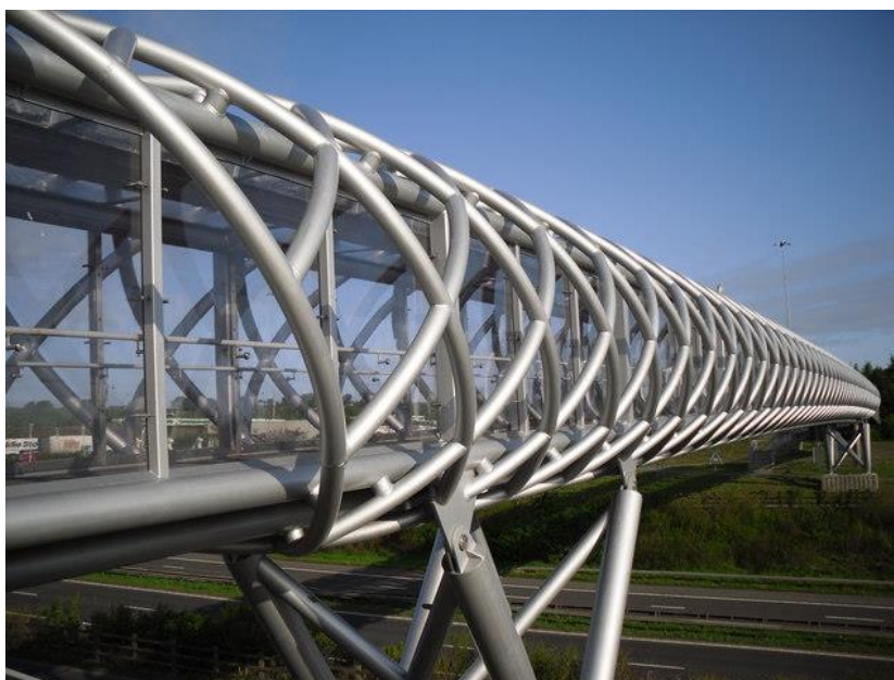
Σχήμα 1-1: Πεζογέφυρα M8 Harthill μεταξύ Γλασκώβης και Εδιμβούργου, Σκωτία
