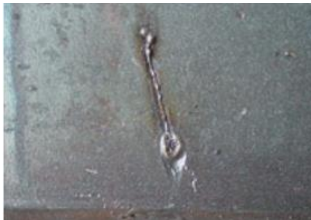
Εικόνα 6: Σφάλμα ανάμματος τόξου
